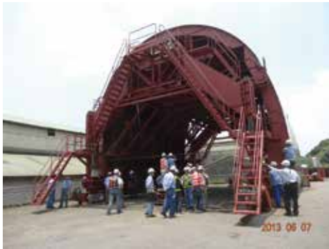
● 鋼模假組立現場查驗
