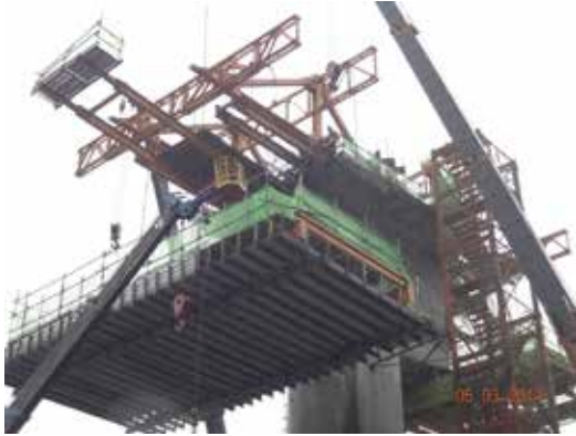
● P2N懸臂工作車底板及防護平台吊裝
