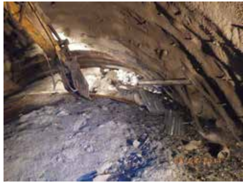
● 土方及砂包回填完成
