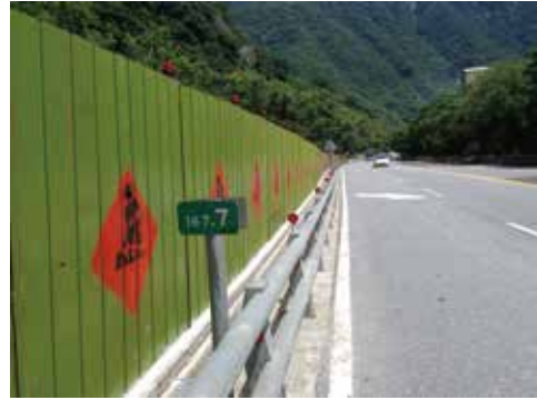
● 第一階段交維圍籬組立情形
