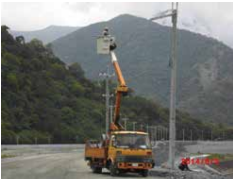
● 台電電桿臨遷及架線
