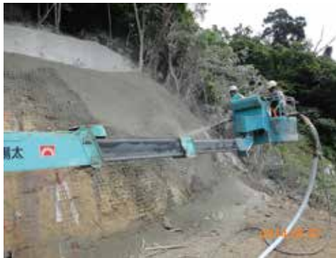
● 北口橫坑工區洞口邊坡噴凝土作業中
