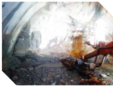
● 鑽堡機鑽設預裂孔
