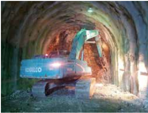
● 機械開挖及修挖
