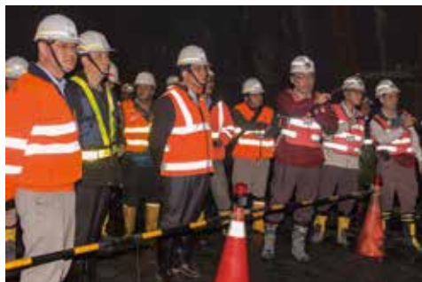
● 局長視察谷風隧道施工概況
