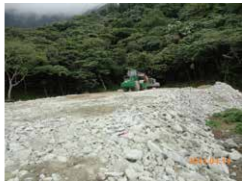
● 北口橫坑工區施工便道路堤填築
