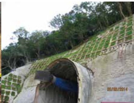
● 中央導坑洞口假隧道
