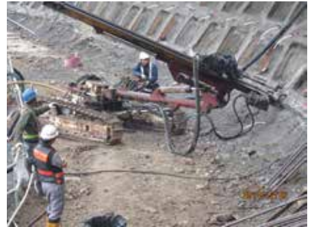
● 自由型格梁岩栓打設作業
