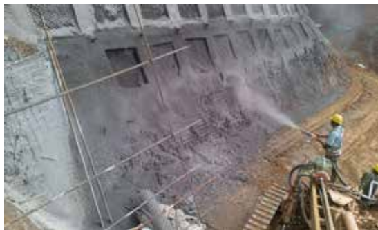
● 自由型格梁及邊坡噴凝土
