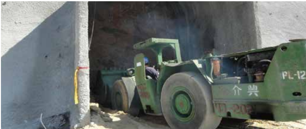
● 北口橫坑工區-開挖出渣
