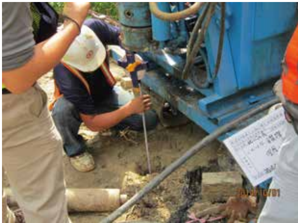
● 補充地質鑽探鑽孔作業
