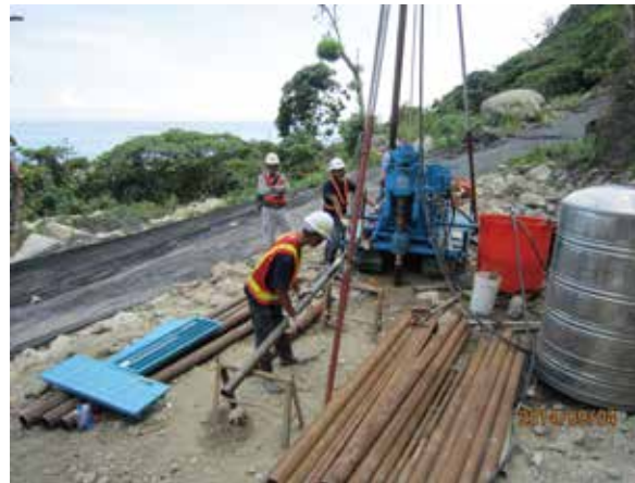
● 補充地質鑽探孔深量測
