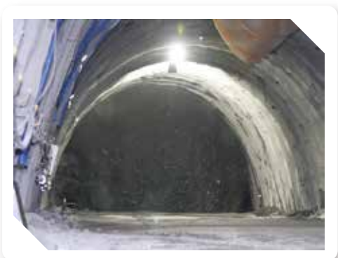
● NS3.NN5隧道爆破後貫通
