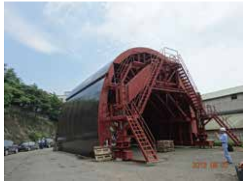
● 鋼模假組立現場查驗
