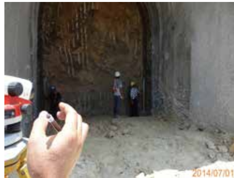
● 北口橫坑工區-R02輪鋼支保組立高程測量
