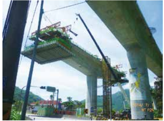
● P2N懸臂工作車推進位於台9線道路上方
