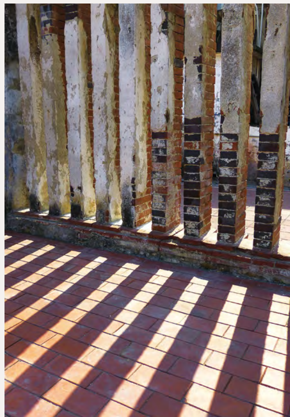
照壁左右分別設置9支直櫺磚窗。
