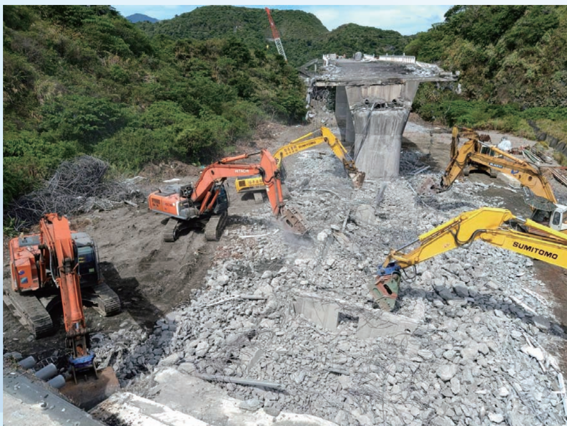
東岸機械拆除工法 - 橋面機械拆除
