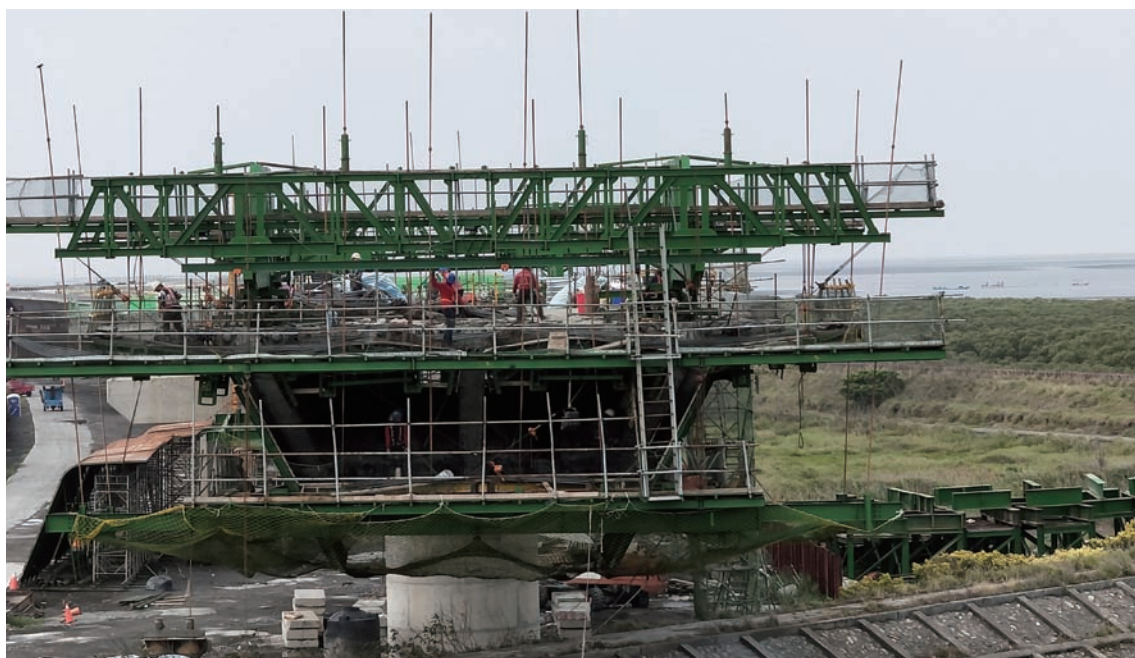
上航式錨定懸臂工作車示意圖
