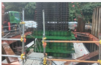
(8) 墩柱鋼筋綁紮及模板組立
