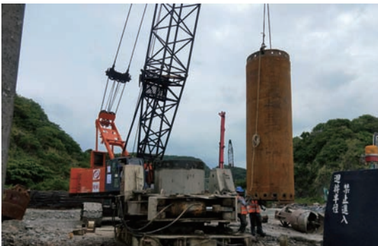
3. 基樁鉗掘套管安裝
