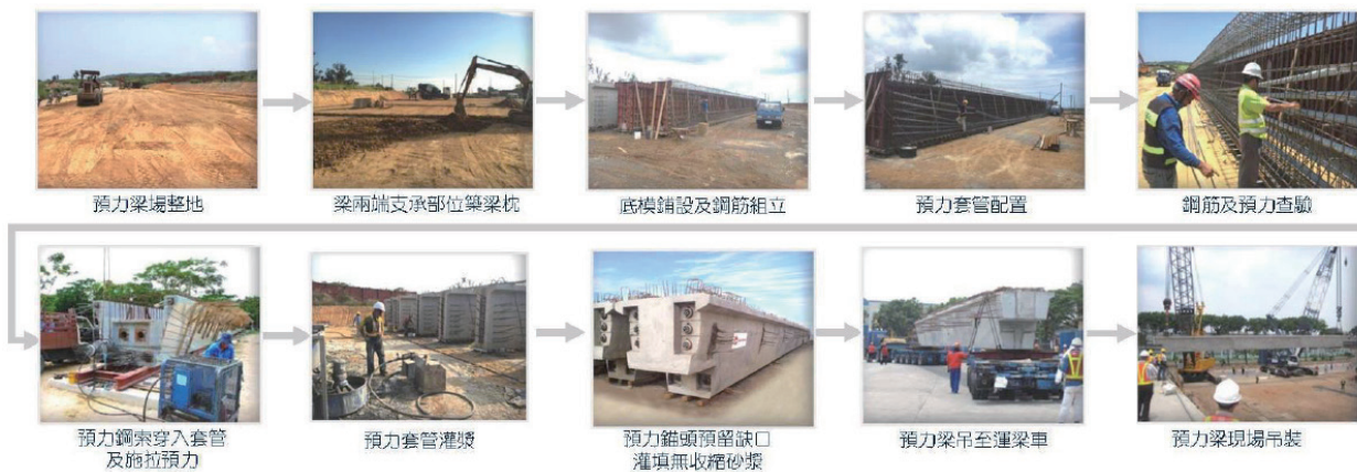
圖 2.2.3.5-3 U 型梁施工製造及吊裝示意圖
