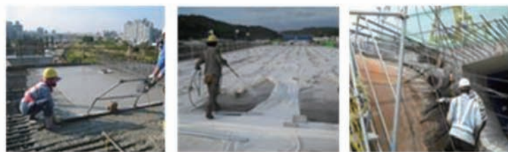
頂版混凝土澆置 (1天)
