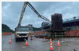
(9) 墩柱混凝土澆置
