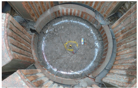
2. 基樁搖管機定位
