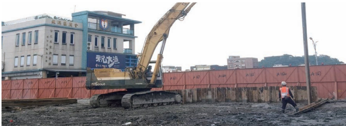
基礎施工工程 / 鋼板樁打設
