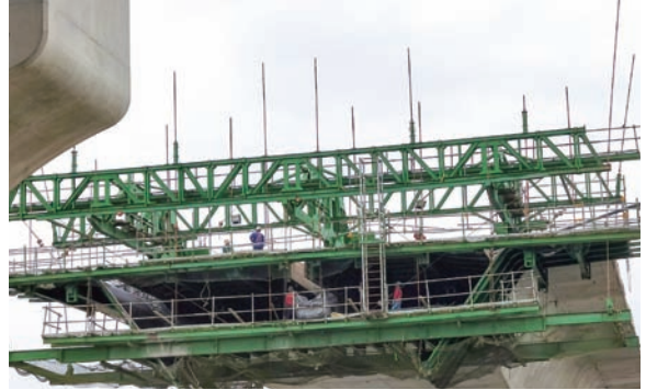
上航式錨定懸臂工作車示意圖
