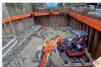
(3) 基樁劣質混凝土打除及高程檢測
