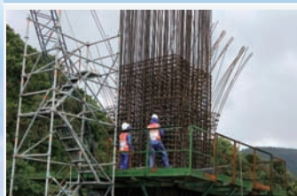
(10) 帽梁鋼筋綁紮及模板組立
