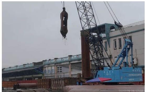
4. 基樁鉗掘取土
