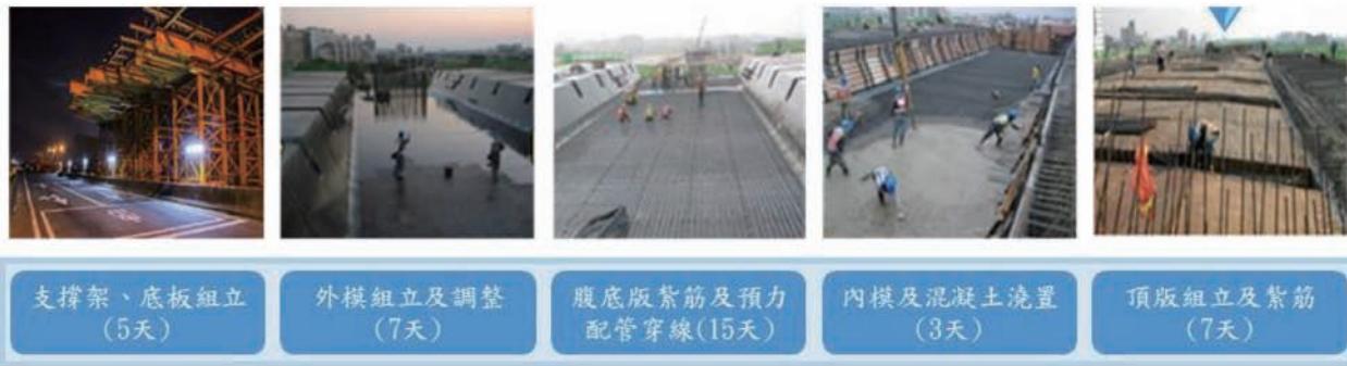
圖 2.2.3.4-1 場鑄工法施順序示意圖
