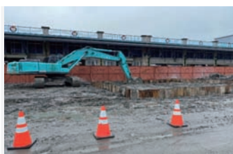
(2) 基礎第一層開挖
