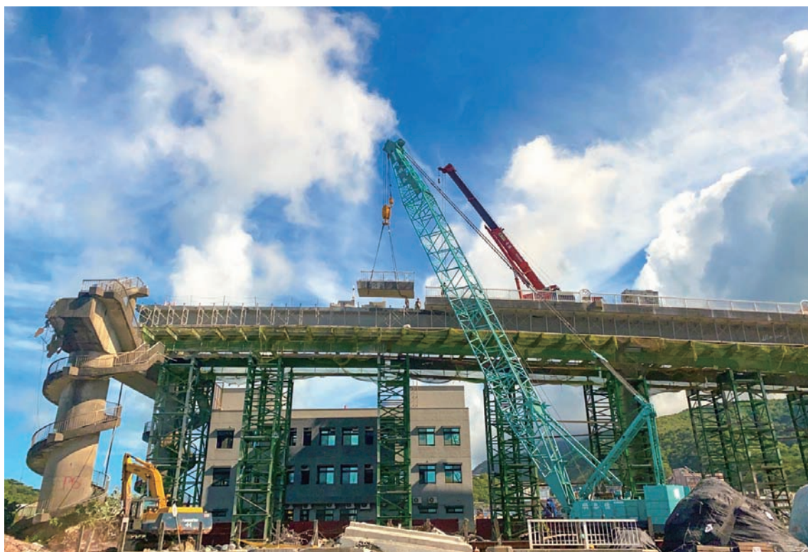
西岸橋面外翼版吊放至地面
