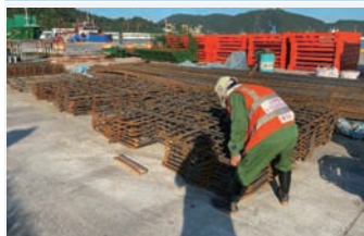
(4) 柱鋼筋地面預組
