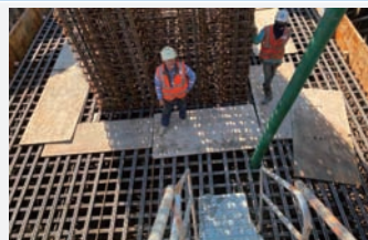
(6) 基礎混凝土澆置
