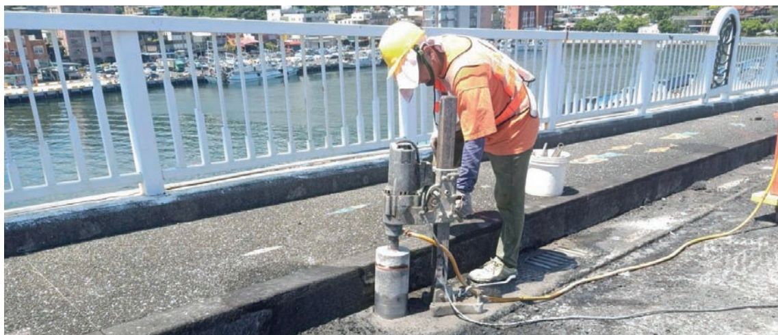
切割吊點鑽孔
