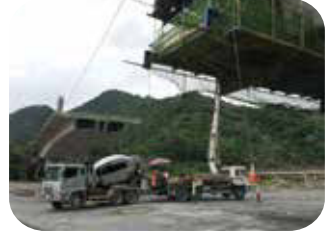
3.P2節塊澆置混凝土
