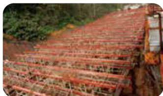
4.組立鷹架組及排設
