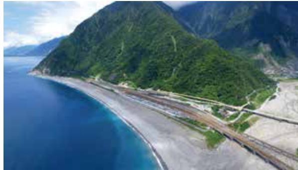
• 仁水隧道北口山勢地形
