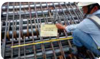
10. 鋼筋及套管查驗
