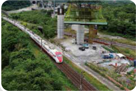
• 東澳北溪河川橋跨北迴鐵路高風險作業
