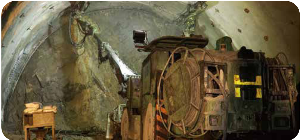
• 中仁隧道施作
