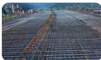
6.混凝土澆置前置作業
