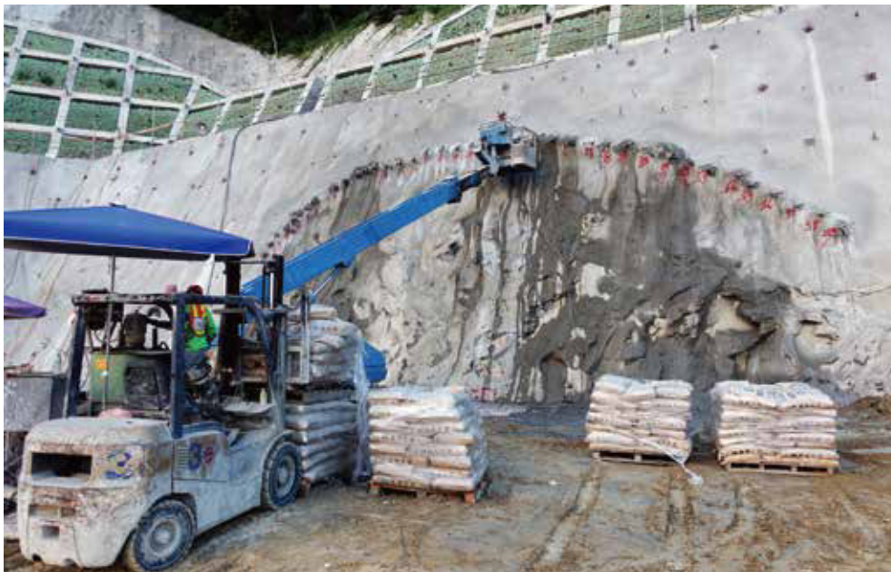
• 中仁隧道北口施作
