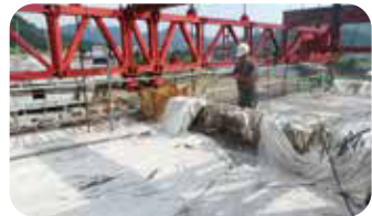
3. 混凝土澆置後養護
