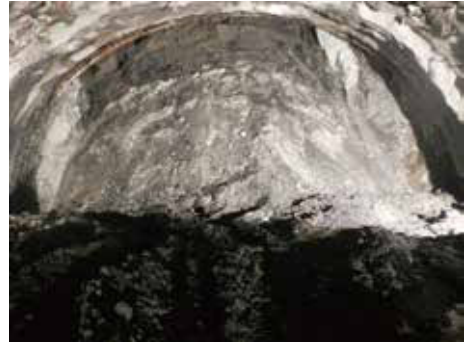
• 6k+155.4 (T552) 兩側受橫移斷層影響及層間剪裂帶影響，造成開挖面破碎夾剪裂泥
