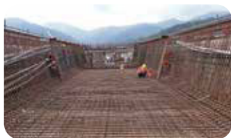
7.底腹板鋼筋綁紮預力套管安裝
