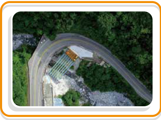
• 仁水隧道南口鋼便橋施作情形
