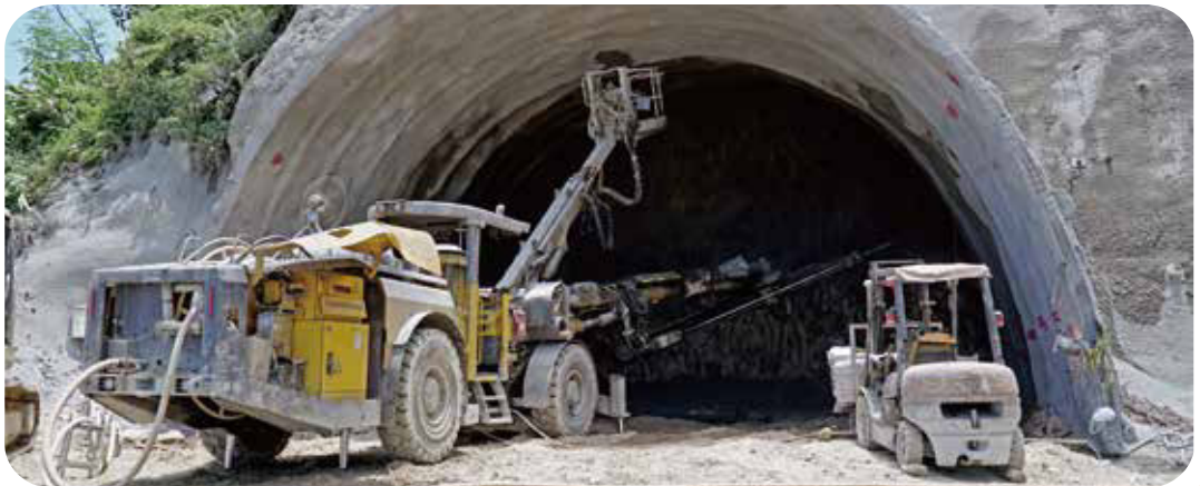
• 中仁隧道北口施作
