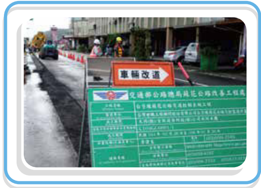
• 於蘇港路進行土木管道工程施作
