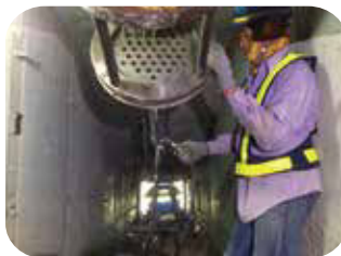
11.對每根外置預力鋼索由下端施拉預力
