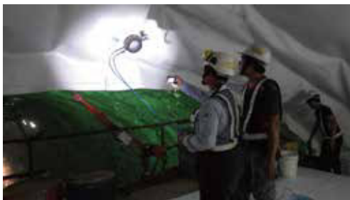
• 主隧道防水膜真空罩檢驗
