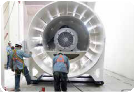
• 東澳隧道南口機房軸流風機安裝定位
