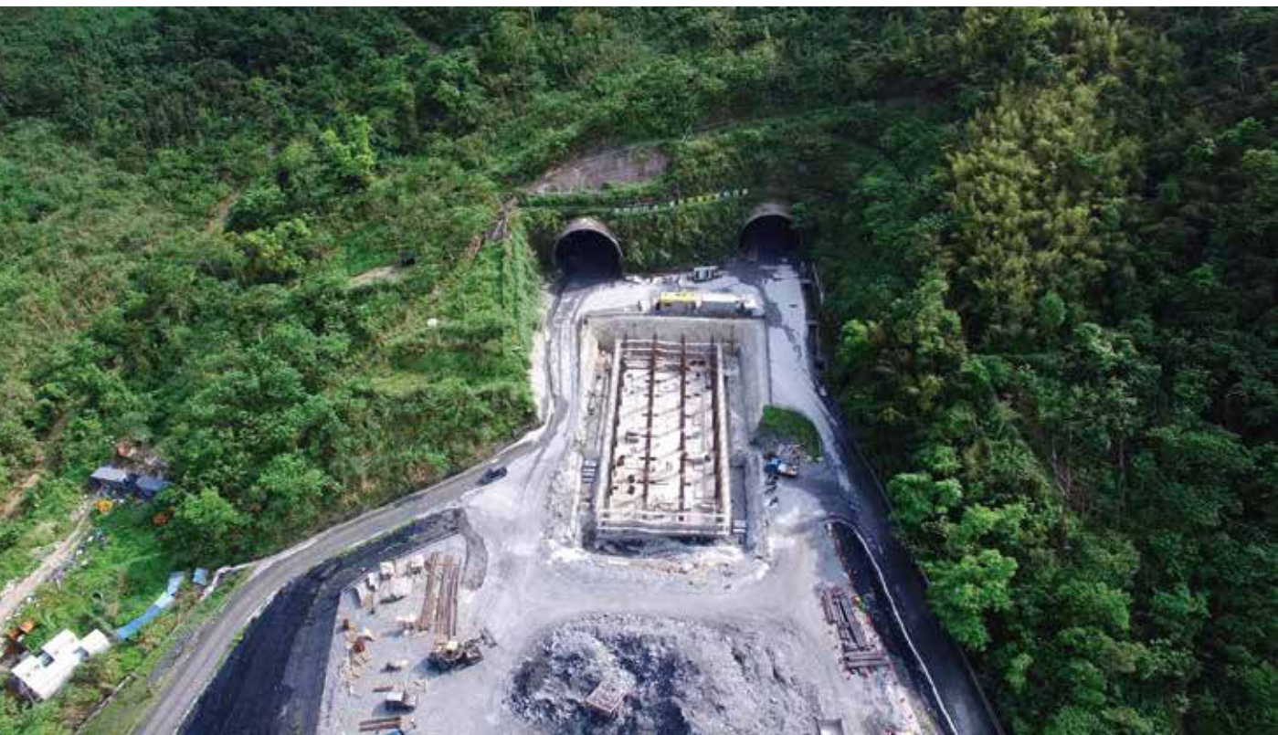
• 觀音隧道北口空拍
