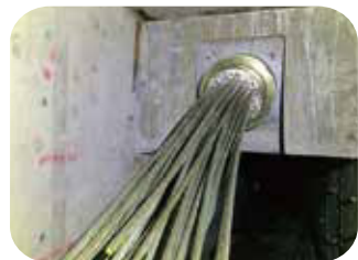
12.完成安裝之外置預力錨碇端
