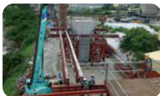
3.架設橫縱梁及主桁架
