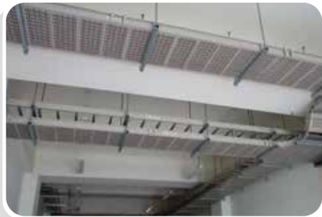
• 東澳隧道南口機房電纜架安裝
