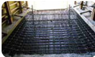
8. 底板鋼筋綁紮
