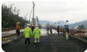
10.頂板鋼筋綁紮及混凝土澆置
