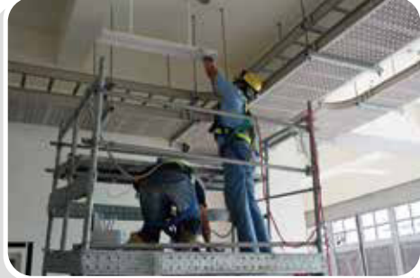
• 東澳隧道南口機房燈具安裝
