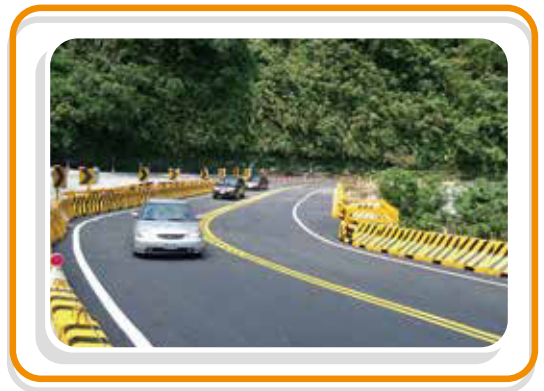
• 南口鋼便橋改道完成並開放通車
