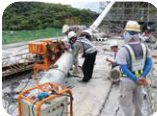
8.外置預力鋼索穿線作業
