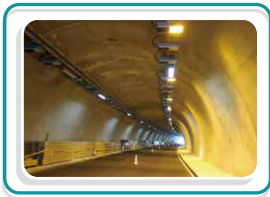
• 東岳隧道燈具安裝及測試
