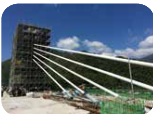
13.P2安裝完成之外置預力
