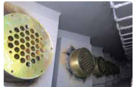
• 鋼箱固定錨座安裝
