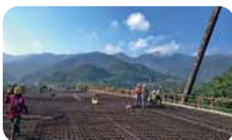
5.頂板鋼筋綁紮
