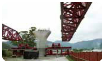
12.確認下一墩支撐架搭設是否完成
