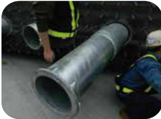
4.鋼殼之外置預力套管
