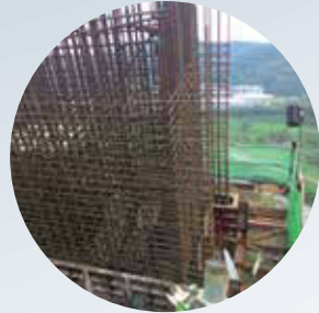
6. 墩柱內模安裝
