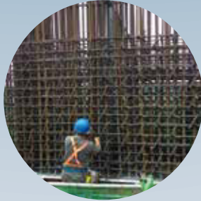
2. 墩柱鋼筋綁紮
