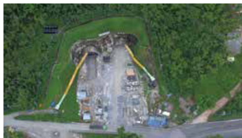
• 中仁隧道南口
