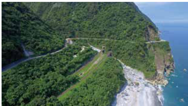
• 仁水隧道南口現況
