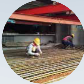
5.底板鋼筋綁紮
