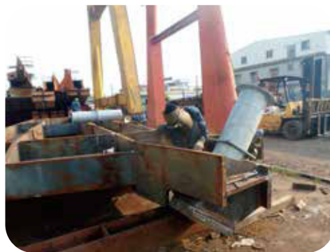
• 間隔梁成品電銲
