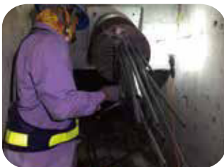
10.外置預力鋼索下端之夾片安裝
