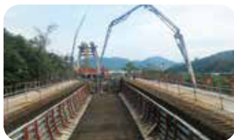
8.底腹板混凝土澆置
