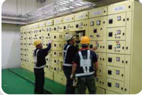
• 東澳隧道南口機房B1F配電盤安裝定位
