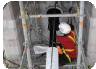
9.外置預力上端之安裝
