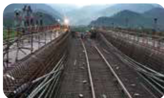
3.預力套管安裝及穿線
