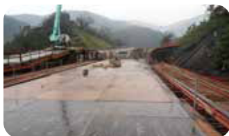
5.鋪設底模及軌道
