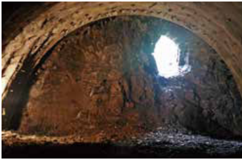
• 觀音隧道南口SS8上半工作面貫通
