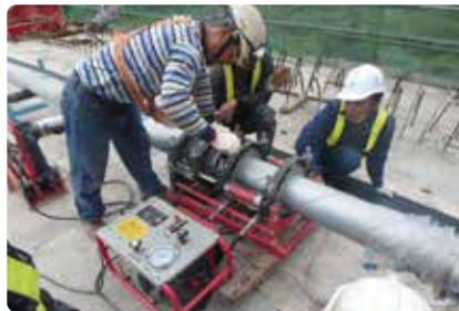
• HDPE管對接等前置作業
