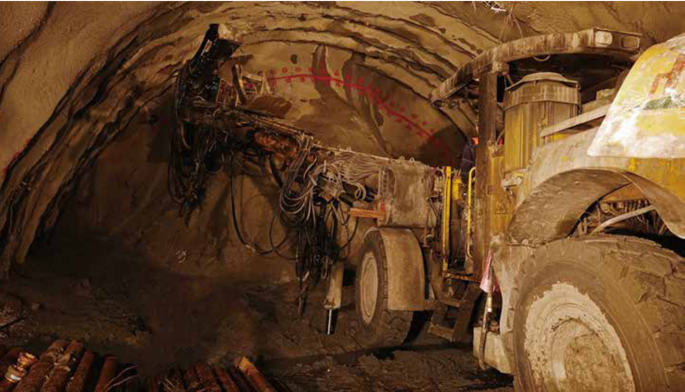
• 東澳隧道施作
