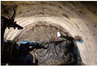
• 觀音隧道南口SS8輪進T1321管幕鑽設
