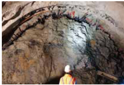
• 觀音隧道南口SS8輪進T1321管幕引孔鑽設
