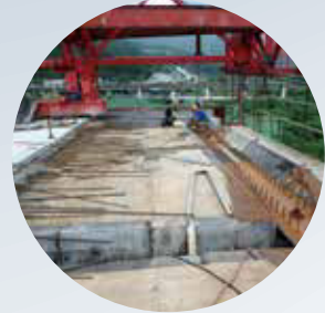
6.內頂板模安裝
