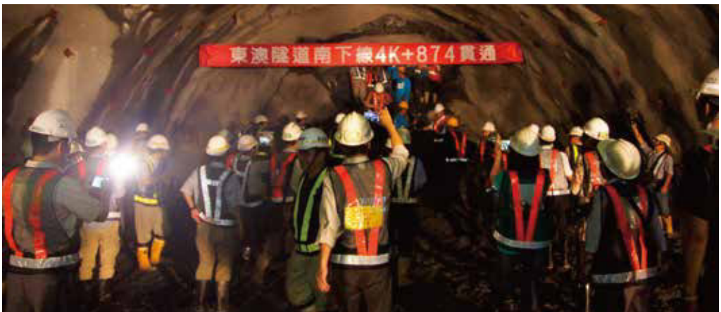
• 東澳隧道南下線貫通
