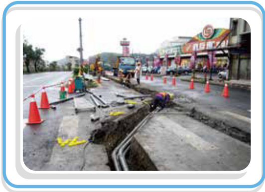
• 於蘇港路進行土木管道工程施作
