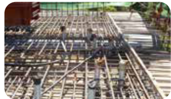
9. 頂板鋼筋及套管安裝
