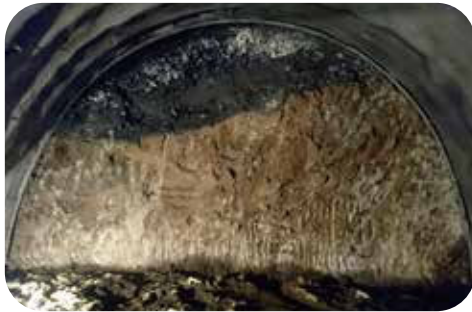
• 北口SS4開挖面
