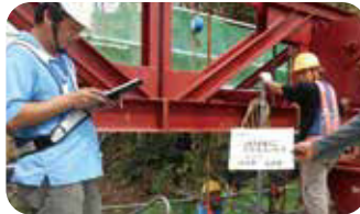
5. 預力施拉完成
