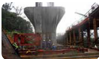
2.鋪設底梁及支撐塔
