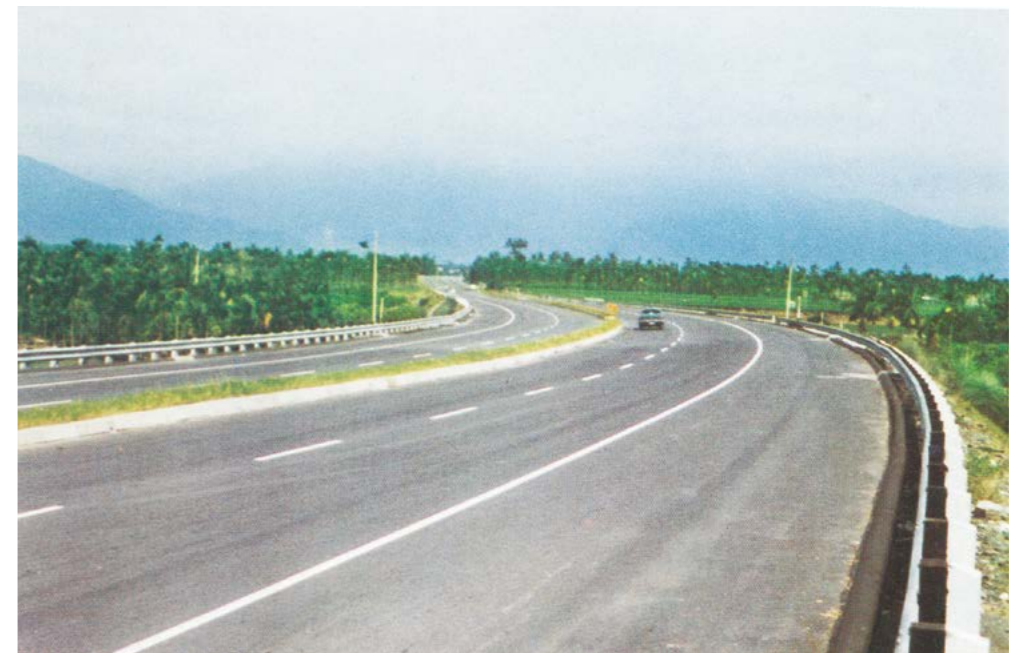
▲屏鵝公路拓寬計劃潮州橋附近路面完成通車
