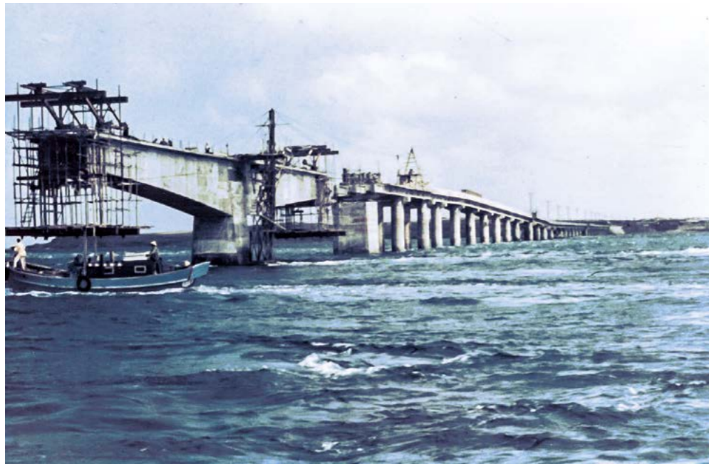
▲澎湖跨海大橋施工
