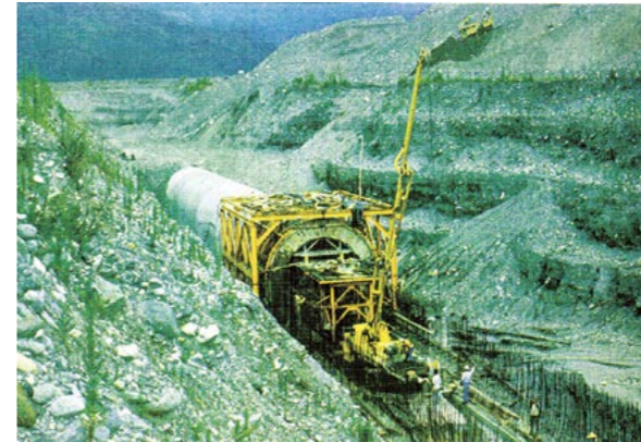
▲預鑄全隧道節塊置放情形（一）
