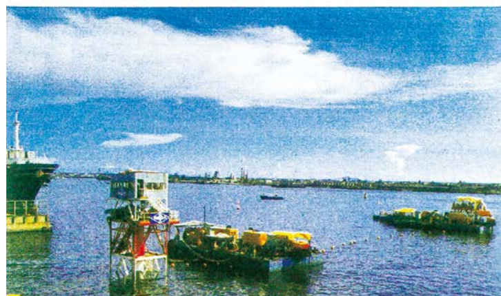
▲開闢過港隧道，沉埋管沉放作業
