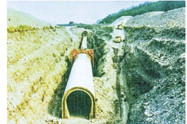
▲預鑄全隧道節塊置放情形（二）
