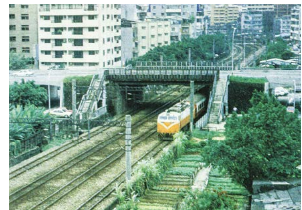
▲立體交叉之三—陸橋
