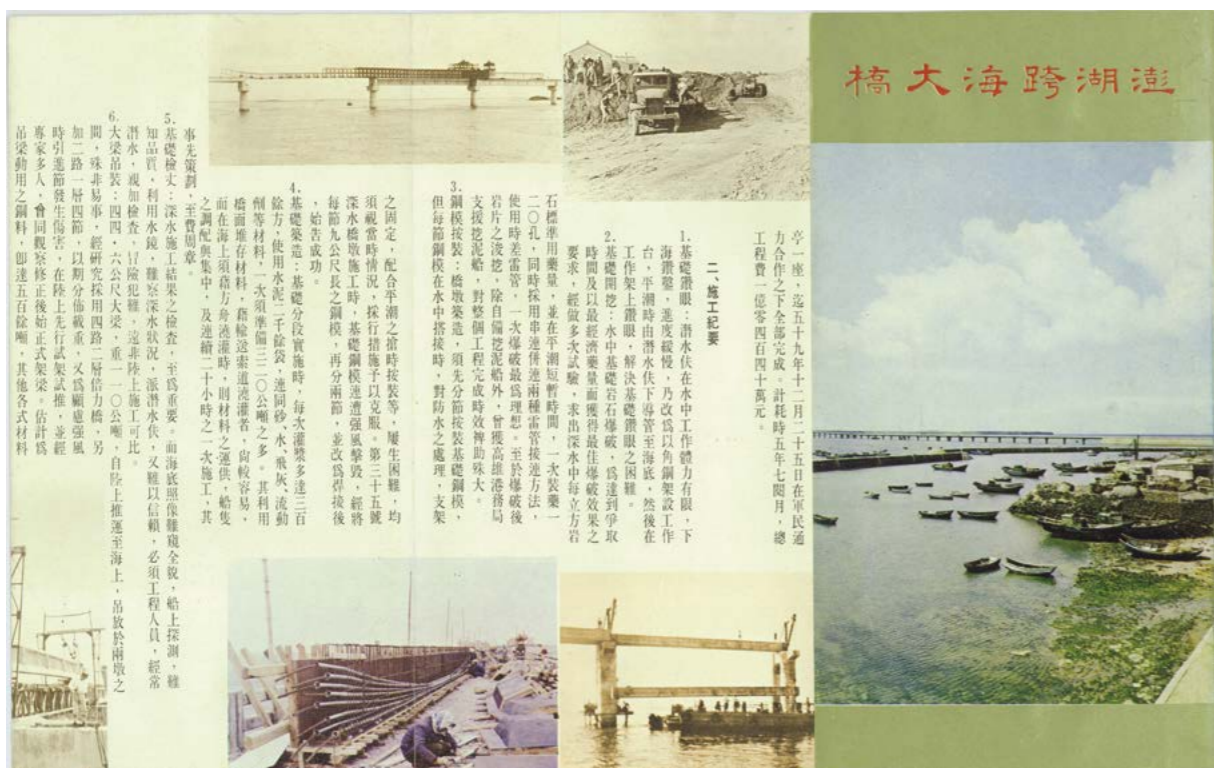
▲澎湖跨海大橋摺頁簡介
