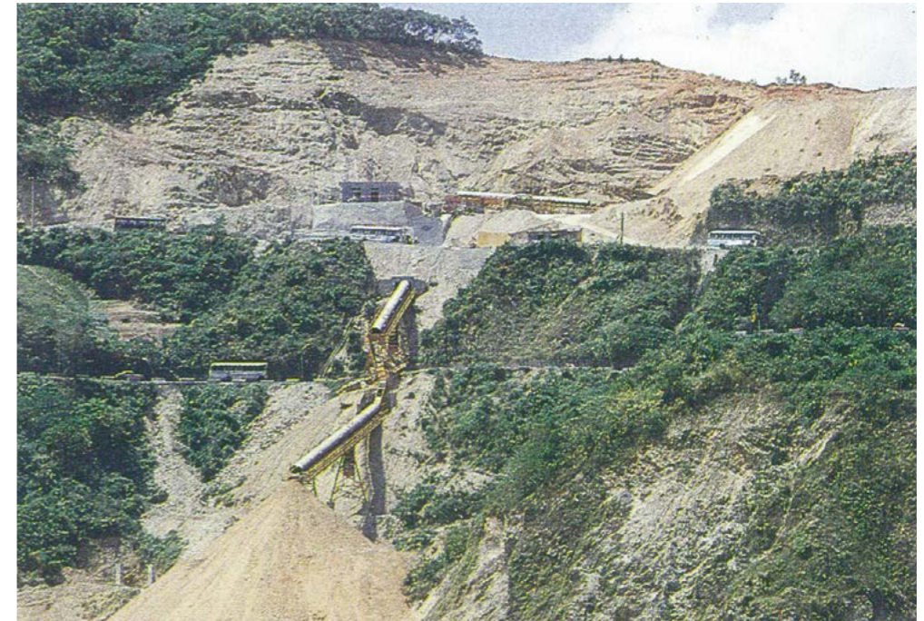
▲蘇澳港移山填海建港
