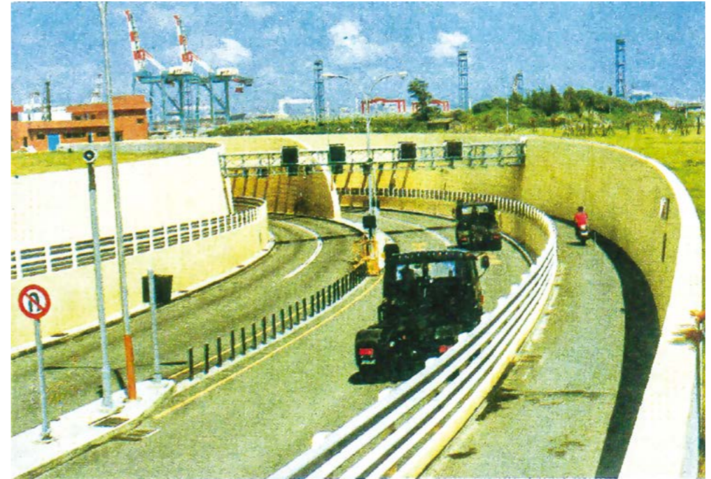
▲ 過港隧道旗津區隧道一端
