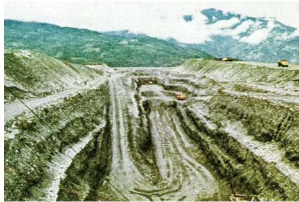
▲明挖河底隧道運土方法
