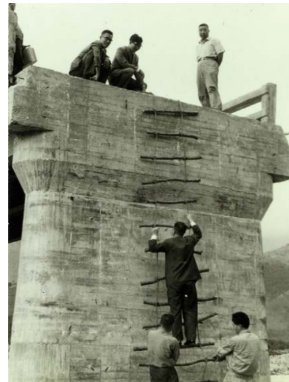
▲實地勘災，穿西裝攀爬橋墩者為作者
