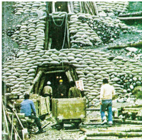
▲光復河底隧道保護工程
