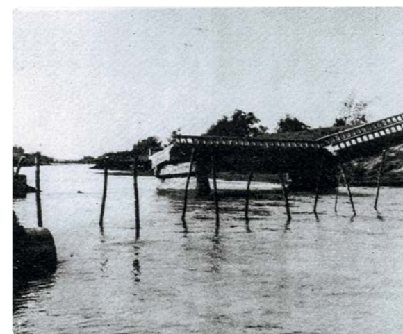
▲八七水災橋梁斷裂
