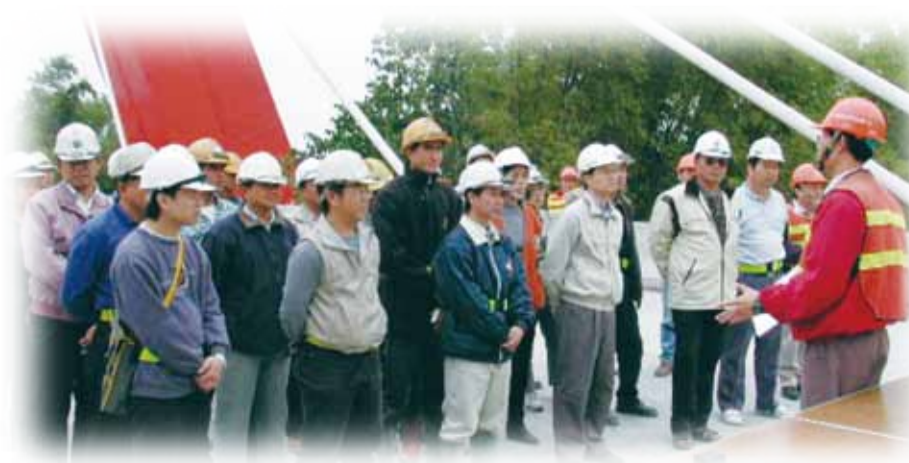
E407-1標工程緊急應變暨消防演練-東口工地 90年12月28日
