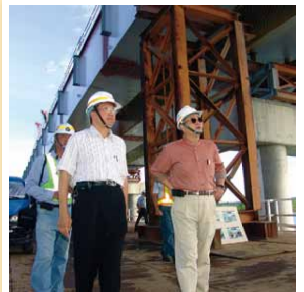
西濱南工處楊處長陪同局長巡視台17線曾文溪國姓橋整建工程施工一隅 (攝影:王富生)
