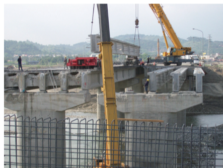
兩部大型吊車吊裝預力大梁
