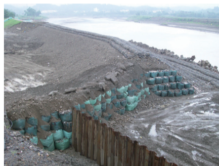
芭瑪颱風來襲前破堤處的防颱措施
