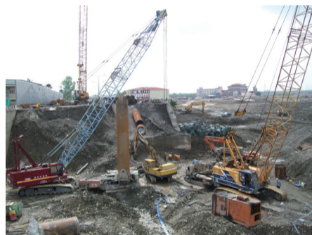
兩部鑽掘機同步施作全套管基樁
