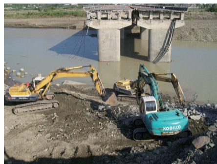
破碎機打除舊橋台基礎結構體
