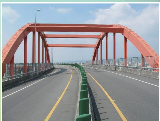
貓羅溪橋全長167公尺，由員林工務段養護
