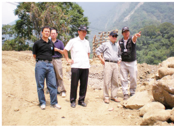
8月30日毛部長及局長在台21線100k路基流失處督導搶通便道景況
