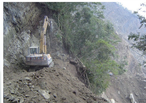
71K便道搶修開鑿陡峭岩壁
