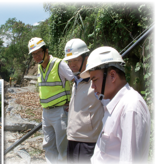
98.08.17局長視察台21線道路修復工程
