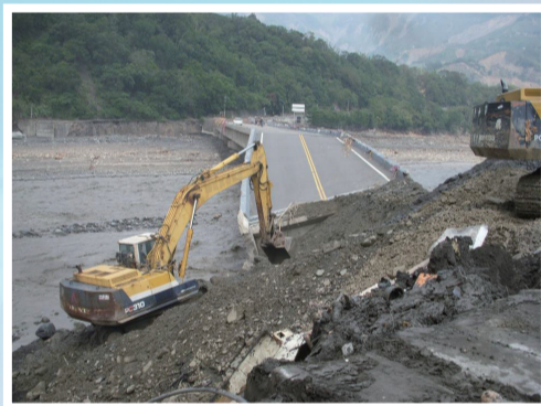
台20線寶來二橋搶修修復情形
