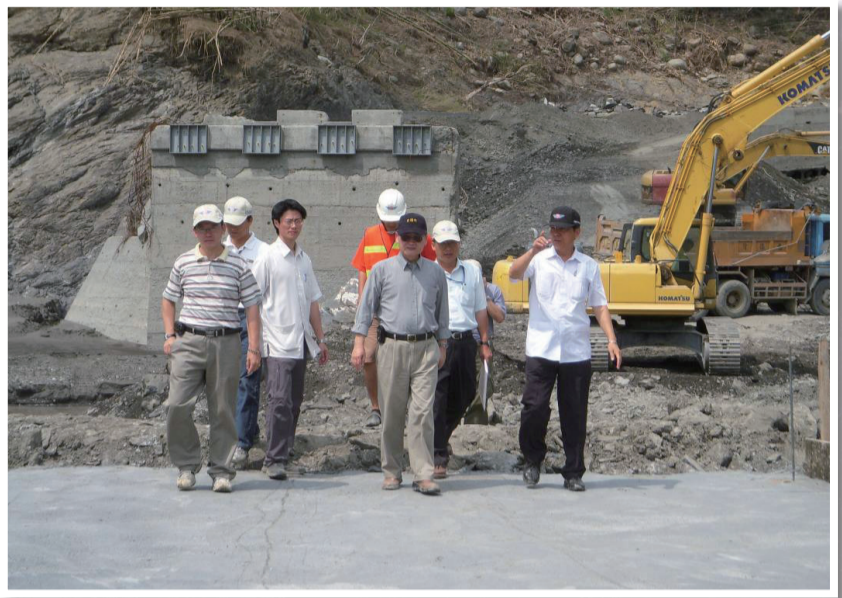
98.08.31部長、局長勘查台27線新發大橋便道施築作業
