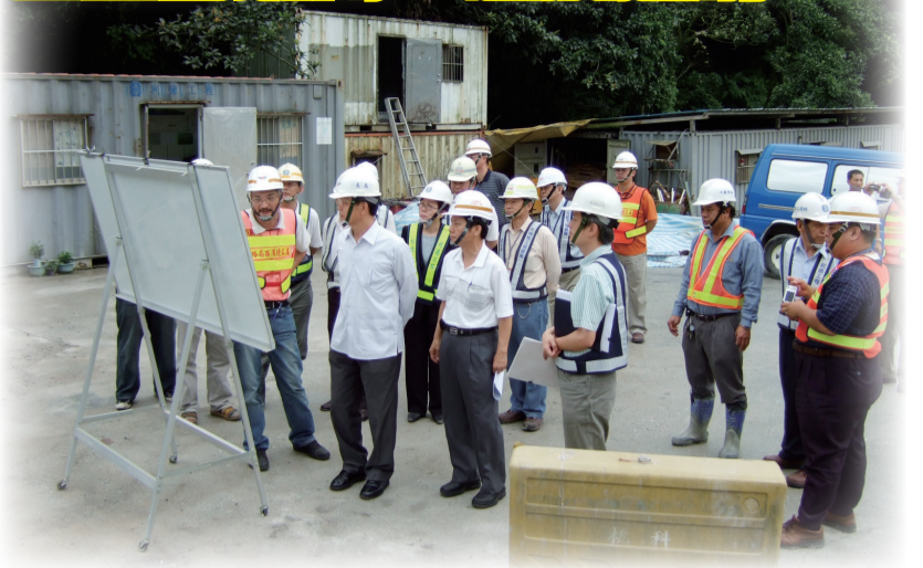
局長視察基隆港東岸聯外道路CI02標工程2號隧道施工情形
