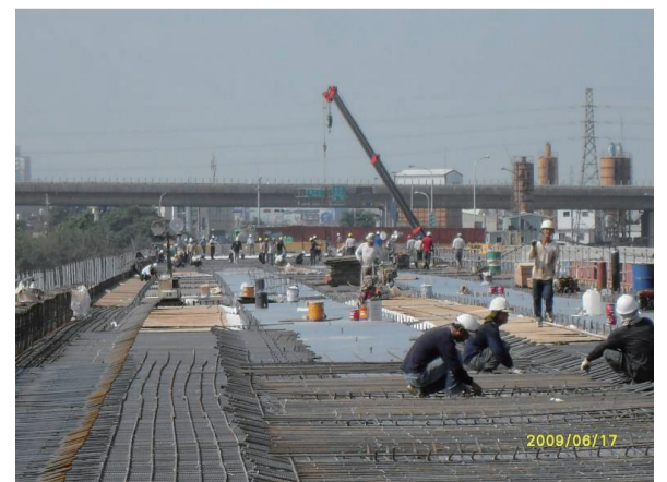
橋面板鋼筋組立
