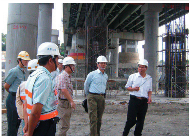
局長視察台3線烏溪橋並聽取工程進度及概況
