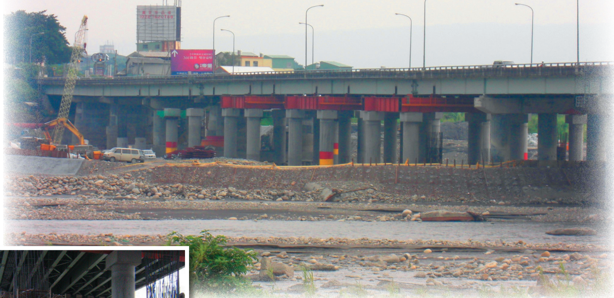
台3線目前改建現況
