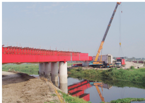
C822標工程之八爺溪一號橋採用鋼箱梁設計，符合節能減碳綠色工程指標
