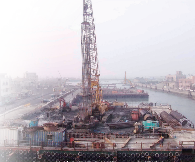
WH69-1標工程位於布袋港南航道，工程規模浩大，施工難度高
