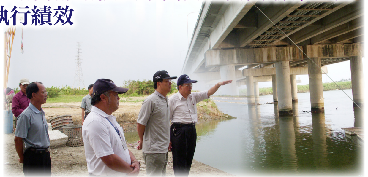
局長視察台17線國姓橋橋墩現況並聽取改建進度
