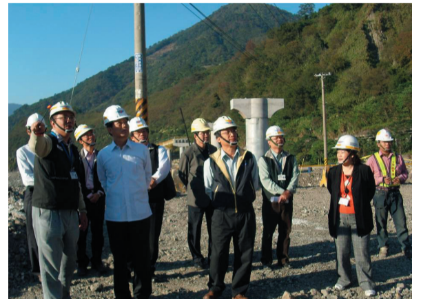
信義工務段汪段長向局長、趙副局長及前二工處黃處長報告本工程進度情形
