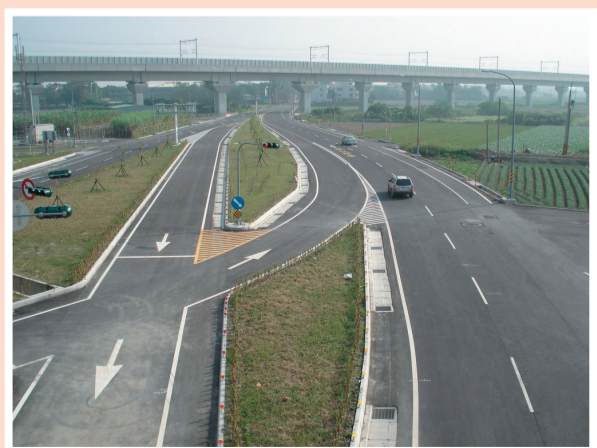
由台78線高架橋俯瞰土庫交流道交織情形(西行線匝道及雲97線連絡道南下車道)
