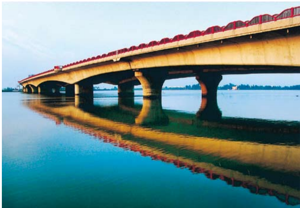
將軍溪景觀橋竣工照片
