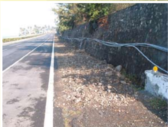
枋山路段景觀改善前
