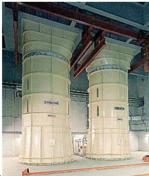
排風機。風在隧道中沿著行進方向流動，隧道內的空氣通過排氣扇從小塔中排出。
