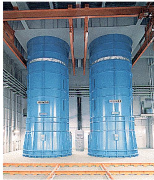
送風機。從塔中吸入新鮮空氣並通過送風機吹入隧道。
