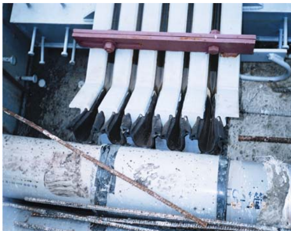
圖3.6 模組型伸縮縫施工情形
