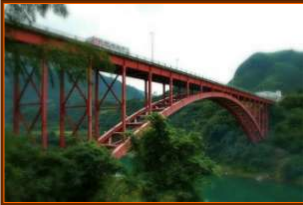
圖1 上承式鋼拱橋
