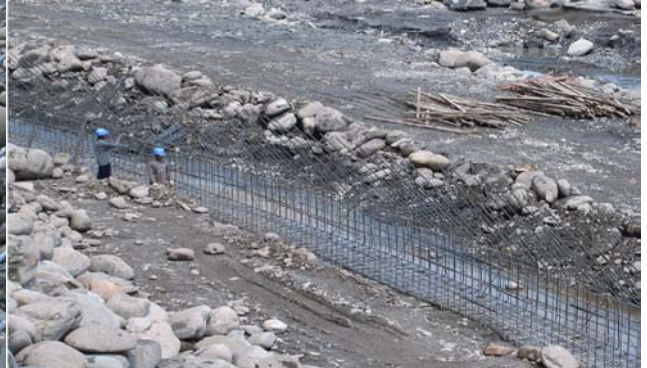
照片12 鋼筋混凝土護坡基礎紮筋遠視
