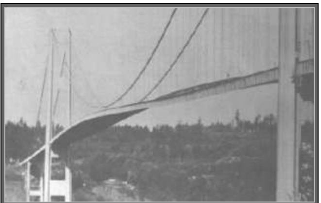
圖23 Tacoma Narrows橋之橋面扭轉振動 (圖示一，1940年)
