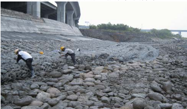
照片15 蛇籠護坡捆鐵線
