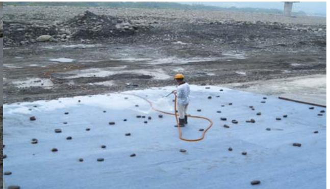
照片14 鋼筋混凝土護坡澆水養治
