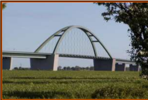
圖3 下承式鋼拱橋
