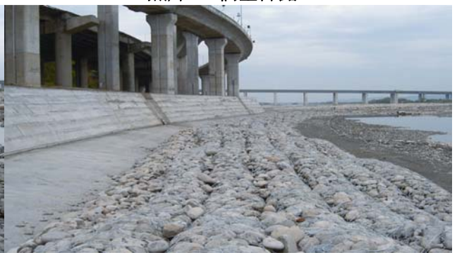
照片6 新建匝道支撐架
