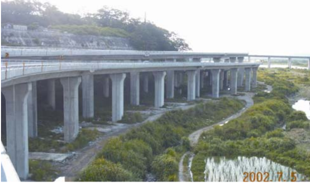
照片9 新建匝道完工實況
