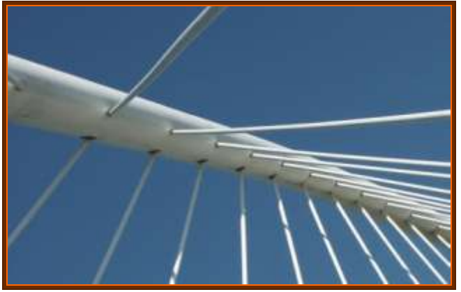
圖21 Campo Volantin人行橋吊索與拱圈接合方式
