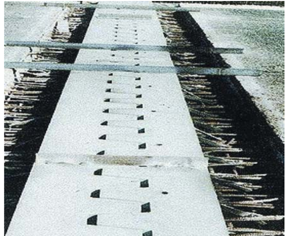
圖3.4 齒型伸縮縫施工情形
