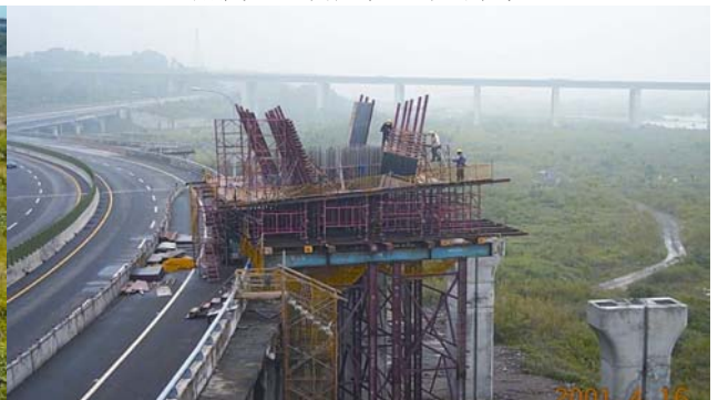
照片8 新建匝道懸臂樑
