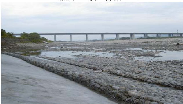
照片5 新建匝道完工實況
