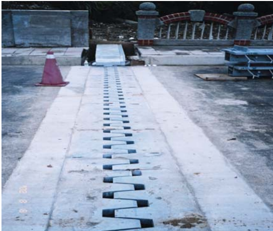
圖3.3 齒型伸縮縫施工情形
