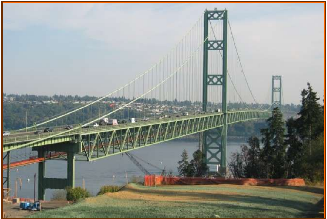
圖26 Tacoma Narrows 橋重建之後（1950年）
