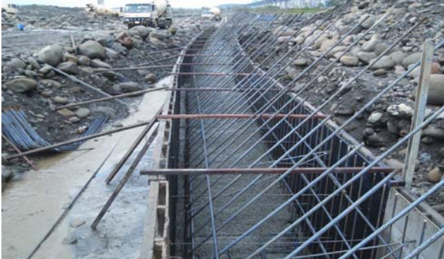
照片11 鋼筋混凝土護坡基礎配筋近視
