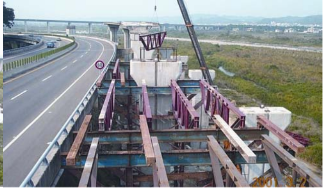
照片10 新建匝道支撐架
