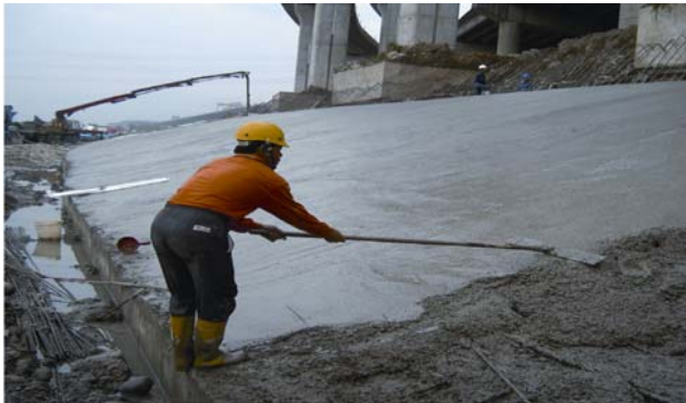
照片13 鋼筋混凝土護坡表面抹平
