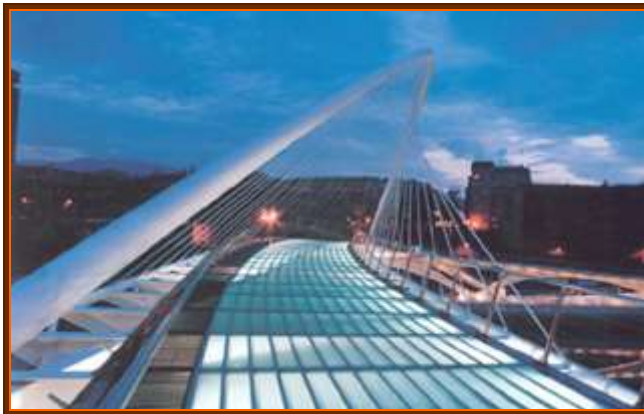
圖6 Campo Volantin 人行橋夜間照明
