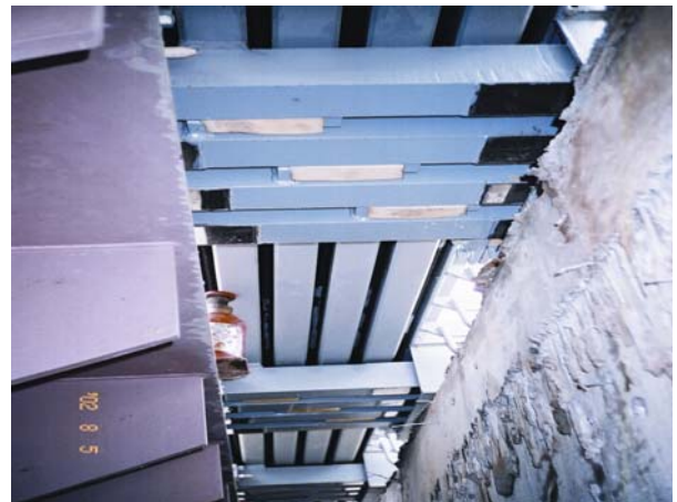
圖3.7 模組型伸縮縫施工情形
