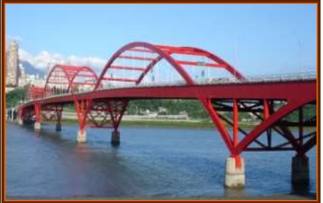
圖2 中承式鋼拱橋
