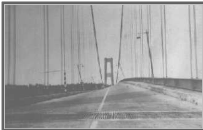
圖24 Tacoma Narrows 橋之橋面扭轉振動 (圖示二，1940年)
