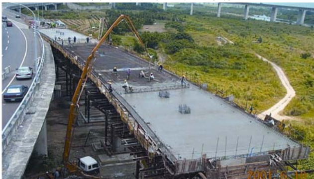
照片7 新建匝道橋面版
