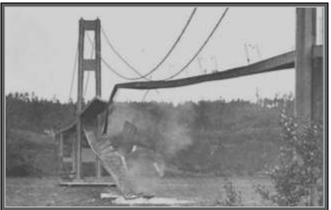
圖25 Tacoma Narrows 橋崩塌之後 (1940年)
