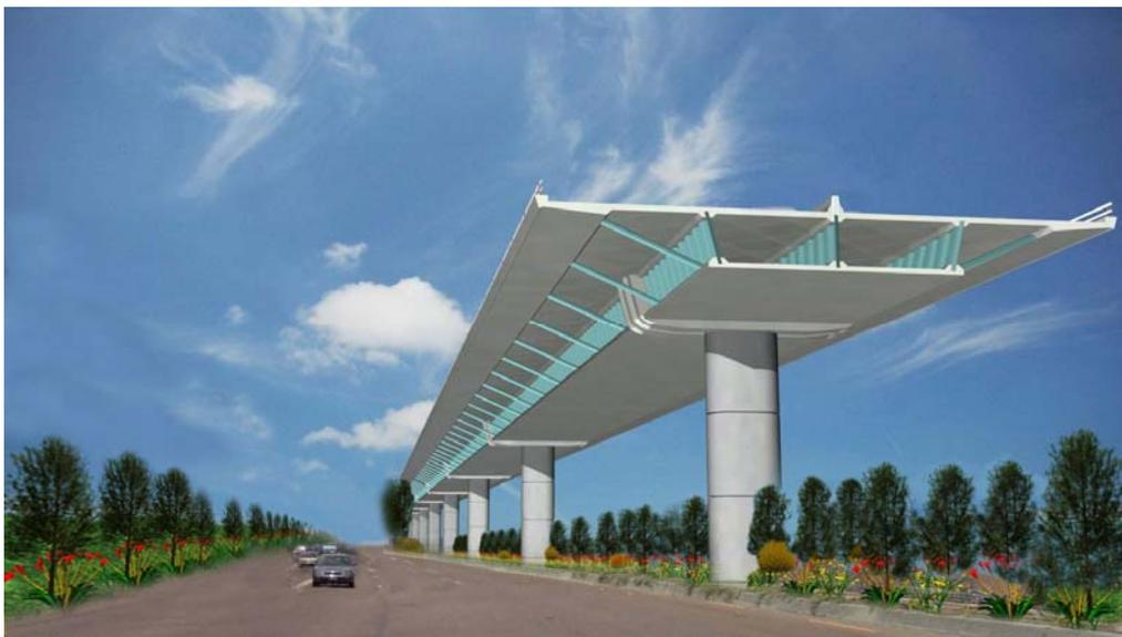
圖 5.5-1 方案 A：鋼管斜撐鋼腹鈹合成梁橋示意圖
