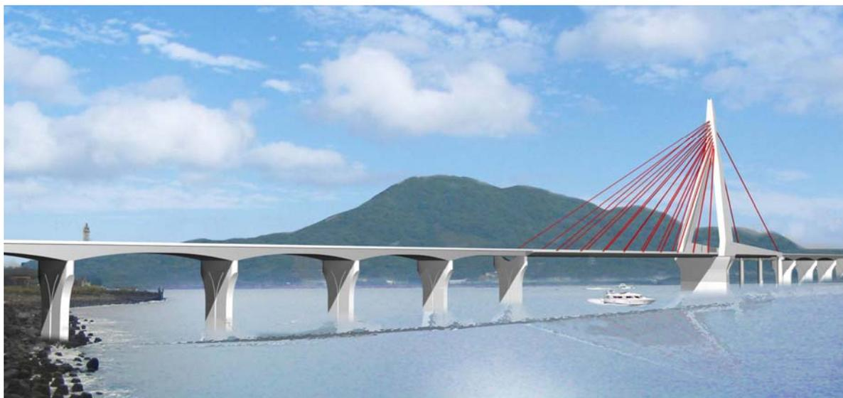
圖 5. 4-2 方案二：鶴型橋塔斜張橋示意圖
