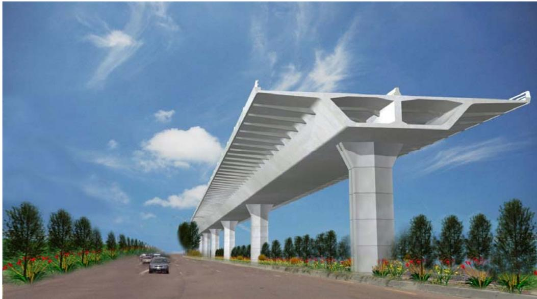
圖 5.5-4 方案 D：加肋預力箱型梁橋示意圖
