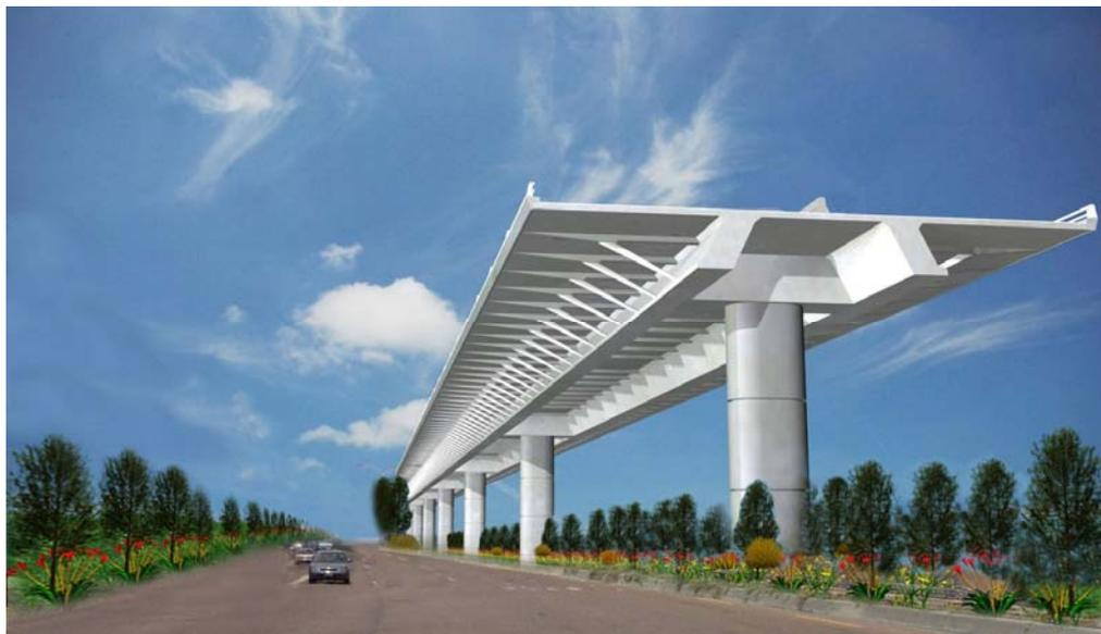
圖 5. 5-2 方案 B：預鑄斜撐預力  $\pi$  型梁橋示意圖
