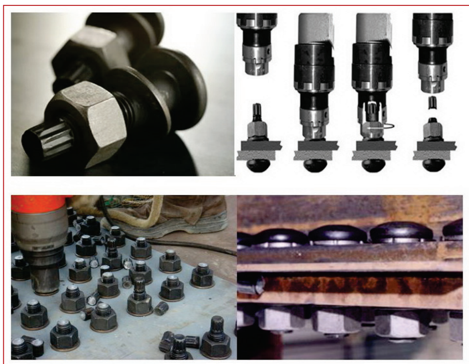
圖 3-11 斷尾螺栓法-扭矩控制 TC 螺栓
