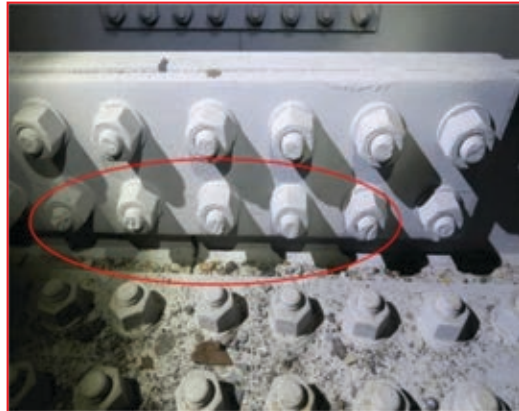
圖 3-24 尾端瓦斯切除
