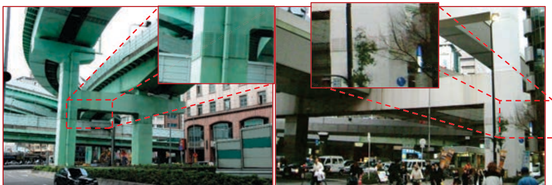
臺灣鋼橋墩柱現場接頭
