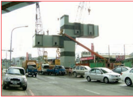
a 工地現場接頭採螺栓結合
