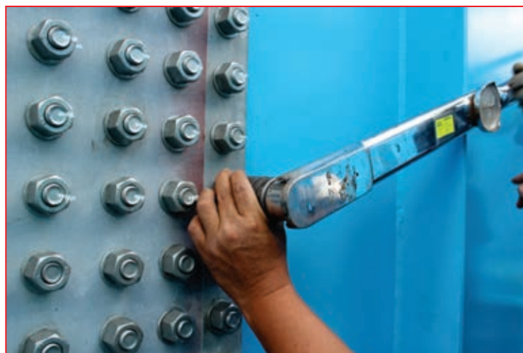
圖 3-9b 螺帽旋轉法施工例
