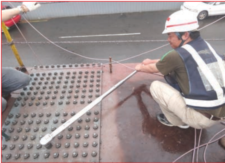
圖 3-15b 利用驗證之 K 值現場檢測鎖固螺栓扭力值
