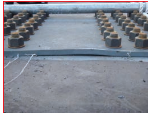
圖 3-26 鎖固順序錯誤連接板擠壓變形
