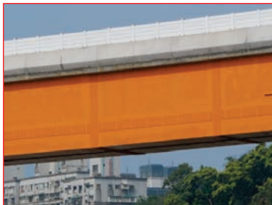
圖 2-4 腹板現場接頭 (I型螺栓配置)
