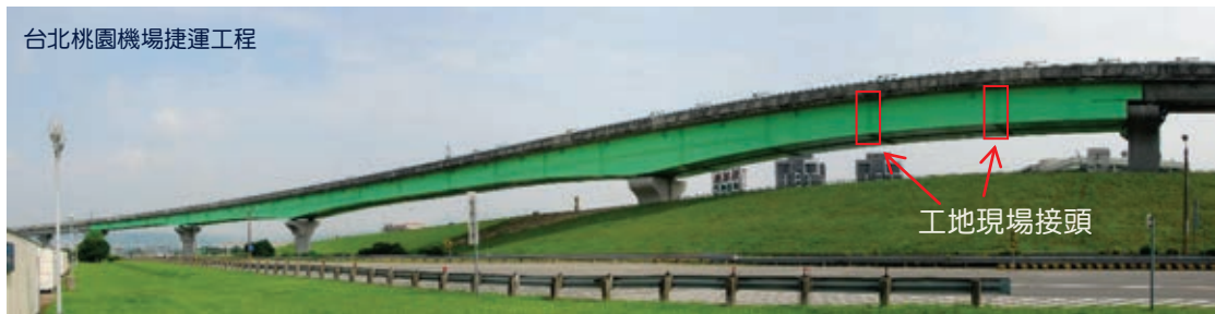
圖 1-1 鋼梁及工地現場接頭配置
