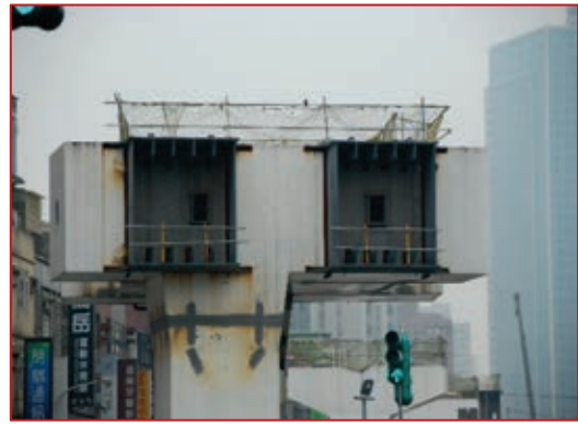
b 工地現場接頭採螺栓搭配銲接
