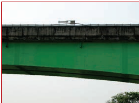
圖 2-4 腹板現場接頭 (I型螺栓配置)
