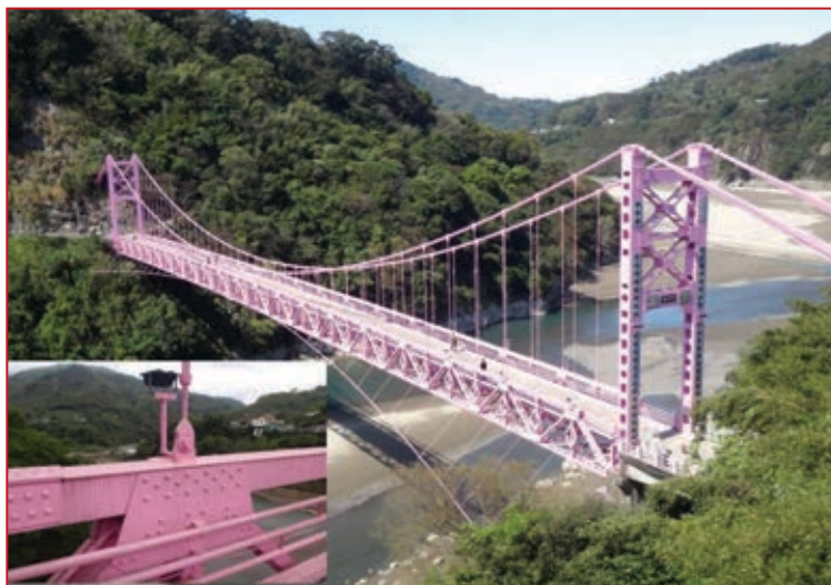
圖 3-2 舊省道台 7 線復興橋
