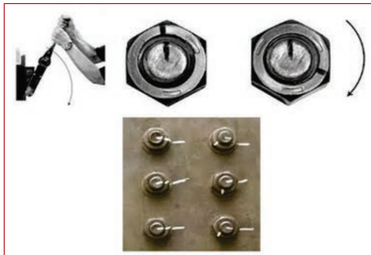
圖 3-9a 螺帽旋轉法施作前標記及完成後檢視旋轉量
