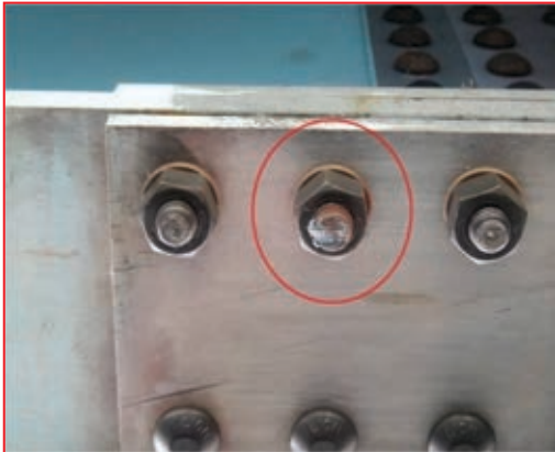
圖 3-23 尾端瓦斯切除
