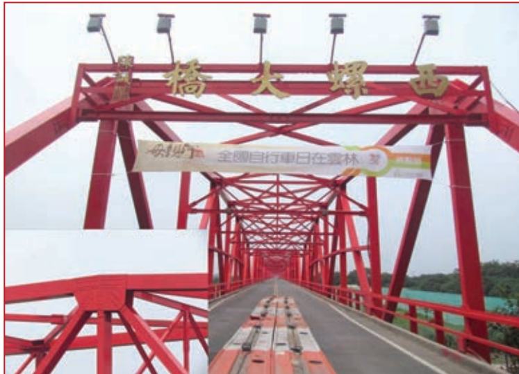
圖 3-1 縣道 145 線-西螺大橋
