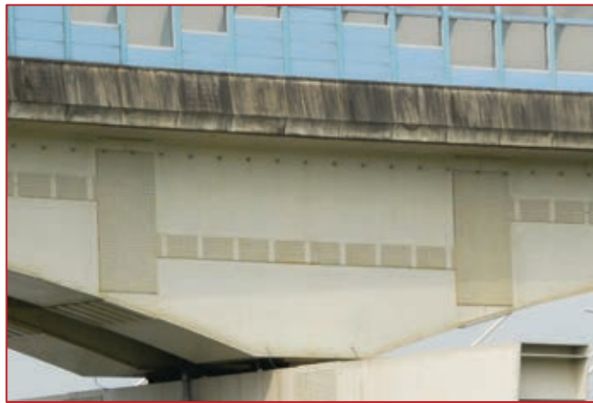
圖 2-11 腹板螺栓接頭配置
