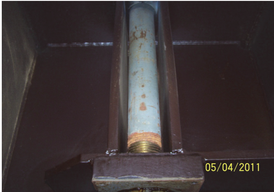
照片 5 吊索鋼棒上部之構造
