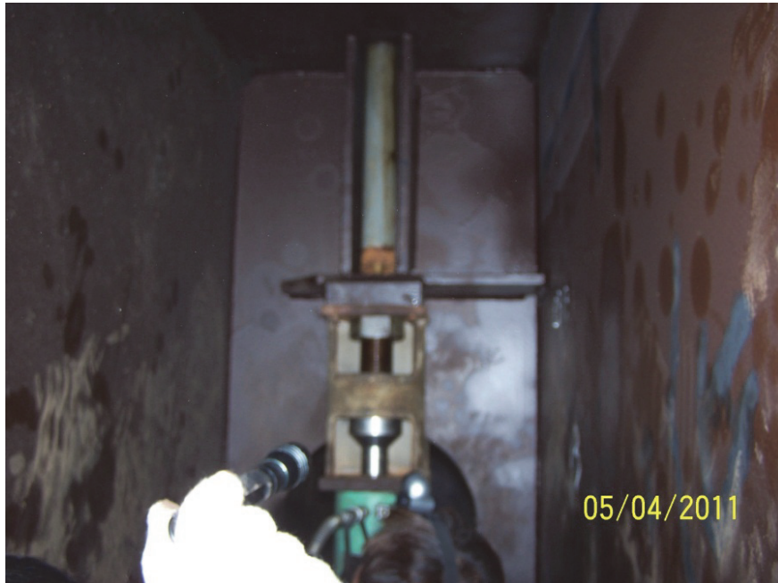
照片 3 於施工前先行進入鋼箱梁內部了解舊吊索之構造
