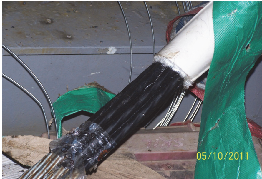
照片 24 熱擠壓式黑色 HDPE 護套
