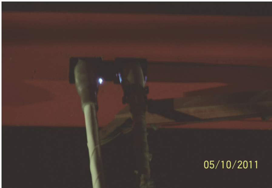
照片 32 已安裝完成的吊耳
