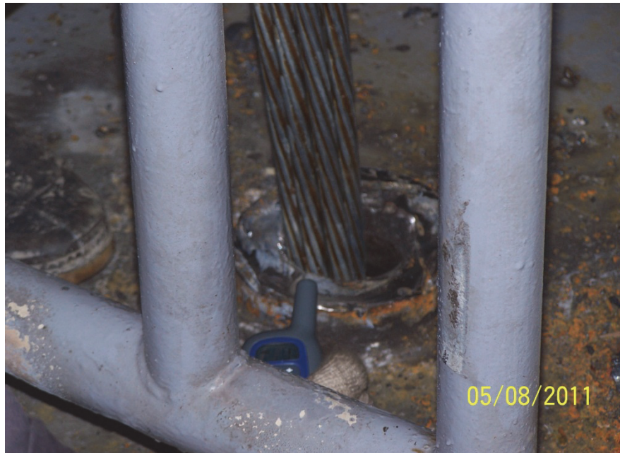
照片 26 已將 9 股鋼絞線安插至鋼箱梁的孔內
