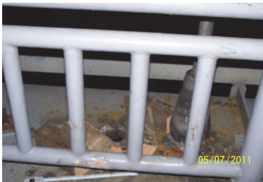
照片 12 將 CB-13 吊索拆卸下來之情形
