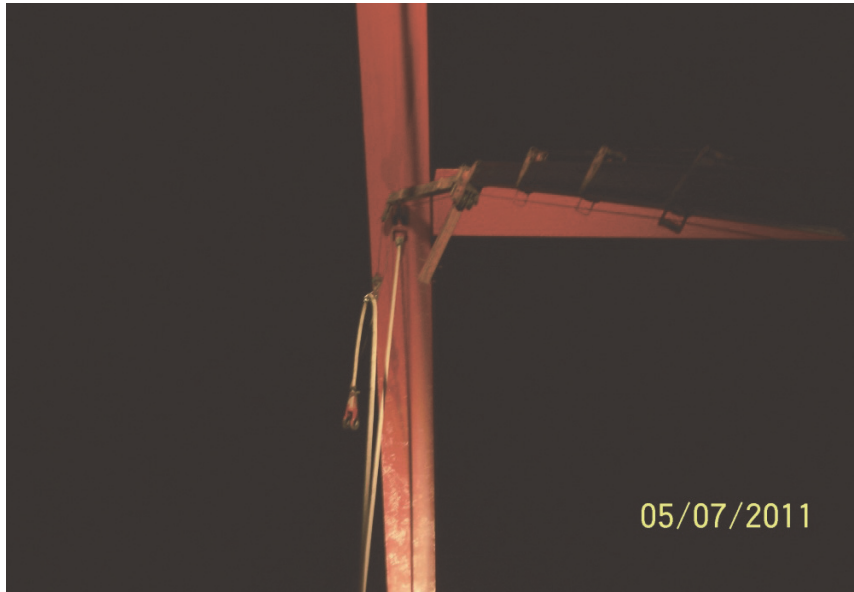
照片 15 上面拆卸吊索之情形
