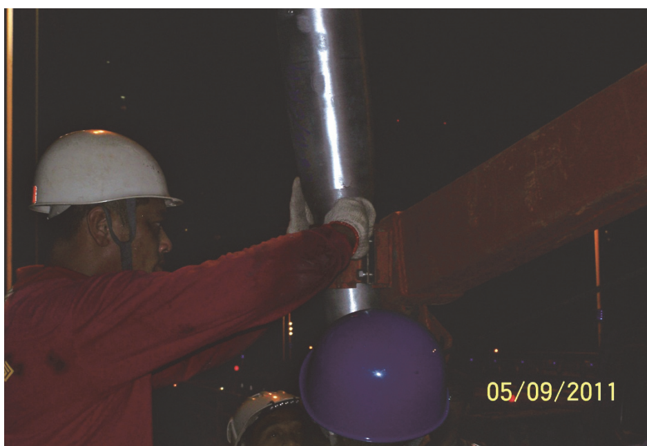
照片 28 將新吊索吊耳先行固定於滑輪旁的鐵環內（二）
