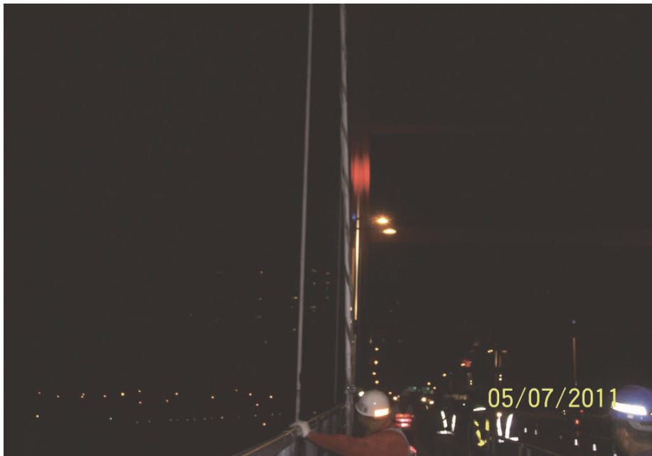
照片 14 拆卸吊索之情況
