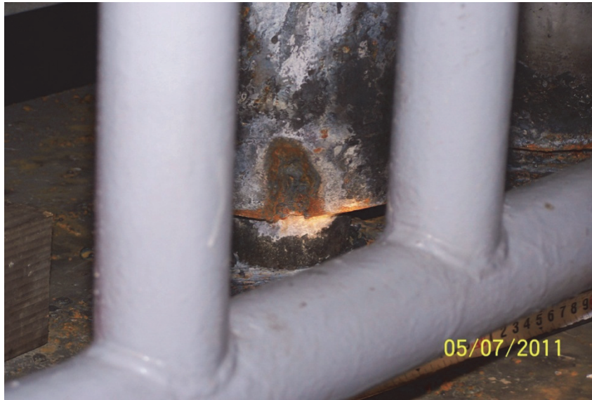
照片 7 吊索承座以氧氣與乙炔的混合高溫火焰切開後之狀況
