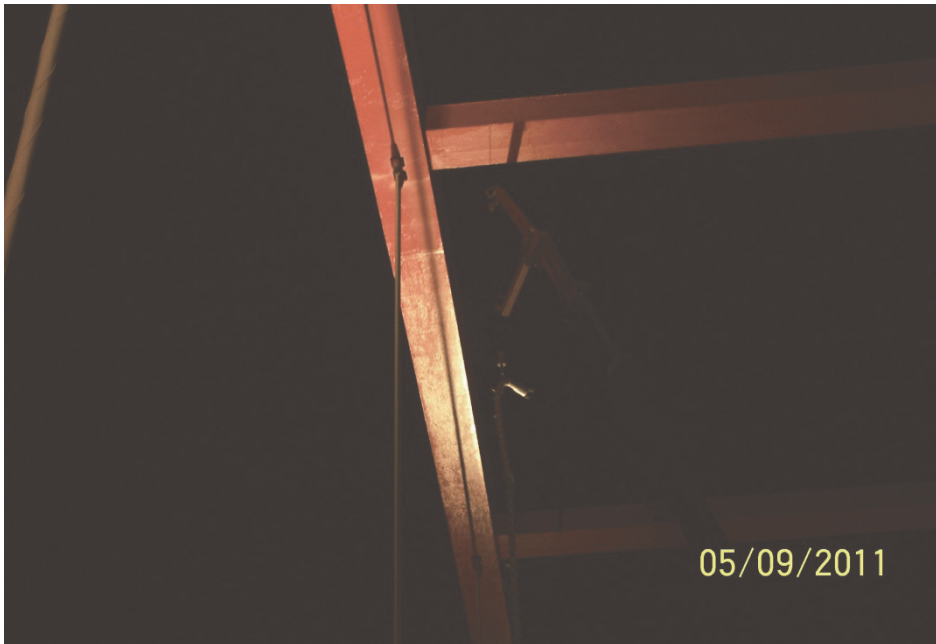
照片 30 第二條吊索進行安裝
