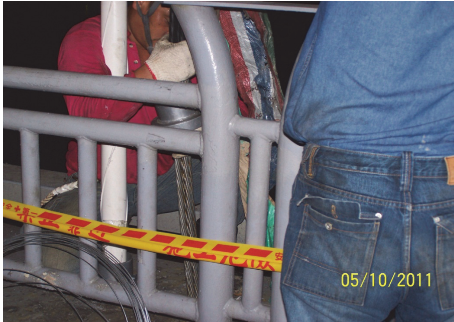
照片 35 將吊索安插至鋼箱梁下方的錨定端
