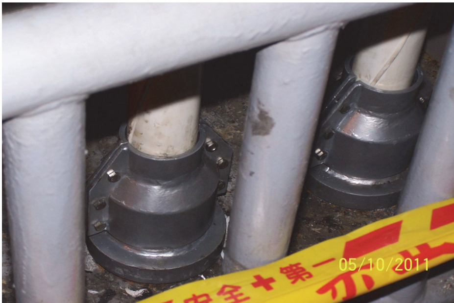
照片 38 最後再安裝防水罩即完成
