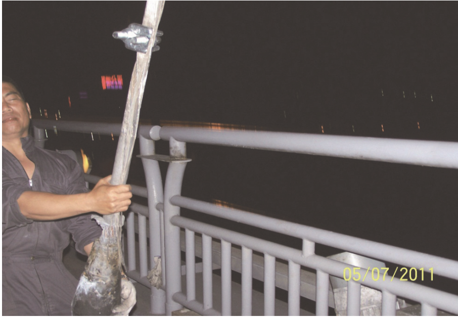
照片 13 將拆卸下的舊吊索移至旁邊放置
