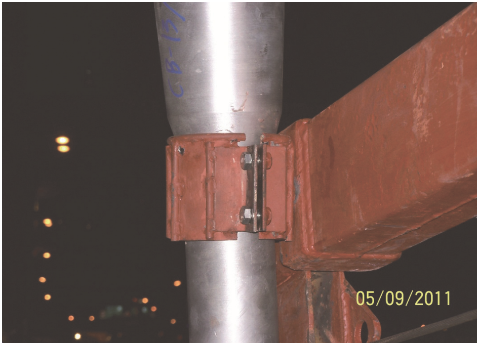
照片 29 已固定於滑輪旁的新吊耳
