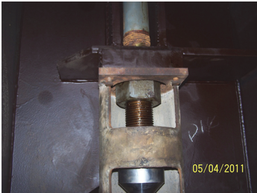
照片 6 以千斤頂先試著微微頂開螺帽即可讀取吊索承受之拉力
