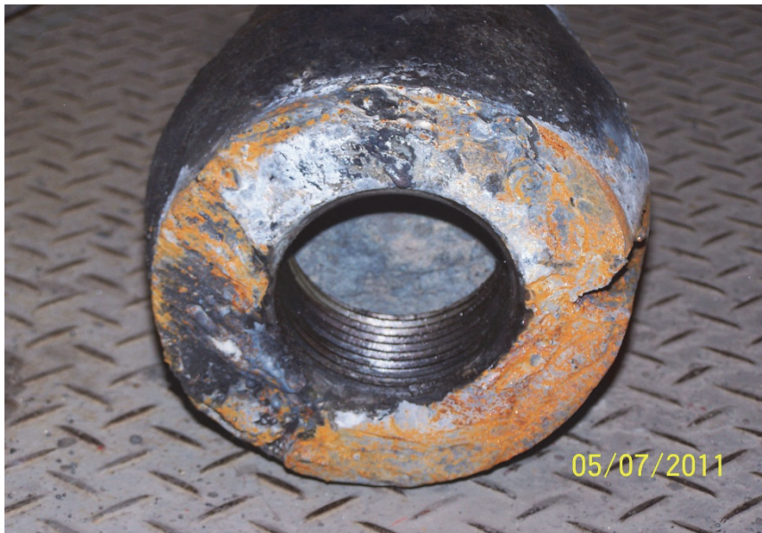
照片 16 拆卸下的承座
