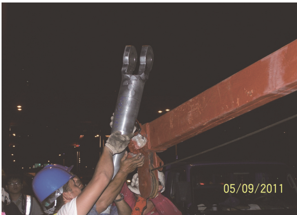
照片 27 將新吊索吊耳先行固定於滑輪旁的鐵環內（一）
