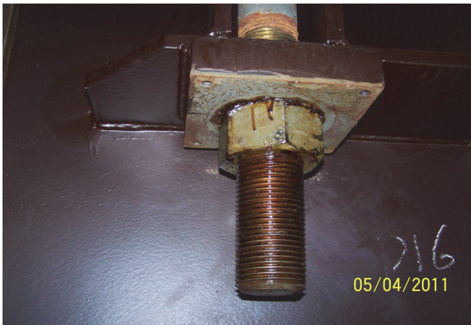
照片 4 舊吊索鋼棒處以螺帽鎖緊於鋼箱梁的加勁板中
