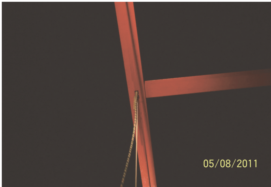
照片 34 上方的吊耳已用插銷固定
