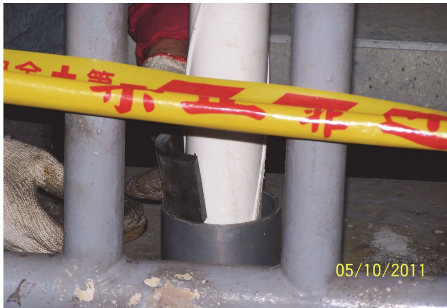
照片 36 放置制震器可減少吊索的震動
