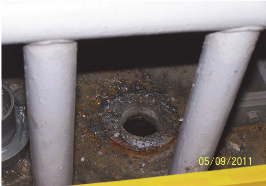
照片 21 拆下舊吊索後鋼箱梁的孔洞
