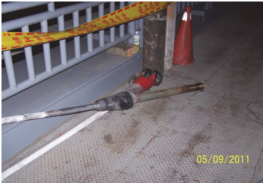
照片 20 拆卸下舊吊索的承座與鋼棒
