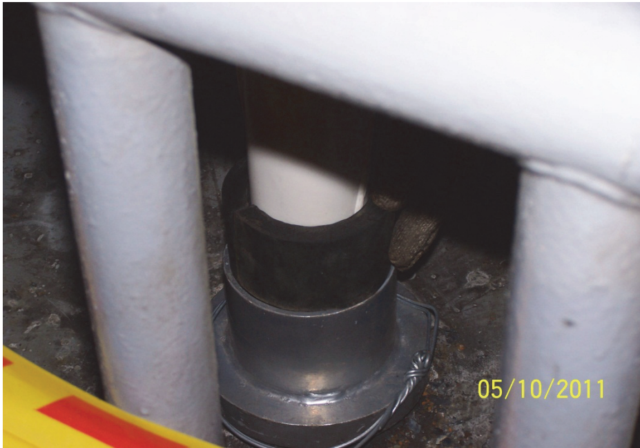
照片 37 制震器放置完成
