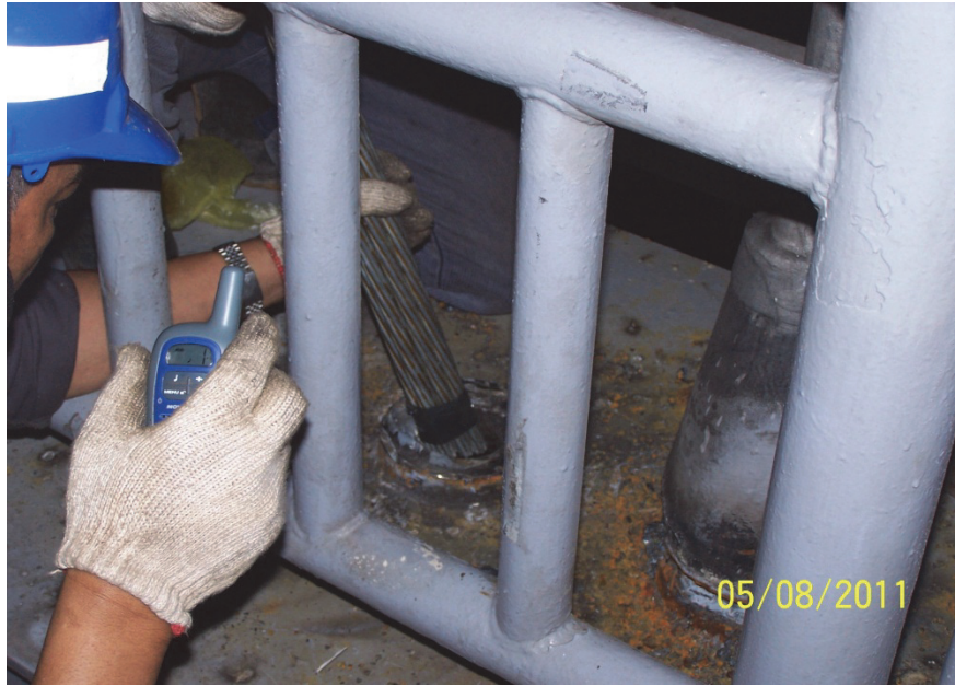
照片 25 與鋼箱梁內的工作人員溝通後將吊索的 9 股鋼絞線放入孔洞中
