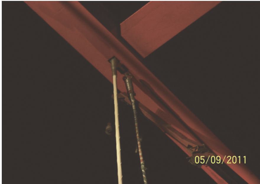
照片 31 將吊索吊耳安插於拱圈的孔洞
