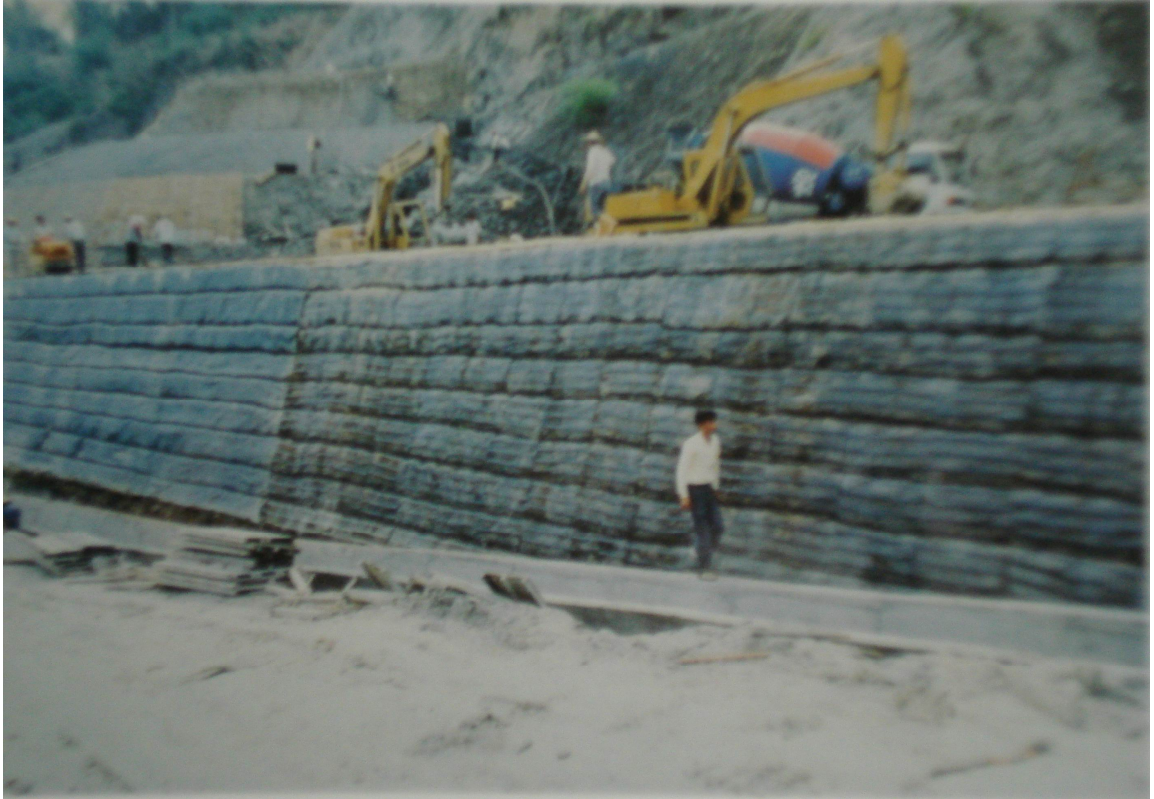
照片 4 擋土牆（交通部台灣區國道新建工程局，1992）
