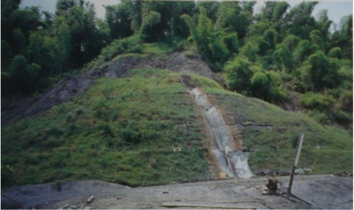
照片 3 水土保持植生排水法（交通部台灣區國道新建工程局，1994）
