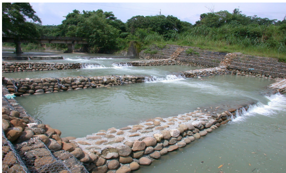
圖 19a 六重溪多重固床工
