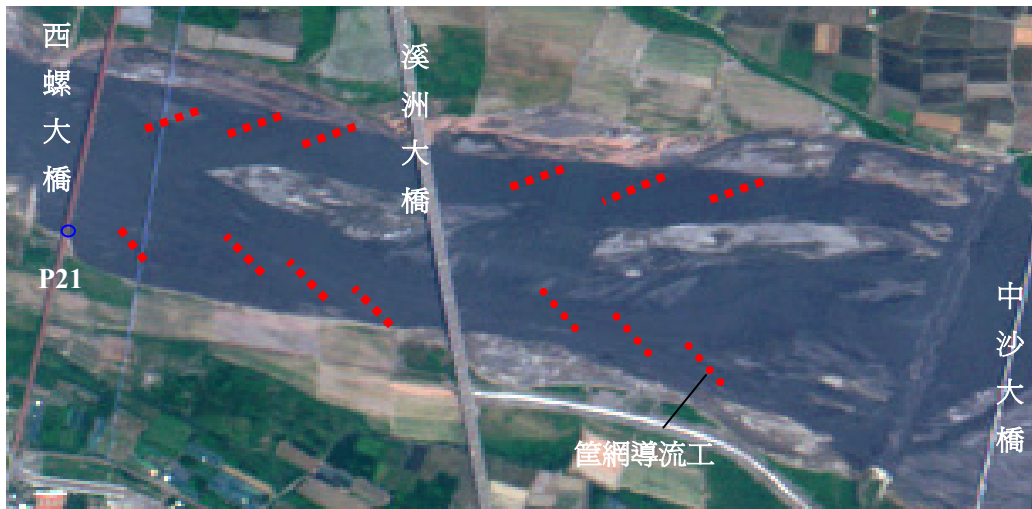
圖 20 濁水溪導流工法穩定河道流路以保護高灘橋墩
