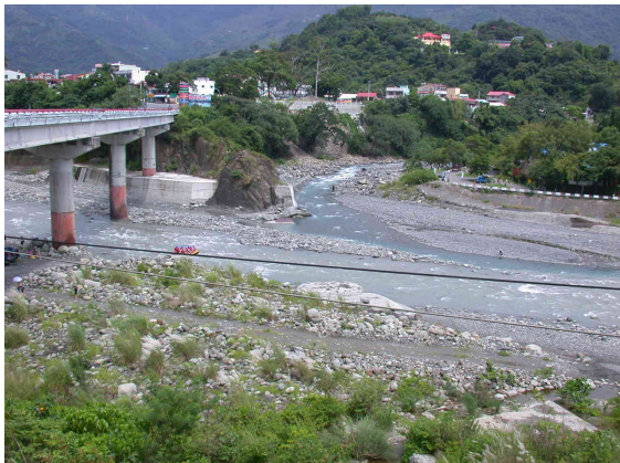
圖 9 重建的寶來一號橋
