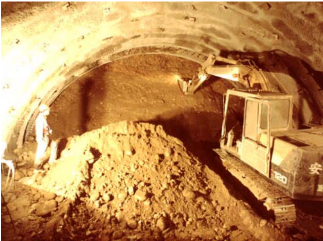
圖三 隧道上半斷面開挖
