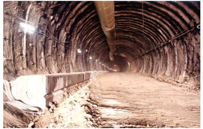
圖八 隧道全斷面完成
