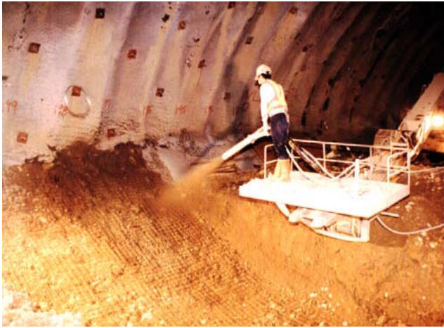
圖五 臨時仰拱噴凝土施工
