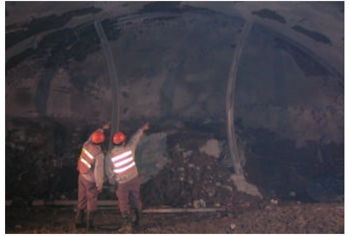
圖六 雙側導坑施工
