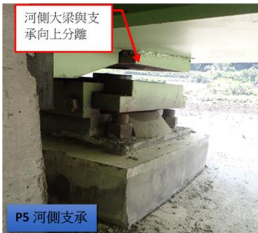
左側大梁下翼板與支承上盤脫離(上盤凸緣有摩擦痕跡)
