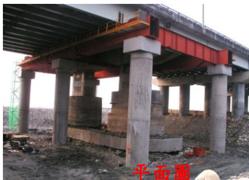
圖 2-1-3 台 3 線烏溪橋換底工程六支臨時支撐柱
