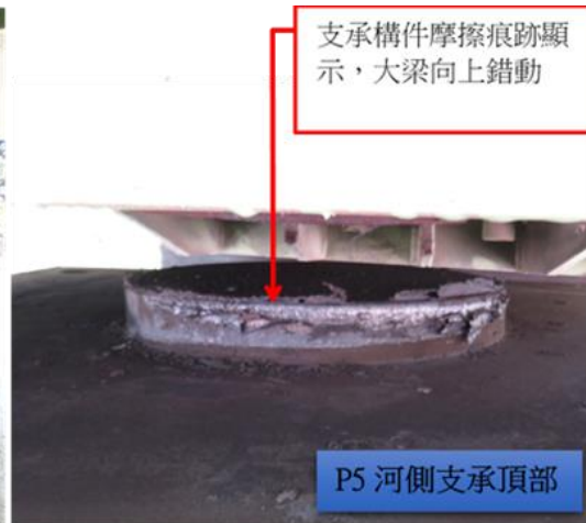
左側大梁下翼板與支承上盤脫離(上盤凸緣有摩擦痕跡)
