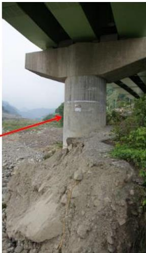
墩柱朝臨河側傾斜約 1/100
