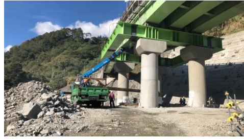
圖 1-4 先建後拆換底工法第一種方式[下部結構整體改建(含帽梁)]
