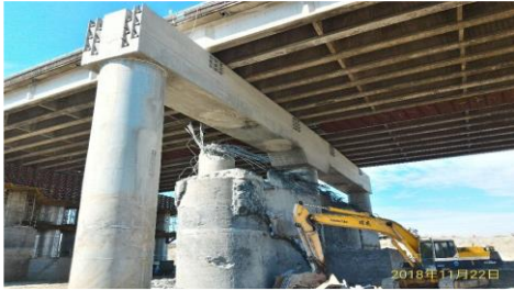
圖 1-5 先建後拆換底工法第二種方式[下部結構整體改建(未含帽梁)]
