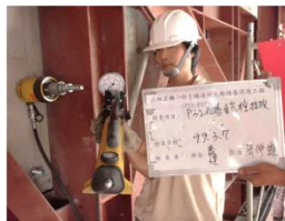
錨栓拉拔試驗
