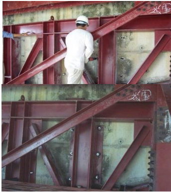
圖 2-2-5 台 1 線溪州大橋橋基保護工程 (P21~P37) 化學錨栓及固定帽梁示意圖
