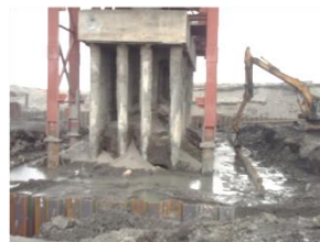
鋼板樁打設
