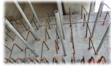
植筋及埋設預力鋼棒套管
