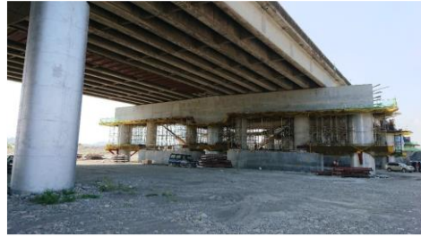
圖 1-5 先建後拆換底工法第二種方式[下部結構整體改建(未含帽梁)]
