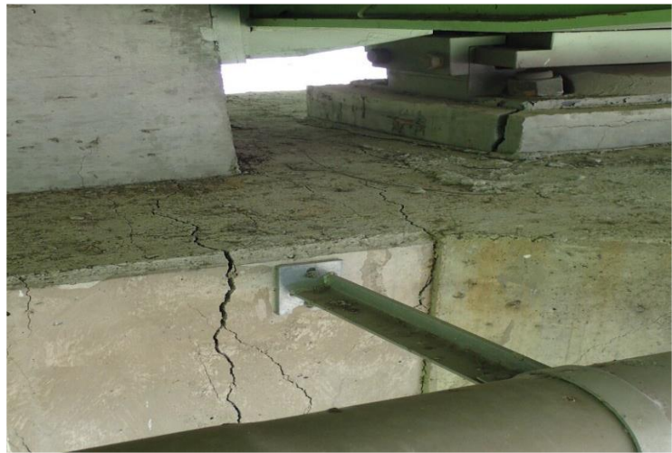
帽梁頂面及中央支承水泥砂漿墊塊開裂狀況
