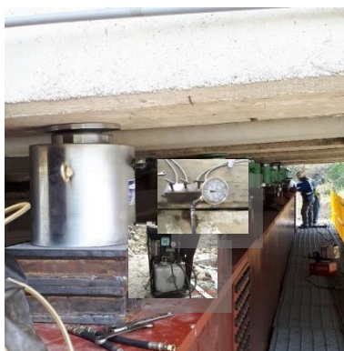
圖 2-1-4 台 3 線烏溪橋換底工程頂升千斤頂
