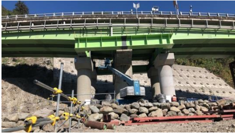
圖 1-4 先建後拆換底工法第一種方式[下部結構整體改建(含帽梁)]
