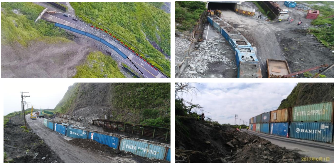
圖 6-1 貨櫃工法防落石牆構築照片
