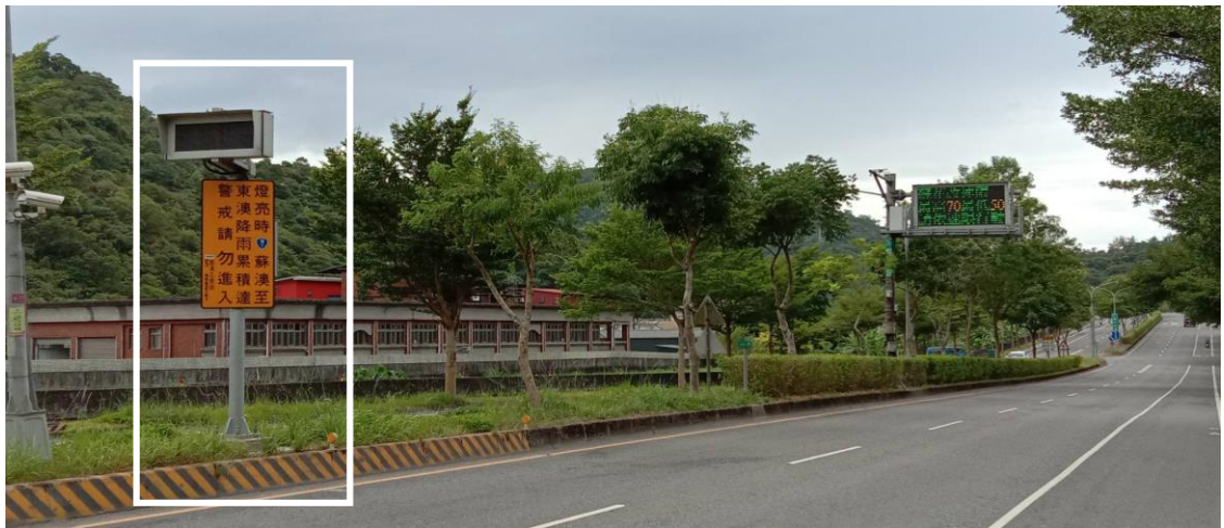
圖 9-2 第 2 道防線 路側風險資訊顯示系統 台 9 線 101.4K (蘇澳新站前)
