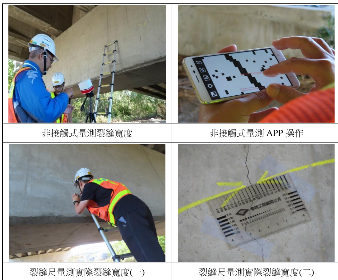
圖 4-8 德照橋場域驗證作業照片
