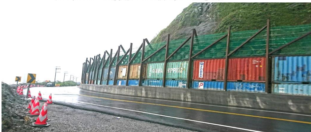
圖 6-2 貨櫃防落石牆完成照片 (H=5.2m 二層貨櫃+ H=3m 防落石柵)
