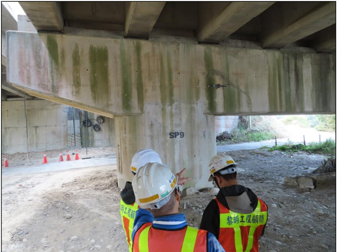
圖 5-11 無人機裂縫拍攝作業
