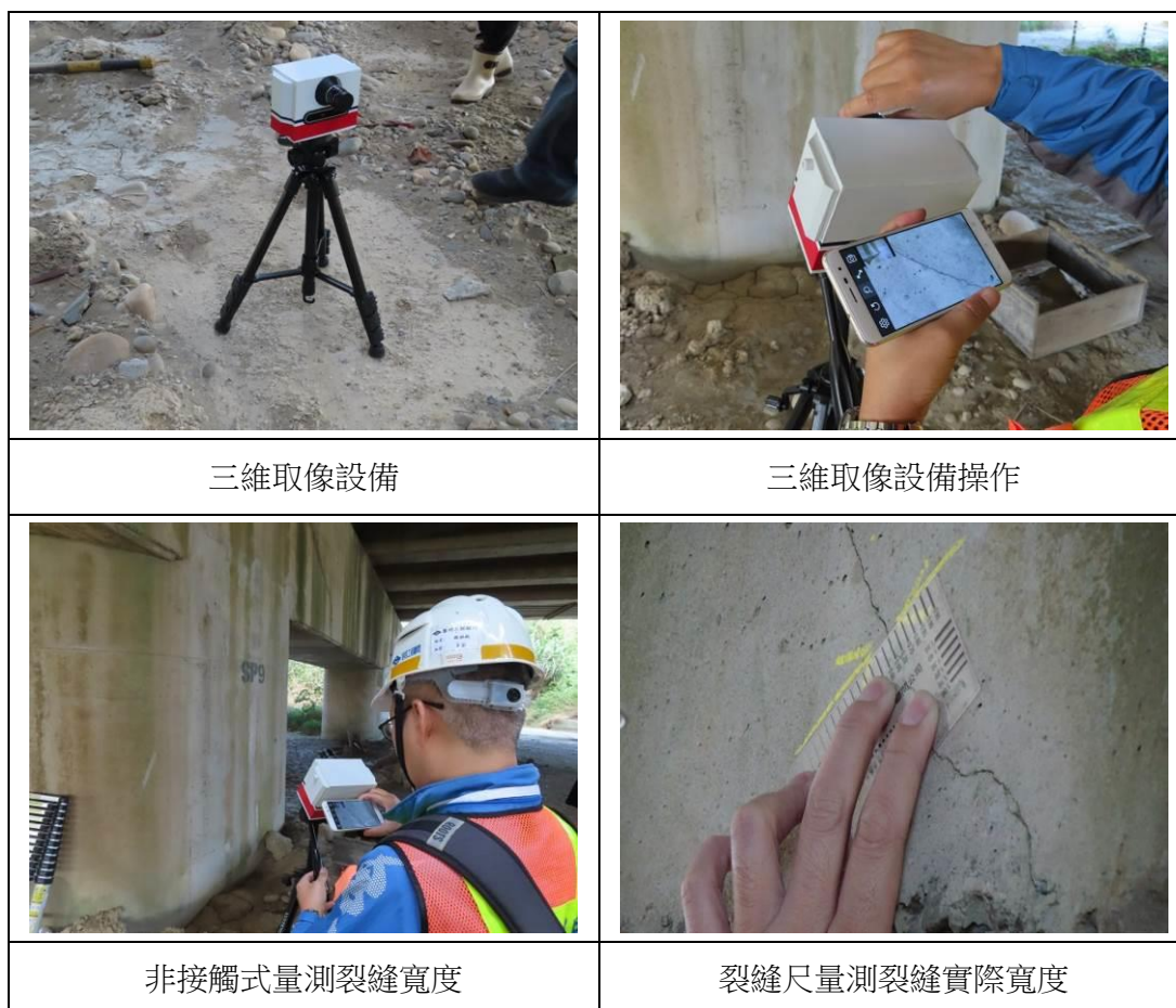
圖 4-3 西湖溪橋場域驗證作業照片
