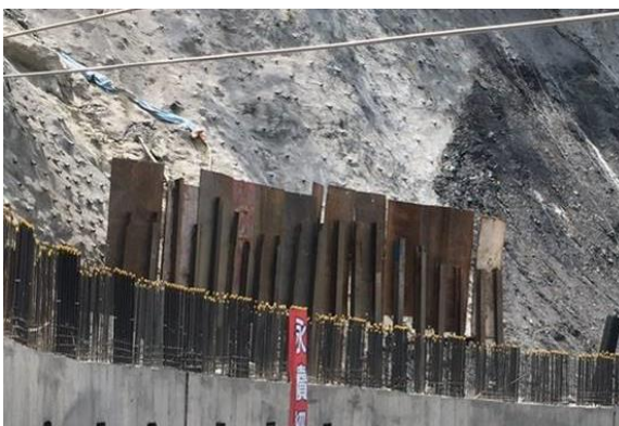
(5) 以型鋼及鋼板作為擋落石設施
