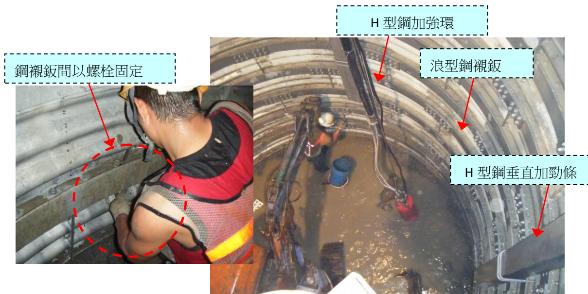
圖 19 集水井開挖及鋼襯板組立作業
