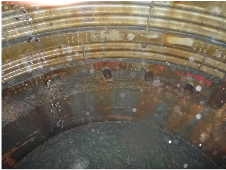
圖 24 W-8 靜水池蓄水（消能）現況
