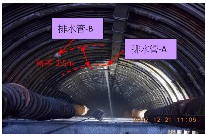
圖 27 W-7 水平排水管連通於 W-6 集水井現況（排水測試，已安裝彎管消能）
