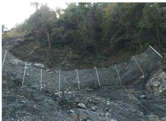
（1）落消能式落石防護網
