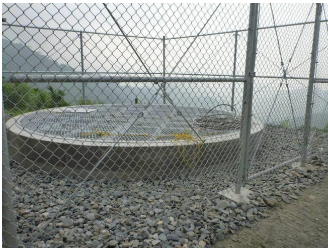
圖 26 W-1 集水井井蓋及圍籬安裝完成現況
