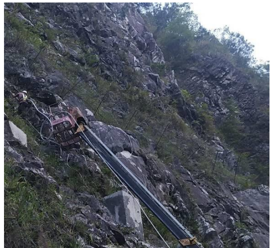
(4) 設置臨時落石防護網
