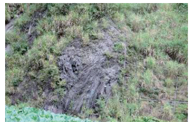
照片 A6 台 7 甲線 25K 道路邊坡剪裂帶出露
