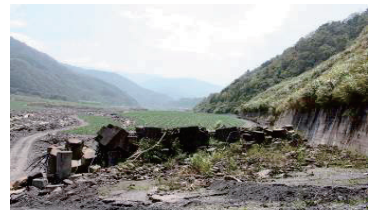
照片B3 26k+100下邊坡丁壩現地僅留存一道
