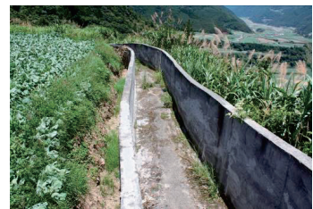
崩塌邊坡頂部設置橫向截水溝
