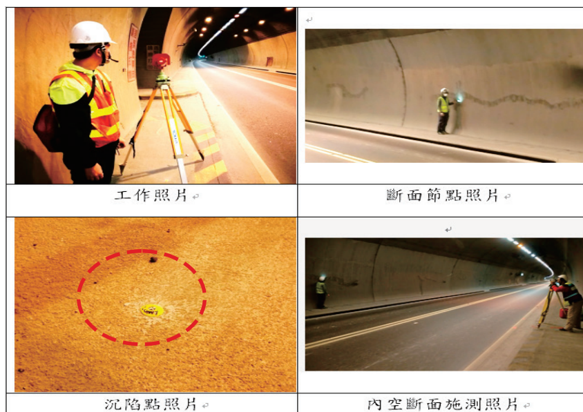
圖 4-8 觀音山隧道內空斷面施測照片
