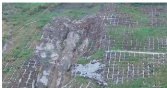
照片B7 26k+100上邊坡整治坡面出水
