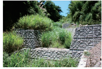
東澳頂2號坑護岸改善工程
