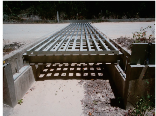
隧道式廊道正面照
