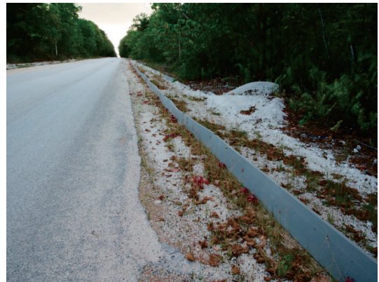
隧道式廊道的金屬板阻隔圍籬
