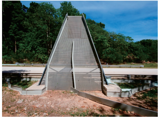
天橋式廊道內陸側阻隔及引導圍籬
