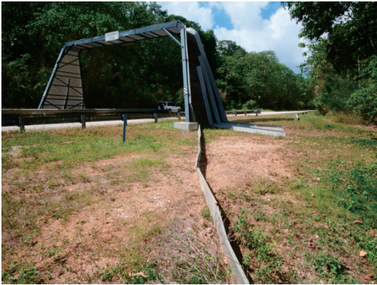
天橋式廊道靠海側阻隔及引導圍籬
