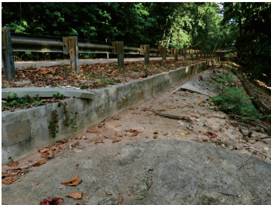
隧道式廊道的水泥阻隔圍籬
