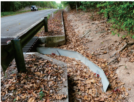
隧道式廊道口的引導金屬隔板
