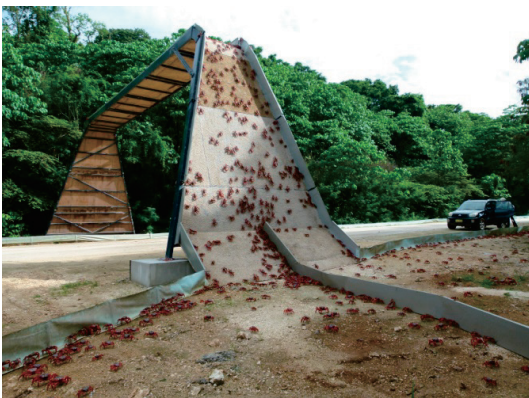
紅地蟹攀爬天橋式廊道跨越馬路
