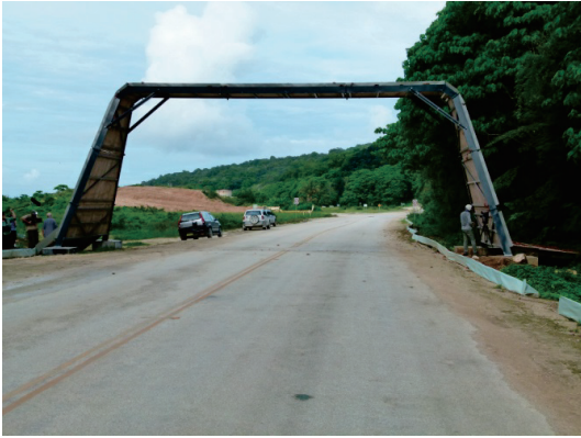
天橋式廊道側面照
