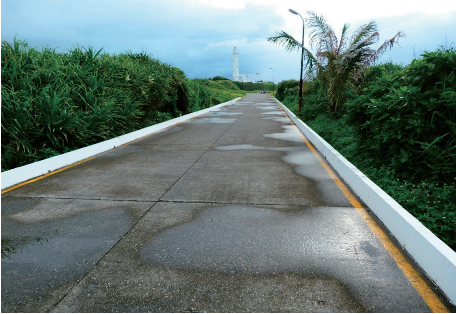
圖4.1 綠島燈塔附近的陸蟹生態廊道設施是由沿著馬路兩側200公尺長的阻隔矮牆；及在矮牆的70公尺處與140公尺處設置一條馬路下的排水溝及一條涵管所組成。
