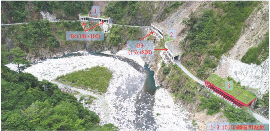
(3) B3 及 B4 標採明隧道防護上邊坡擴大崩塌之路段
