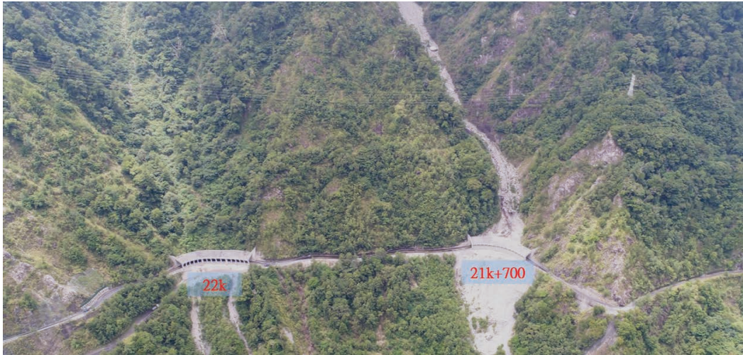
(6) B7 標於蝕溝路段設置 2 座明隧道防護
