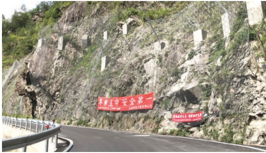
(1) 道路保全需巡檢路況是否正常
