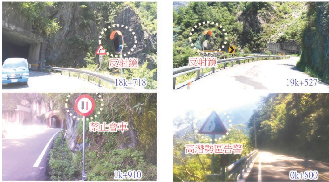
照片 10 提升市區客運乙類大客車通行安全相關交通工程措施
