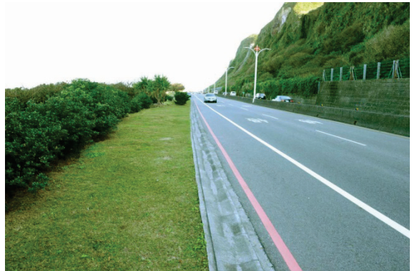
圖 35 鋪設草皮及 U 型淺水溝
