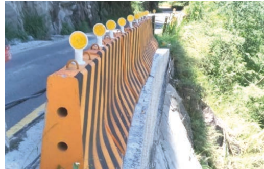
(2) 採用鑲補工法補足路基寬度
