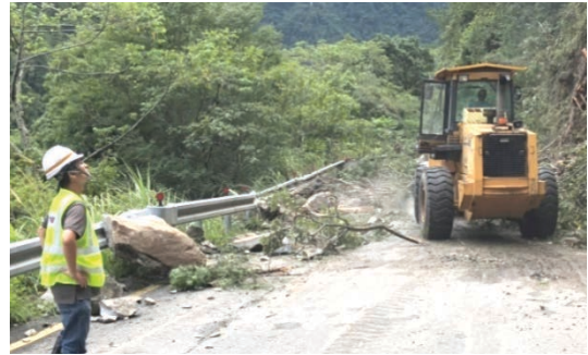
(4) 工程司監看坡面下進行道路清坍
