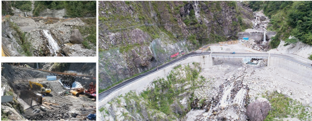
(7) B8 標 17k+100 於野溪路段以鋼便橋跨越防護
