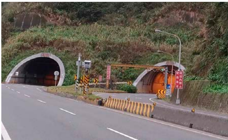
圖 6 隧道口設置固定式測速照相儀器
