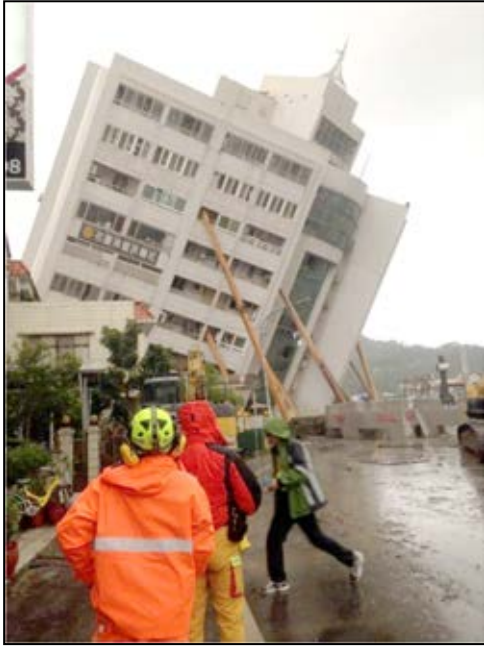
圖 29 雲門翠堤大樓臨時鋼梁支撐搶救
