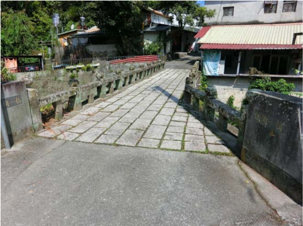
照片 3-4 橋面以長石板鋪設，護欄為石造欄杆
