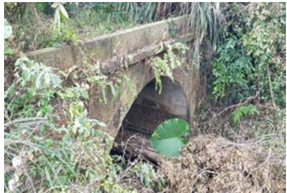
石橋照1 獅潭 永通橋，民52年7月竣工。
