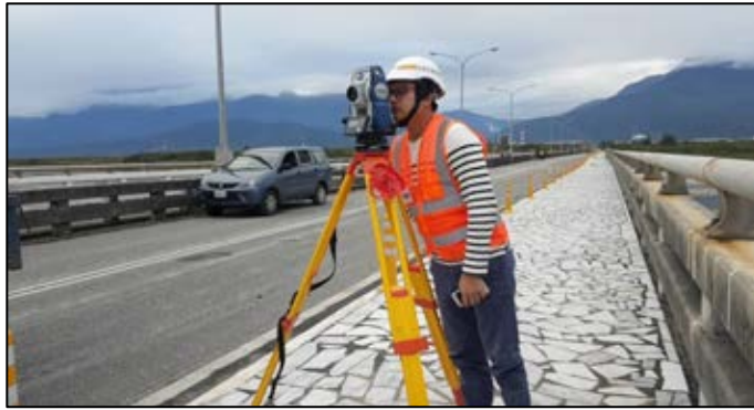
圖 27 工務段工程司辦理變位測量
