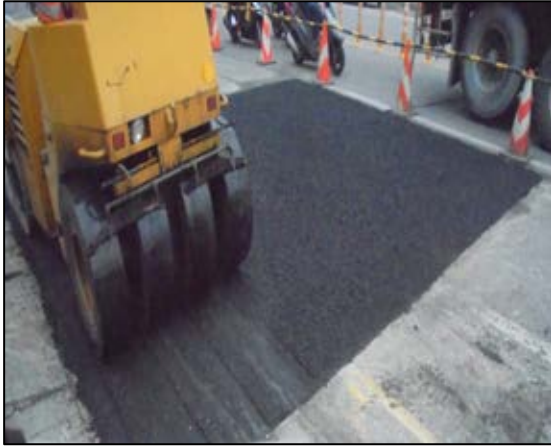
圖 17 台 9 線 204k+600 路面修補
