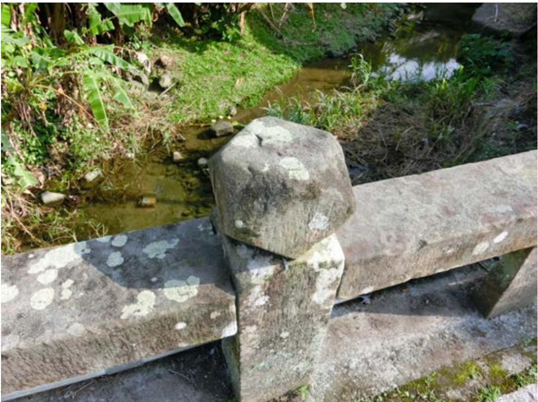
照片 3-5 簡樸的柱頭雕飾，接合處係以榫接結合
