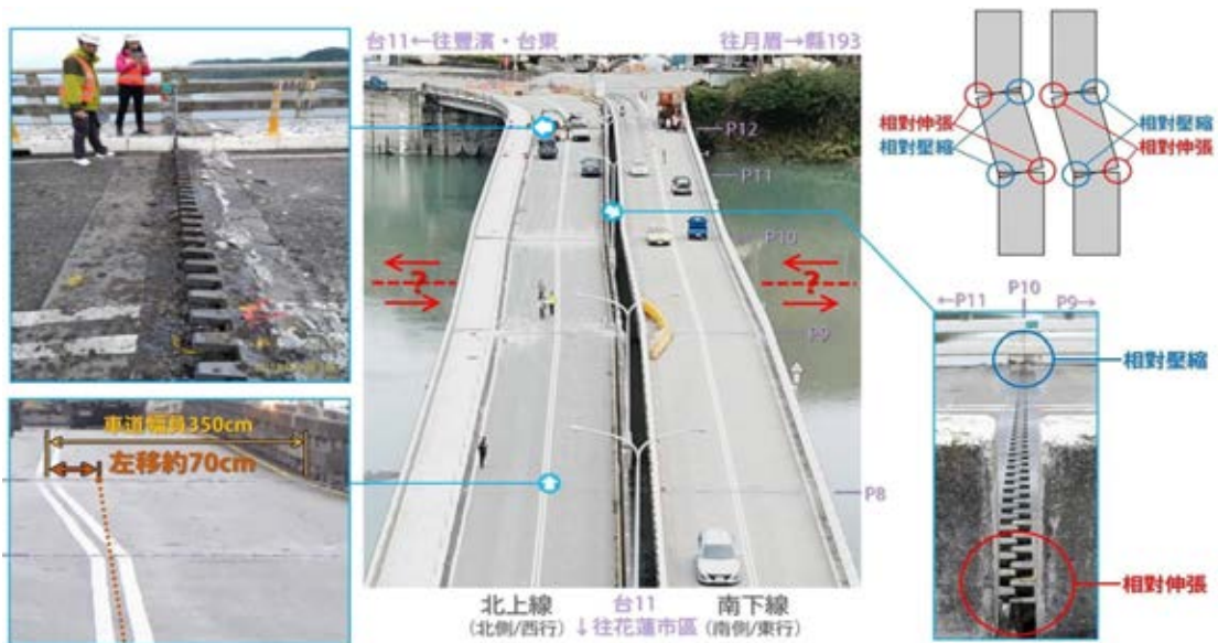
圖 26 P10 跨斷層水平錯動，位移致中心線偏移，相對位移約 70cm
