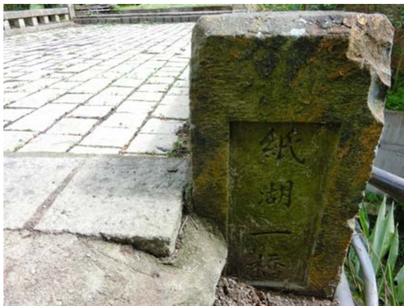
照片 4-3 橋名柱上刻有「紙湖一橋」。
