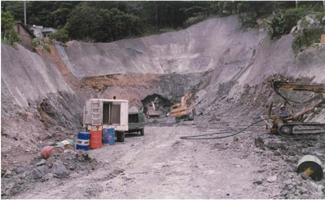
照片 7-2 百壽隧道北洞口，民國 82 年施工（吳鈞堂科長提供）。
