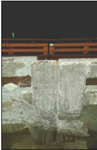
圖 8 台 11 線花蓮大橋南下 P8、P9 護欄剪裂
