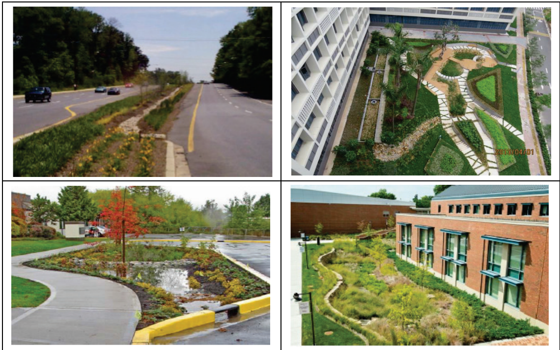
圖 2.3 植生滯留槽案例照片
