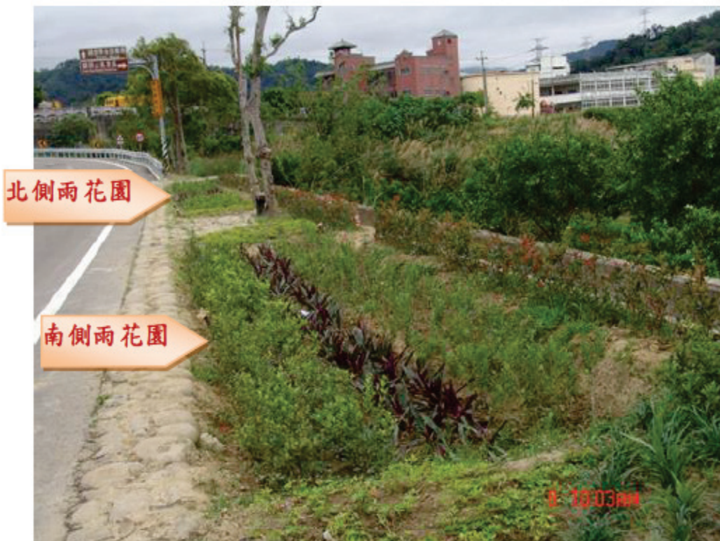
(a) 剛完工階段現況照片 (104 年 10 月 9 日攝)
