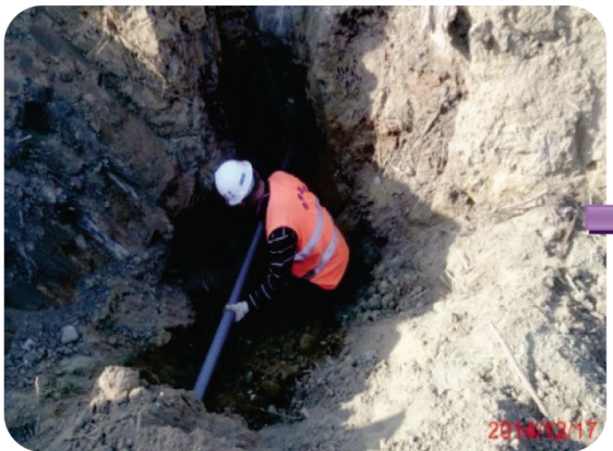
排放 PVC 集水管
