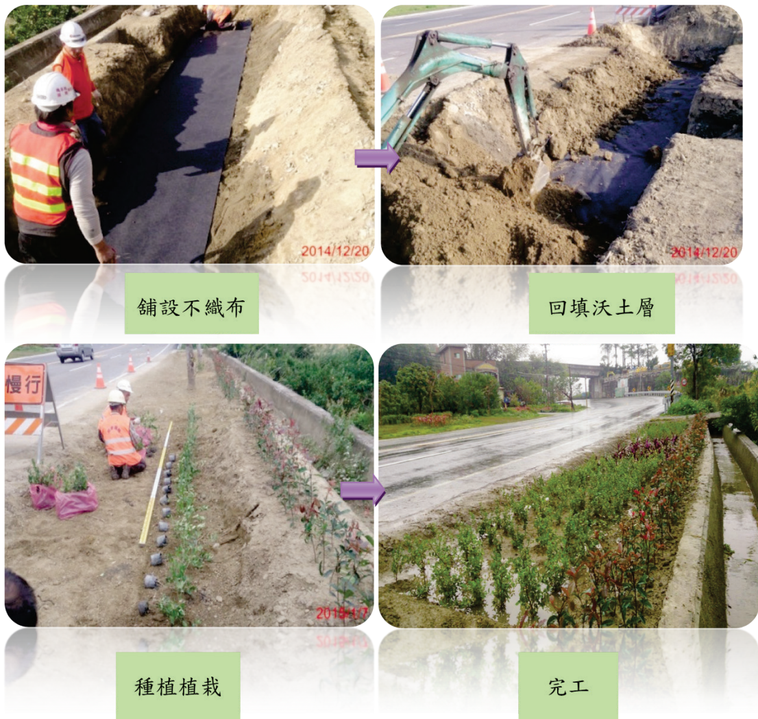
圖 3.3 雨花園施工流程照片
