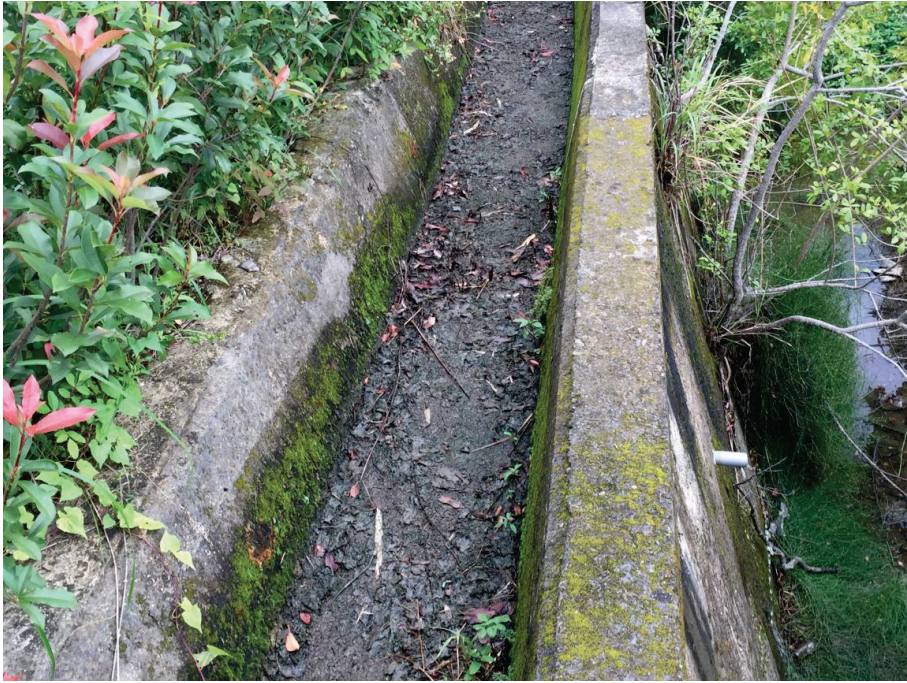
圖 3.8 北側雨花園下方排水管之出流水
