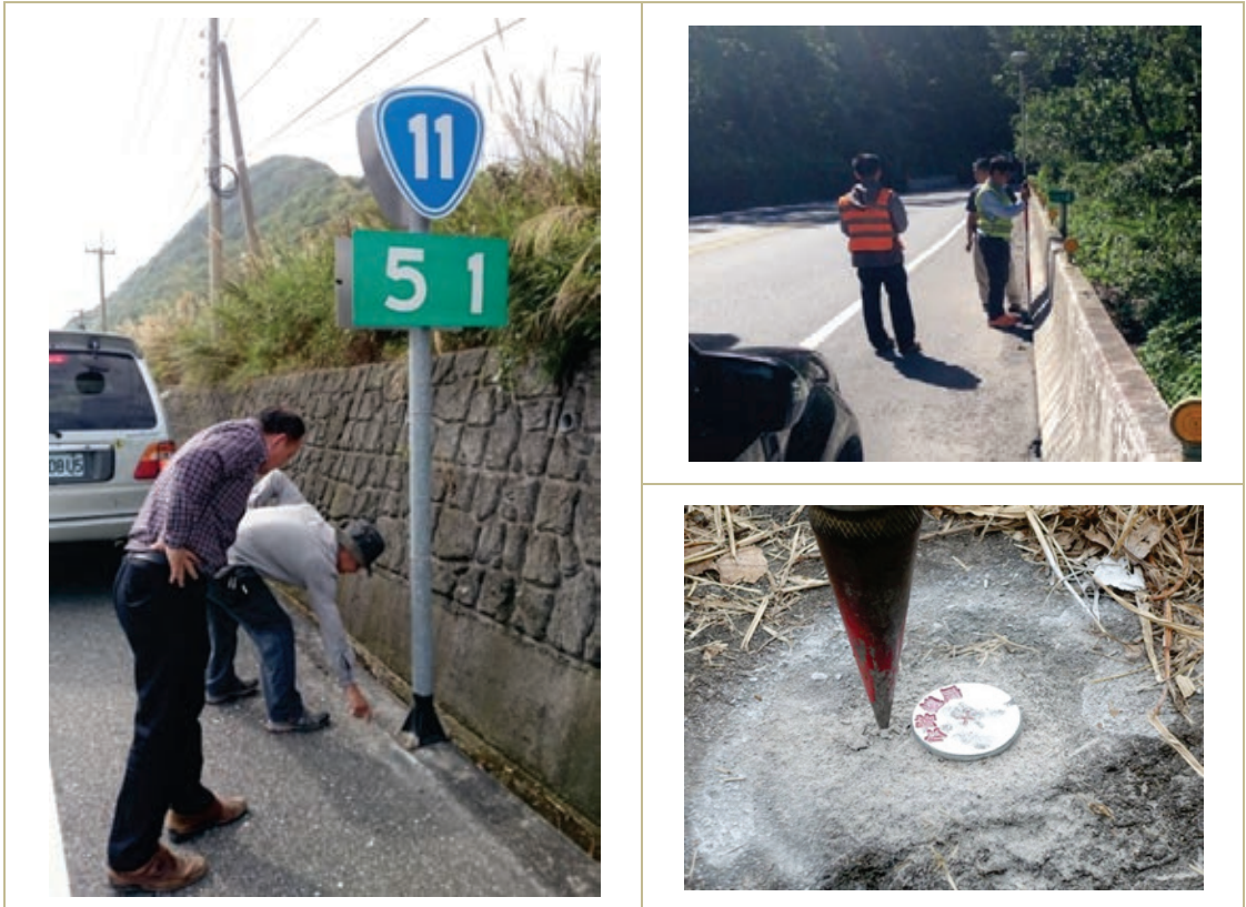
圖 5 鋼釘檢查作業
