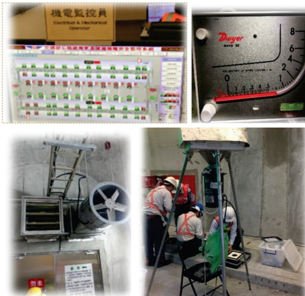
圖 5.2 隧道環境檢測
