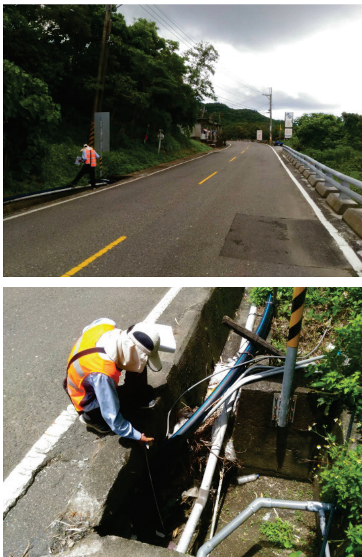
圖 8 外業調繪工作照（上：現場確認涵管、下：量測涵管孔徑）
