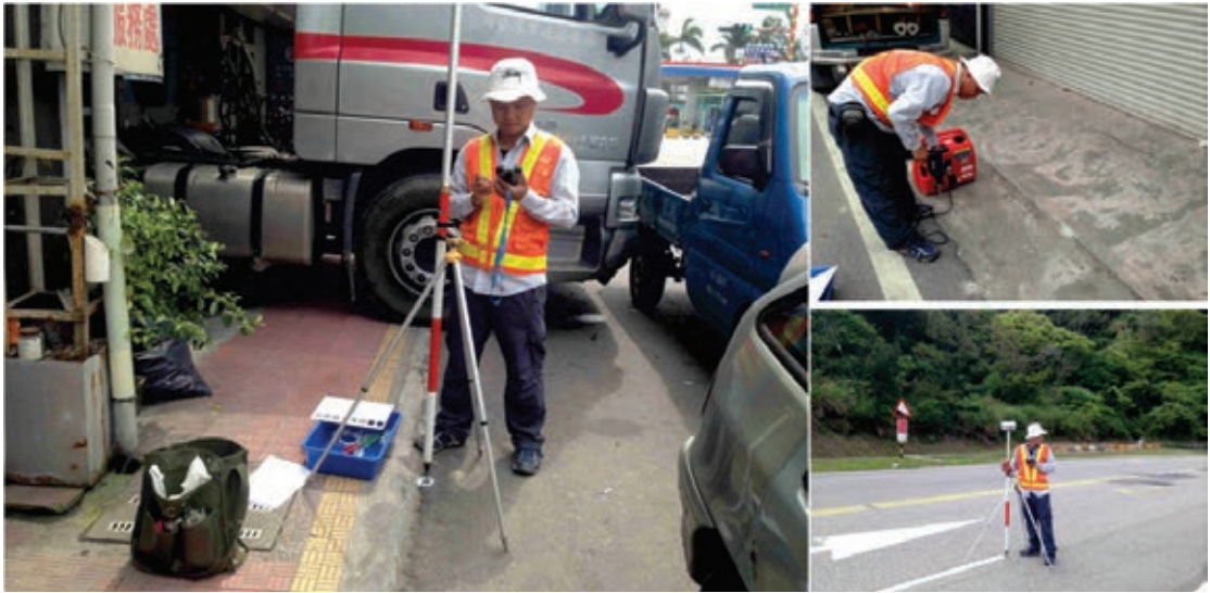
圖 4 各里程樁設置位置之現場放樣釘設工作照 (左、右下：以 VRS 放樣里程樁位置，右上：鑽孔釘設鋼釘)
