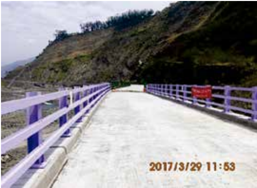
(i) 橋梁橋面板完成狀況
