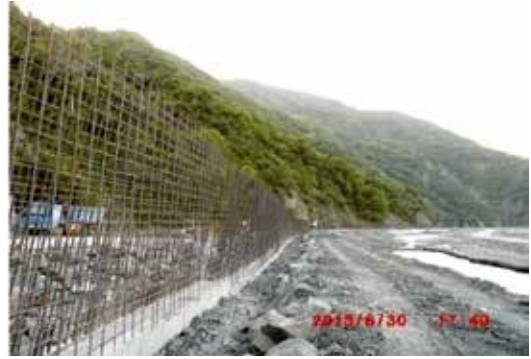
(d) 擋土牆第二昇層牆身施工
