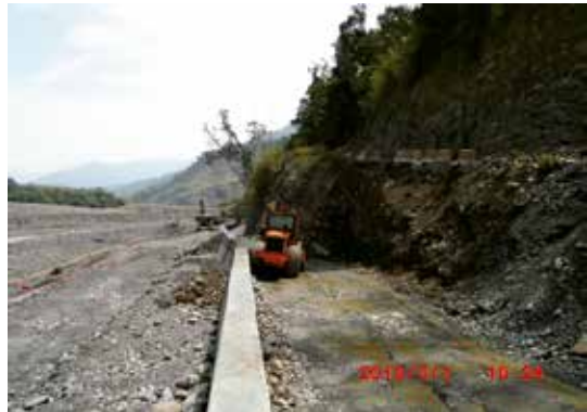
(d) 護岸背牆回填及道路基礎開挖
