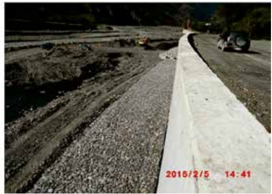
(f) 擋土牆外側異形塊及石籠保護工
