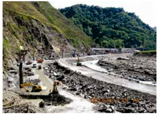
(h) 荖濃溪水退工地復原整理
