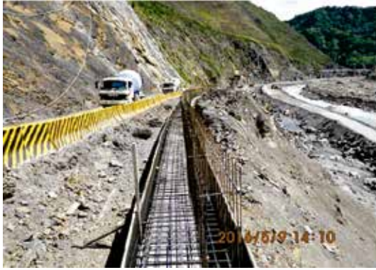
(e) 橋梁引道路堤施工
