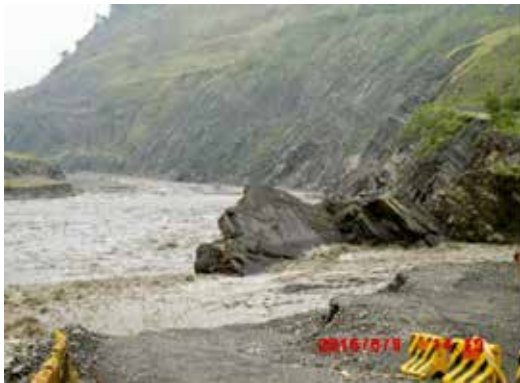
(a) 施工前荖濃溪及玉穗溪現況
