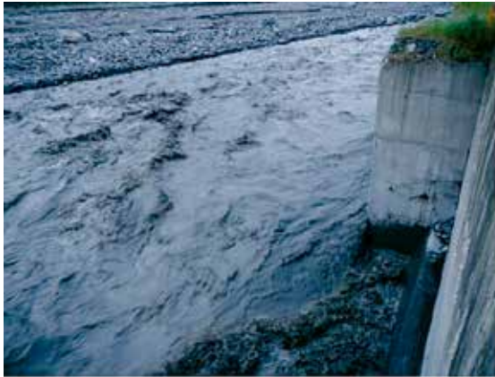
(a) 優先標 A 標擋土牆基礎受主流淘刷 (b) C 標擋土牆護岸受河水沖刷
