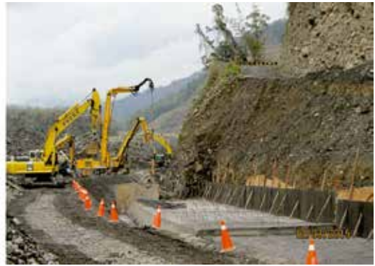
(b) 下護岸微型樁及基礎施工
