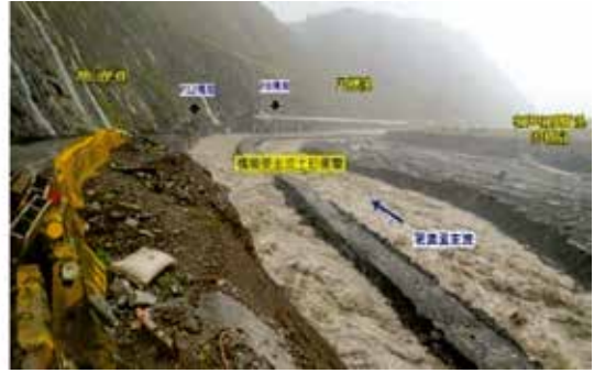
圖 15 荖濃溪溪水暴漲河床便道損毀狀況及搶修現況
