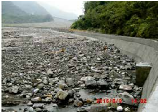
(h) 完工後荖濃溪土石淤積
