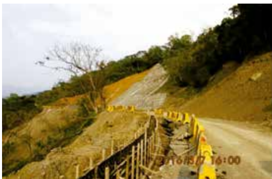
(c) 既有道路外側擋土牆施工
