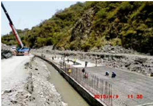
(a) 基礎鋼筋綁紮作業
