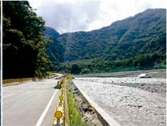
(a) 優先標 A 標擋土牆基礎受主流淘刷 (b) C 標擋土牆護岸受河水沖刷
