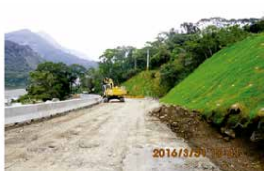
(d) 既有道路側溝及邊坡整治
