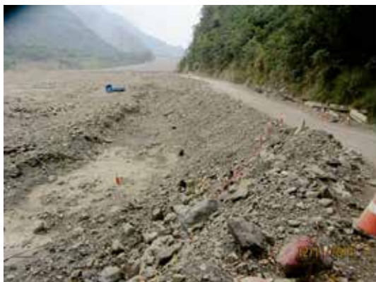
(a) 前期緊急通行河床便道
