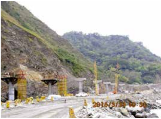
(g) 工區吊梁及帽梁施工
