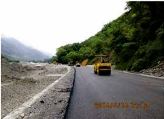
(g) 道路瀝青混凝土鋪築
