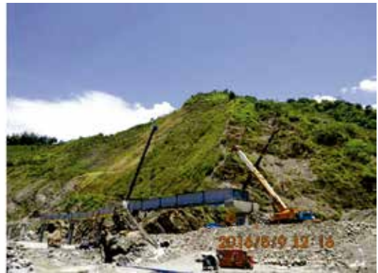
(b) 玉穗溪吊梁作業
