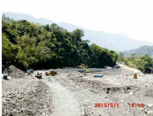
(d) 路基回填及滾壓作業
