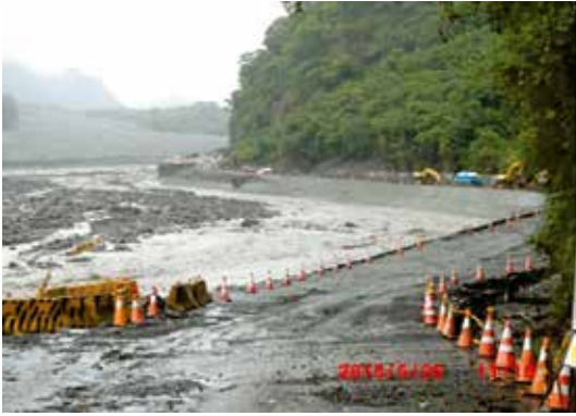
(e) 工程起點溪水暴漲情況
