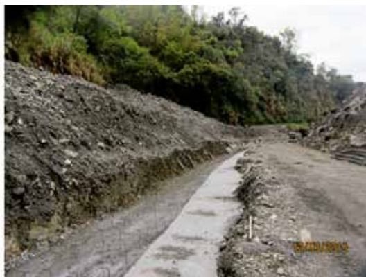
(b) 擋土牆基礎底開挖施工
