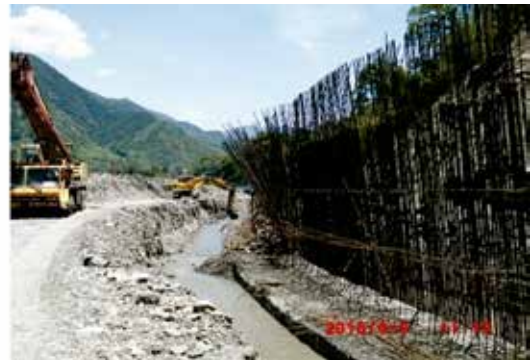
(b) 擋土牆昇層鋼筋災後整修
