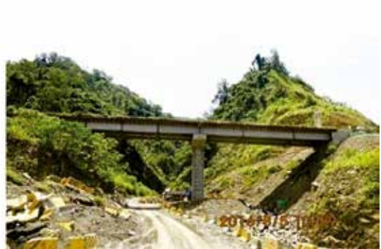
(b) 布唐布瓦那斯東溪橋梁完成
