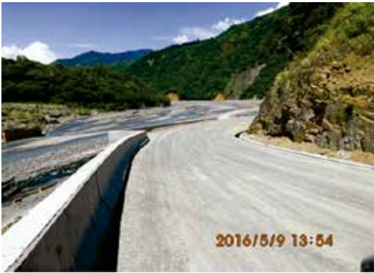
(e) 道路路基底層施工
