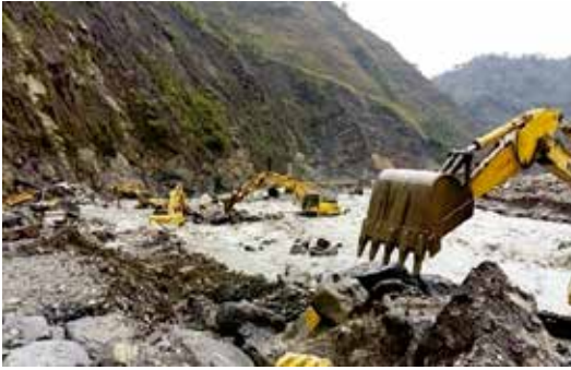
圖 15 荖濃溪溪水暴漲河床便道損毀狀況及搶修現況
