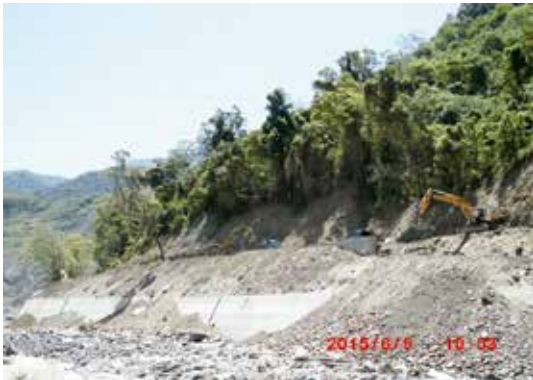
(c) 護岸工程完成及道路施工
