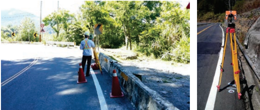
圖 15 控制點引測工作照
