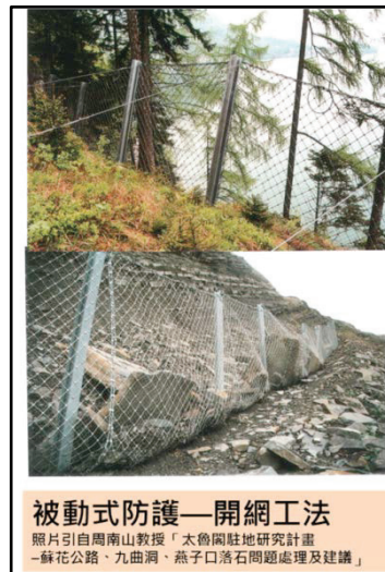
圖 3.3 被動式防護-開網工法
