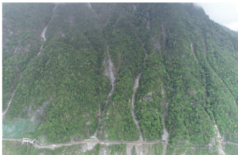
圖 3.10 蘇花公路和仁路段蝕溝造成災害
