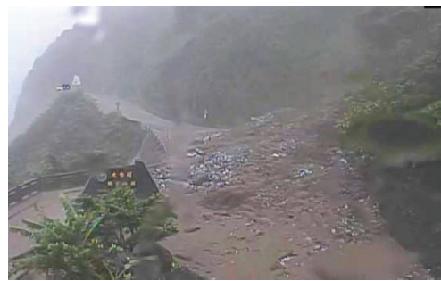
圖 3.11 蘇花公路和仁路段蝕溝(四工處提供)
