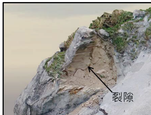
圖 2.4 節理開裂的岩盤
