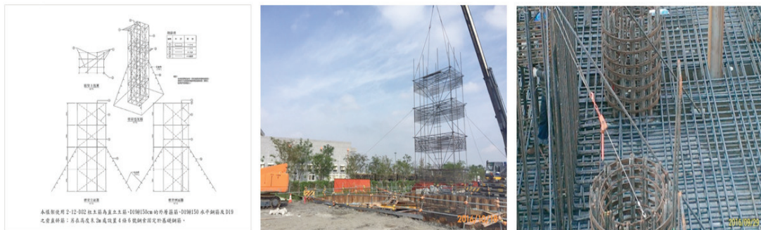
圖 5-3 鋼筋樣架及斜拉鋼索固定照片
