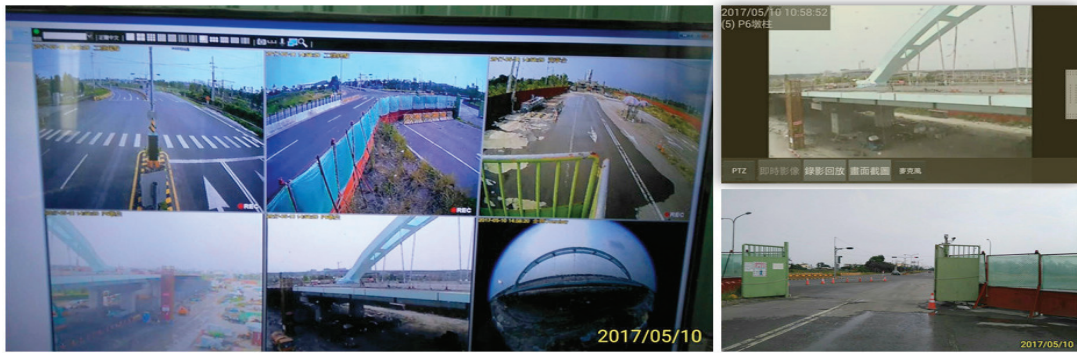
圖 5-10 CCTV 即時監控系統
