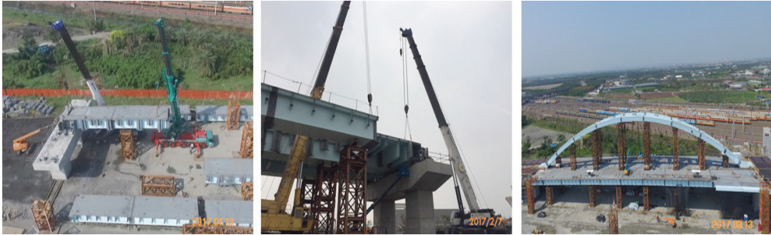
圖 5-1 鋼梁橋現場預組吊裝照片
