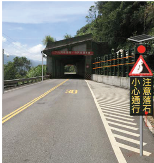
圖 3.8 台 18 線 70k+360 左側防落石柵及告警系統（五工處提供）
