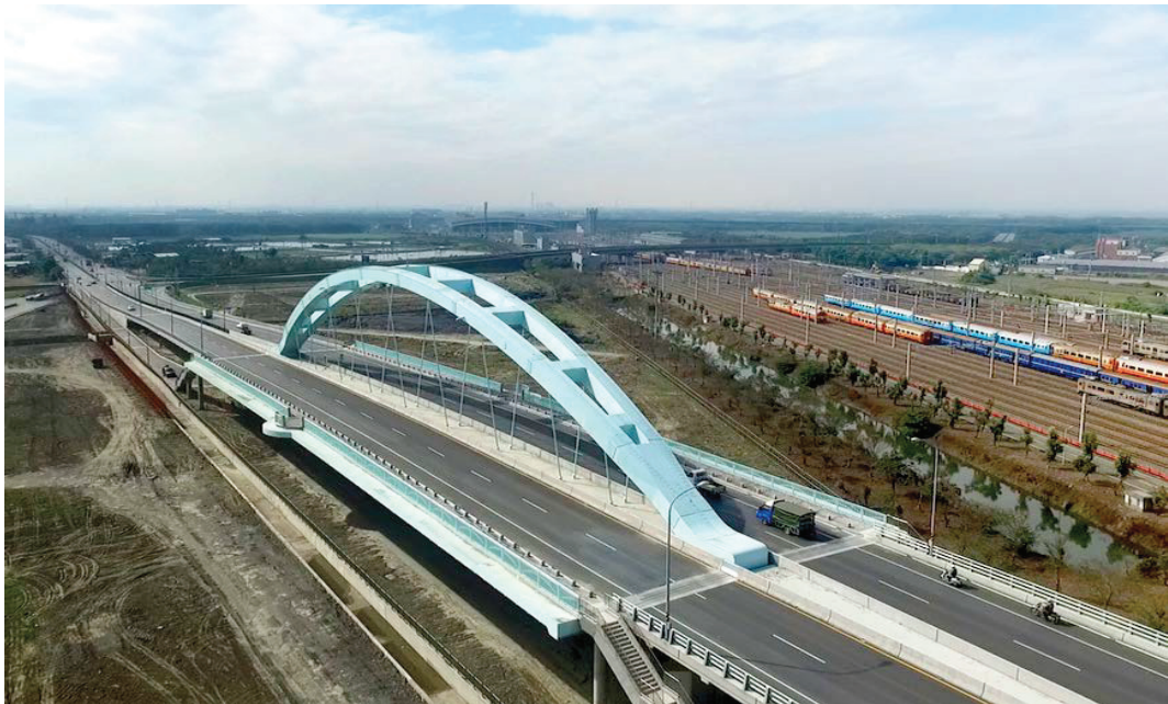
圖 2-2 完工現況鳥瞰照片
