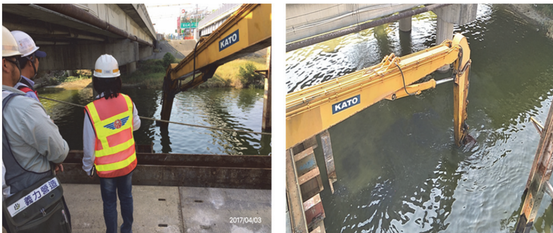
圖 5-11 加長型挖土機具探查舊橋基礎位置
