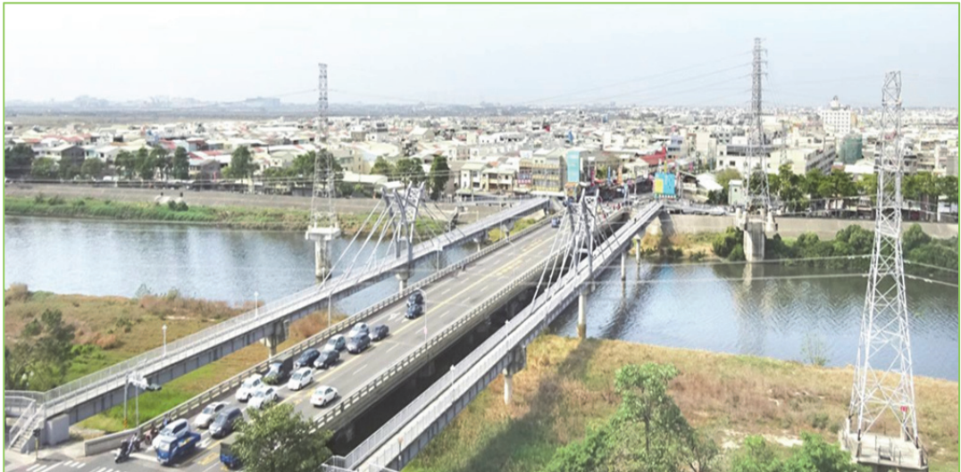
圖 2-5 鹽水溪橋改建前實景。
