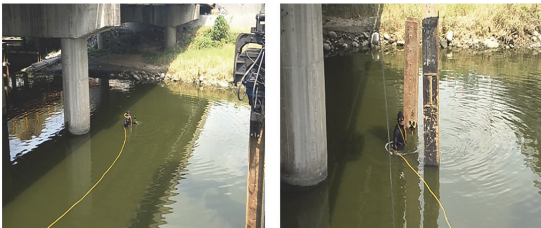
圖 5-10 潛水夫探查舊橋基礎位置
