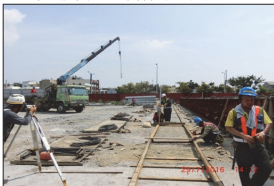
(1) 整地後放樣高程架設縱橫向角材
