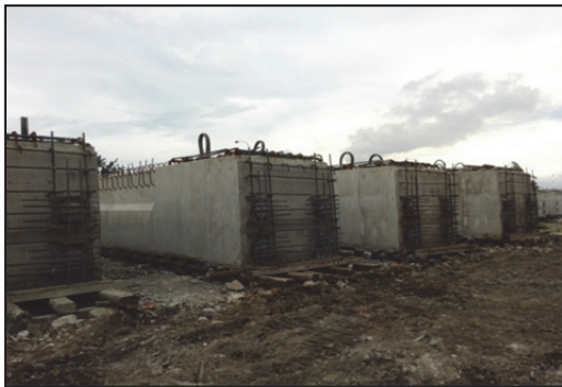
(7) 梁頭鋼筋綁紮
