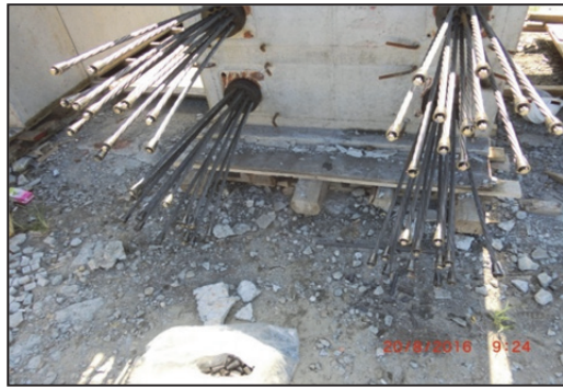
(2) 錨頭承壓板、夾片安裝
