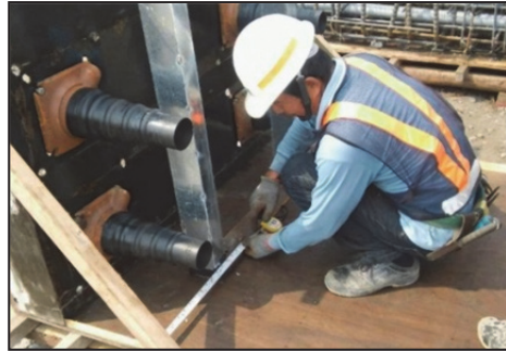
(2) 架設剪力鋼棒套管並檢核位置
