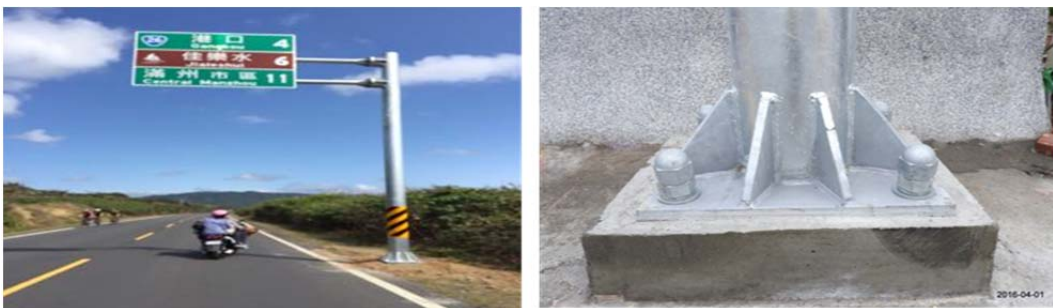
圖 14 新標誌桿設置情形
