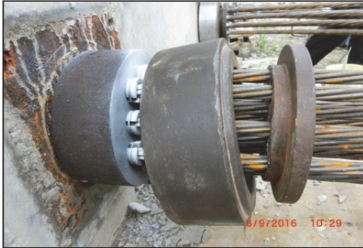
(3) 油壓機承壓套筒、端部錨定板
