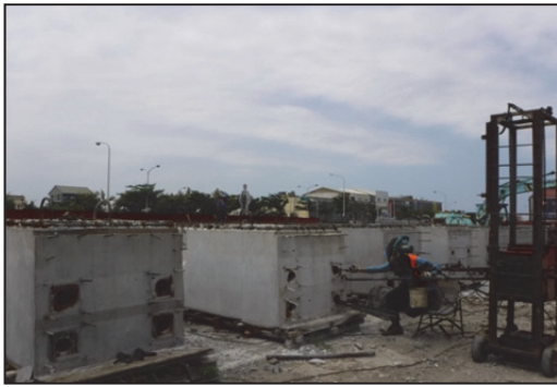
(1) 預力鋼絞線穿線
