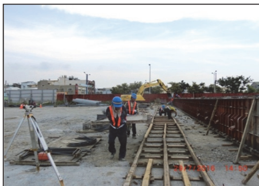
(2) 梁頭處加鋪縱橫向承壓角材
