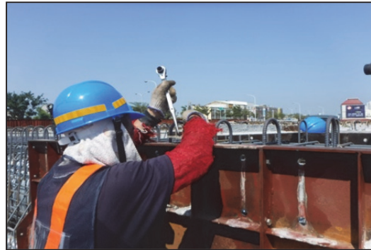
(2) 鎖固螺栓及上、下拉桿
