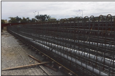
(5) 置入套管並綁紮腹筋
