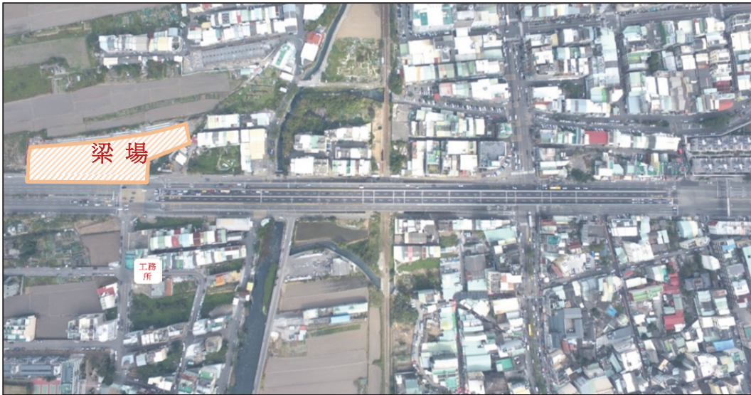
照片 3 沙鹿陸橋梁場設置於緊鄰工程起點之北側
