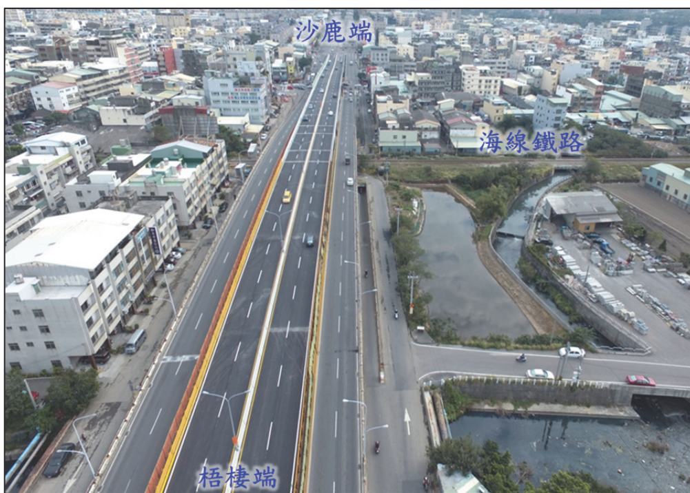
照片 1 沙鹿陸橋跨越海線鐵路且位於市區鄰房密集路段
