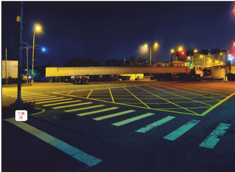
照片 2 梁場出入口應考量板車載運大梁運行情形
