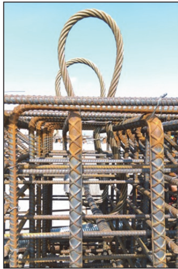
照片 11 實際於大梁端部安裝 26Ø 鋼絞索情形
