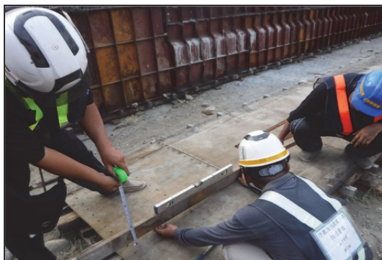
(3) 組立底模及檢測梁端調坡角度
