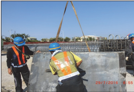
(1) 清潔模板後需塗抹水性脫水劑
