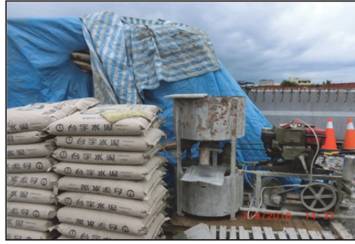
(4) 準備水泥、拌漿機及灌漿機
