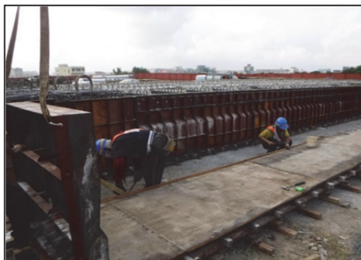
(4) 設置外露面倒角壓條及梁頭模
