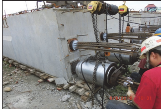
(4) 設置千斤頂及安裝反力夾片
