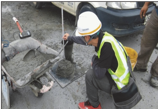
(5) 檢查混凝土坍度
