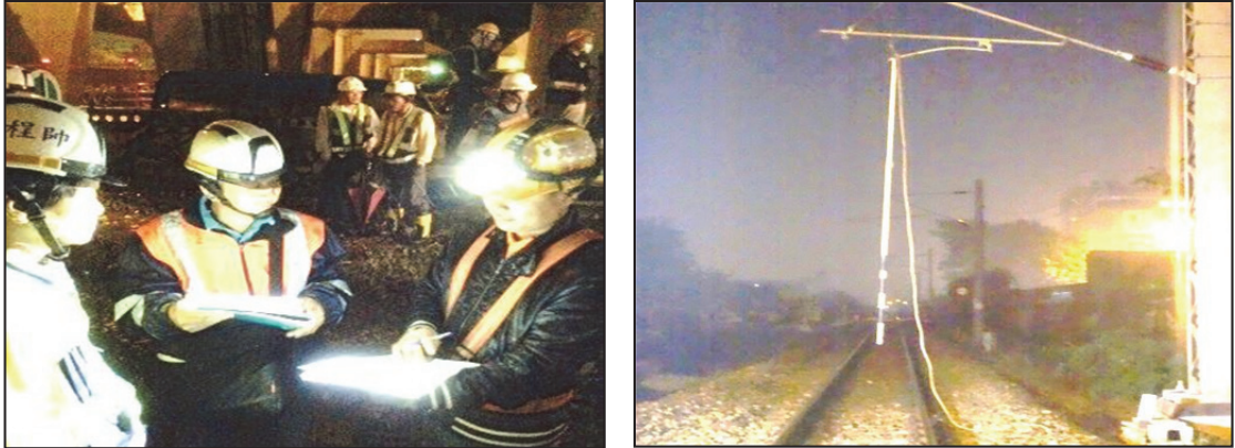
照片 10 聯繫臺鐵路人員到場（左）並進行斷電接地封鎖（右）之情形
