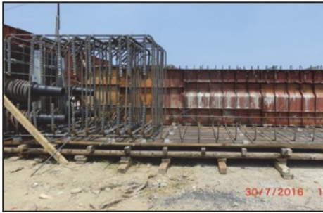
(3) 組立預力防爆筋、梁頭及底層筋
