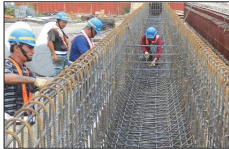
(6) 組立大梁縱向鋼筋及隔梁鋼筋
