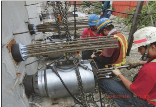
(5) 利用鋼管將夾片推至定位
