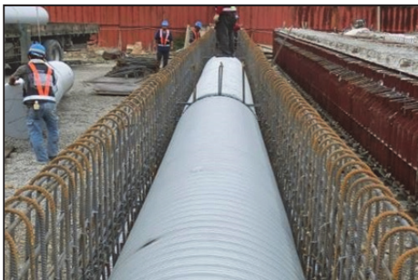
(7) 安裝旋楞鋼管
