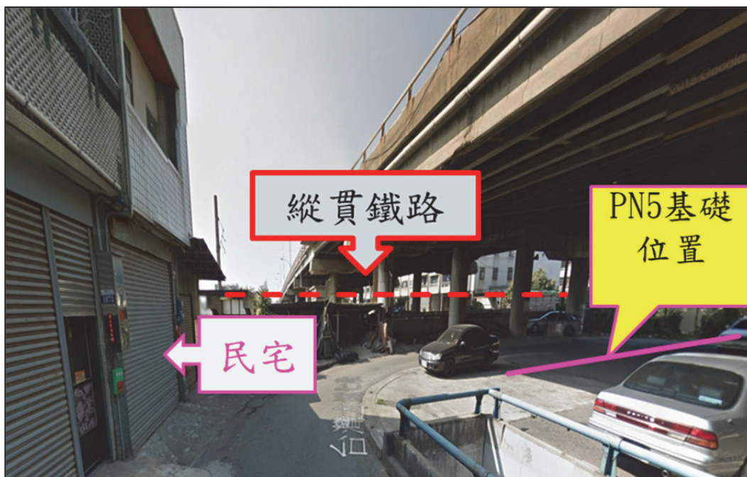
照片 4 沙鹿陸橋主線橋墩 PN5 施工前現況
