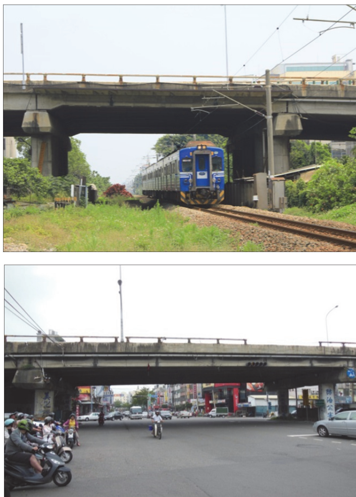
照片 2 沙鹿陸橋跨越鐵路（上）及中山路（下）需維持淨高供通行之情形
