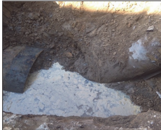
(4) 水管與推進管間灌漿保護
