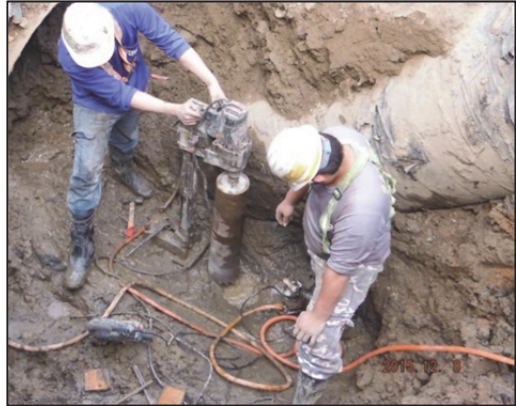
(2) 管身混凝土保護墊塊剝離
