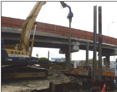
(1) 基礎周圍打設鋼板樁
