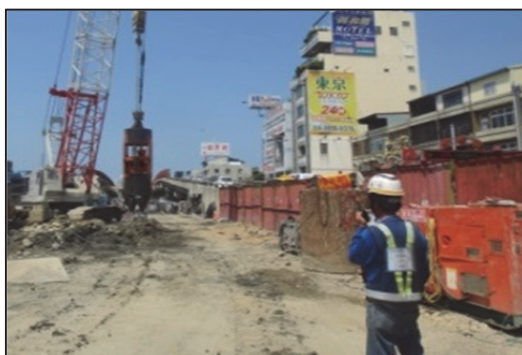
(2) 作業主管於基樁現場監看
