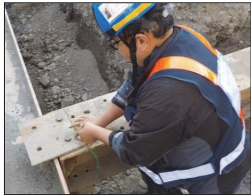
(2) 水平支撐上安裝應變計
