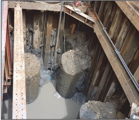
(3) 角隅處架設點井及抽水機
