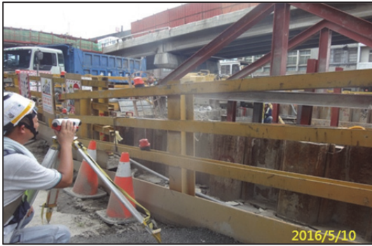
照片 13 PN5 基礎開挖後需監測山形架支承沉陷、臨鐵路及臨房之地面高程變化
