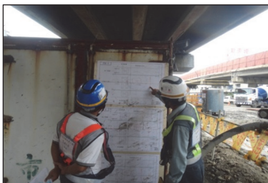
(1) 機具定位圖說張貼於現場
