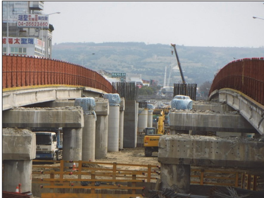
照片 9 沙鹿陸橋主線改建期間新舊墩柱相間且匝道間空間侷限
