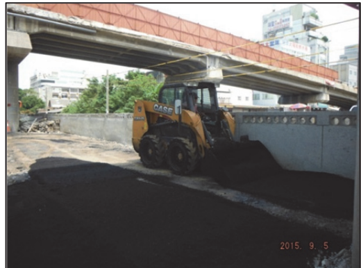
(2) 舖築瀝青混凝土
