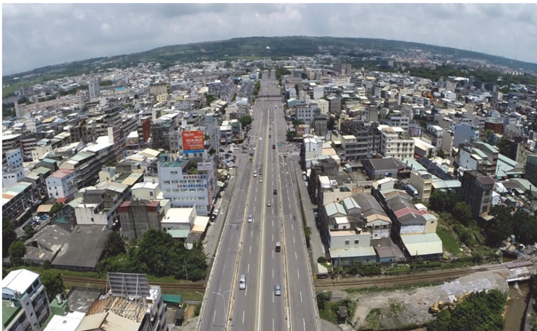
照片 1 沙鹿陸橋鄰房密集且又跨越海線鐵路及中山路
