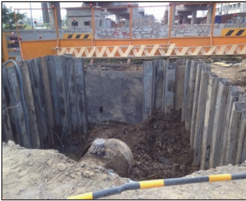
(1) 水管周圍打設鋼板樁
