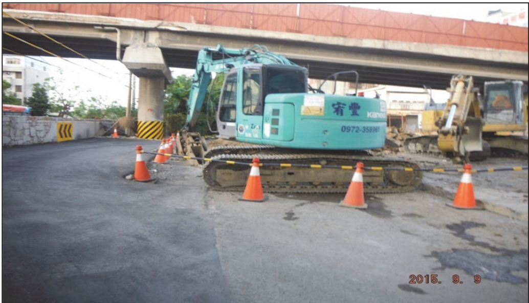
(5) 探挖作業須將機具作業範圍安全圈圍出來
