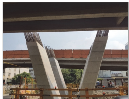
照片 15 步步為營謹慎因應下完成主線 PN5 V 型墩柱
