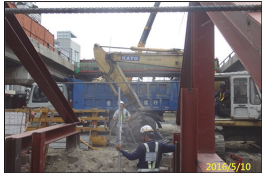
照片 13 PN5 基礎開挖後需監測山形架支承沉陷、臨鐵路及臨房之地面高程變化
