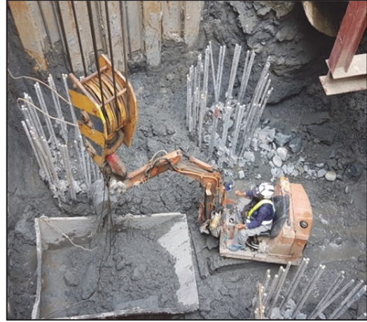
(4) 迷你挖土機及吊土桶
