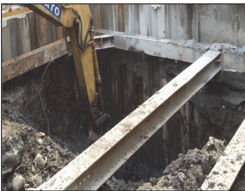
(3) 第一層水平撐架設後持續降挖
