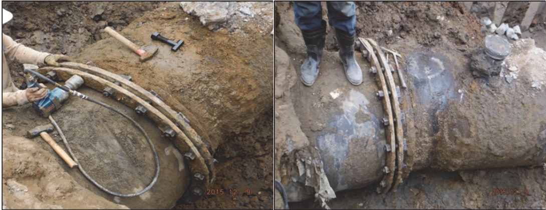
(1) 管身接合處滲水進行螺栓更新 (2) 接合螺栓更新後情形
