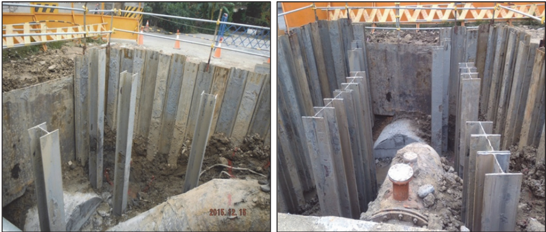
照片 8 PN5 基樁施工前於管身兩側打設 2 排 H 型鋼之力量疏導安全作業
