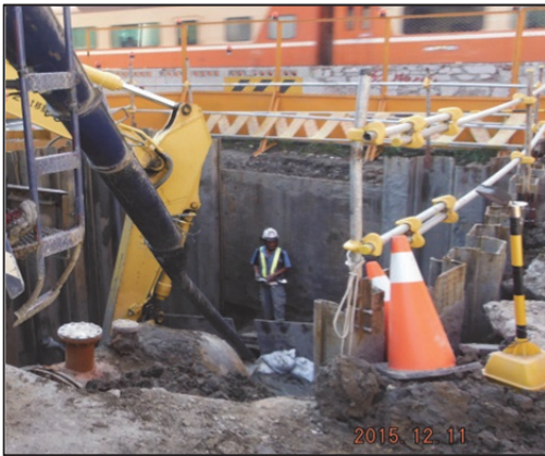
(3) 推進管與水管間灌漿穩固
