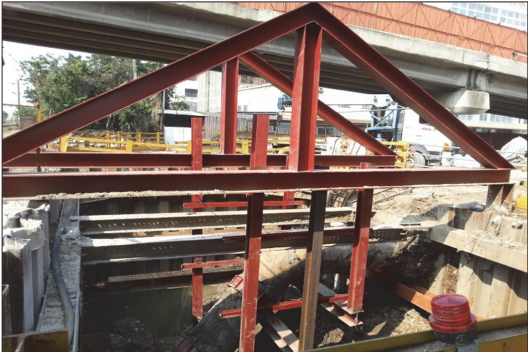
照片 12 自來水管採山型鋼吊架 3 點吊掛保護
