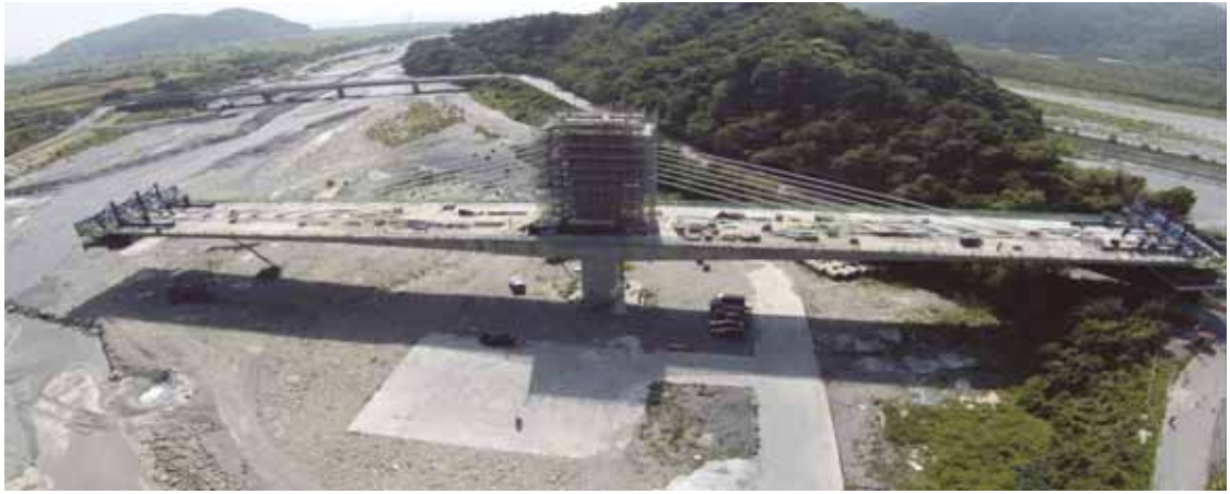
圖 3.16 蘇花公路新建工程
