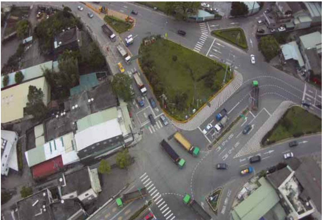
圖 3.6 台 4 線武嶺橋路口車行動線空拍
