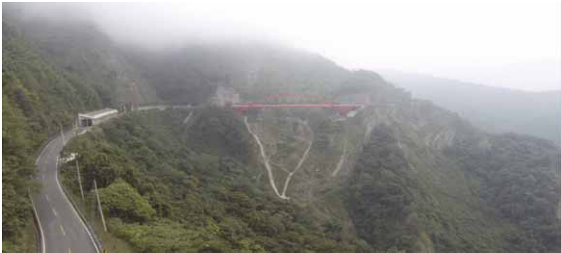
圖 3.20 台 18 線阿里山公路 芙谷峩橋
