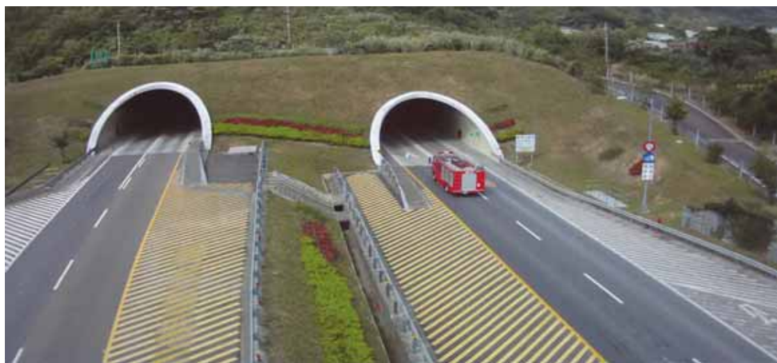
圖 3.2 台 64 線觀音山隧道防災演練
