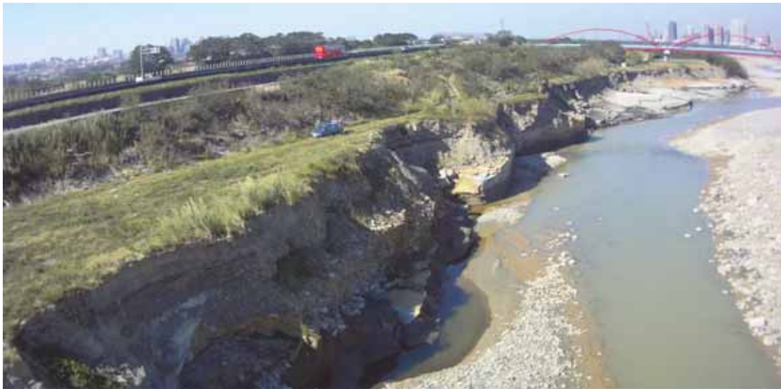
圖 3.12 台 68 線 14k+000 處河堤路段空拍
