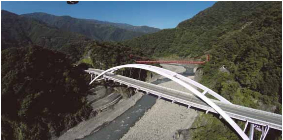
圖 3.10 台 7 線巴陵大橋上部結構檢查
