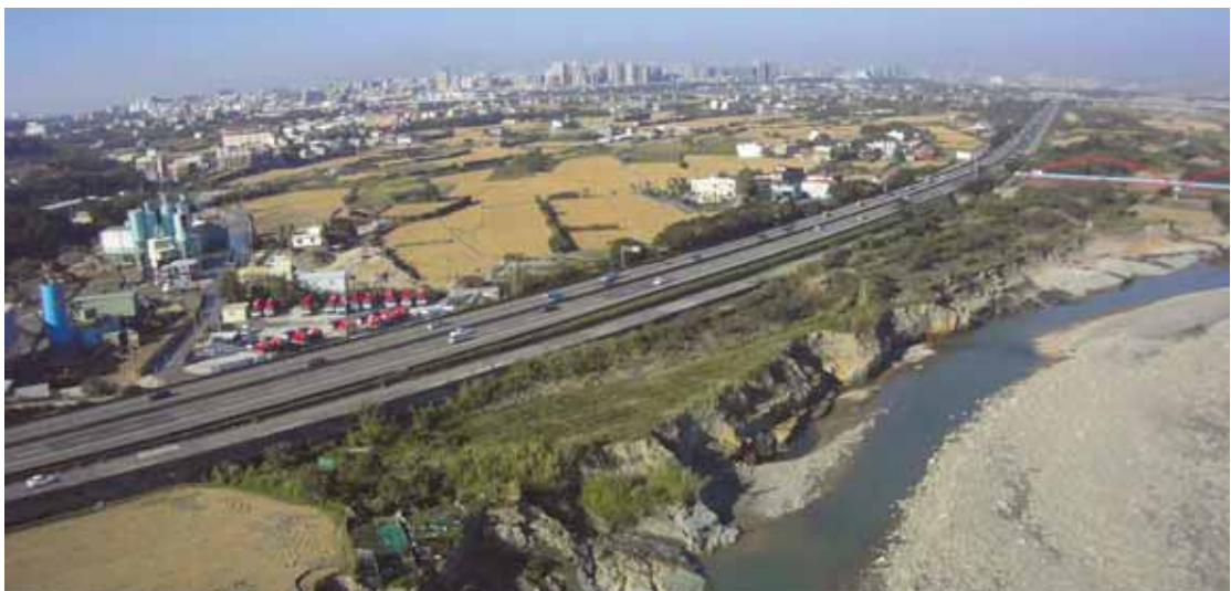
圖 3.11 台 68 線 14k+000 處河堤路段空拍
