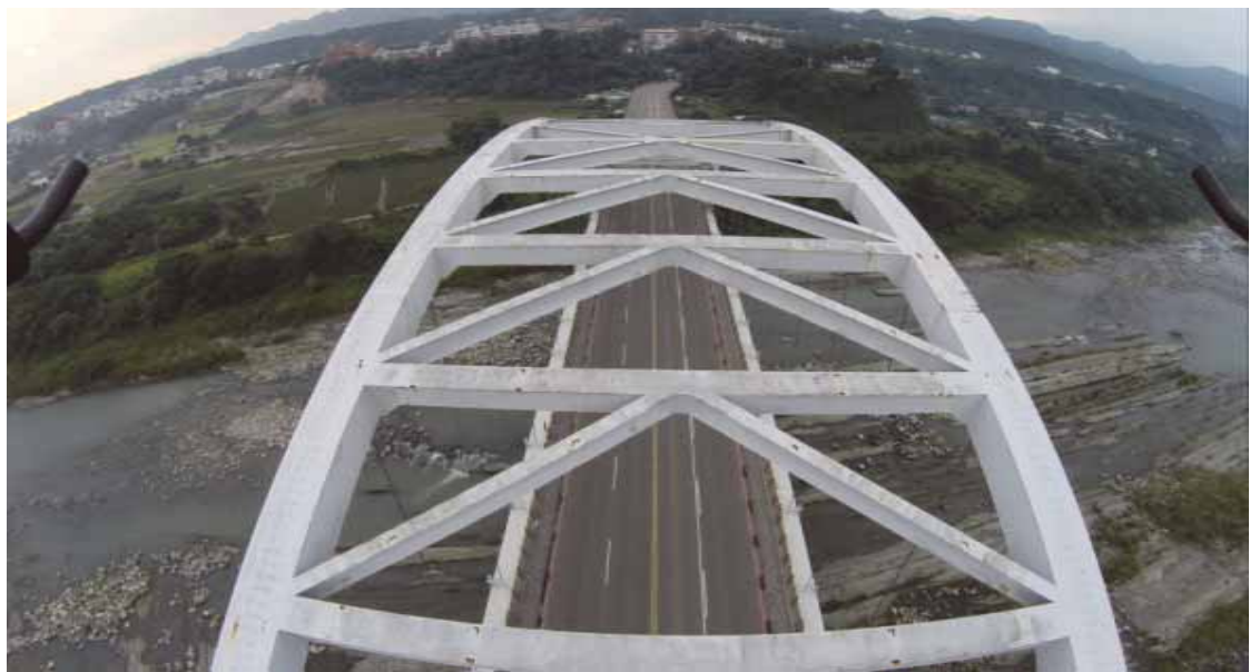
圖 3.8 台 4 線炭津大橋上部結構檢查
