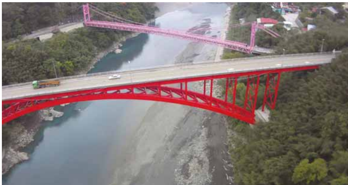
圖 3.9 台 7 線羅浮大橋上部結構檢查
