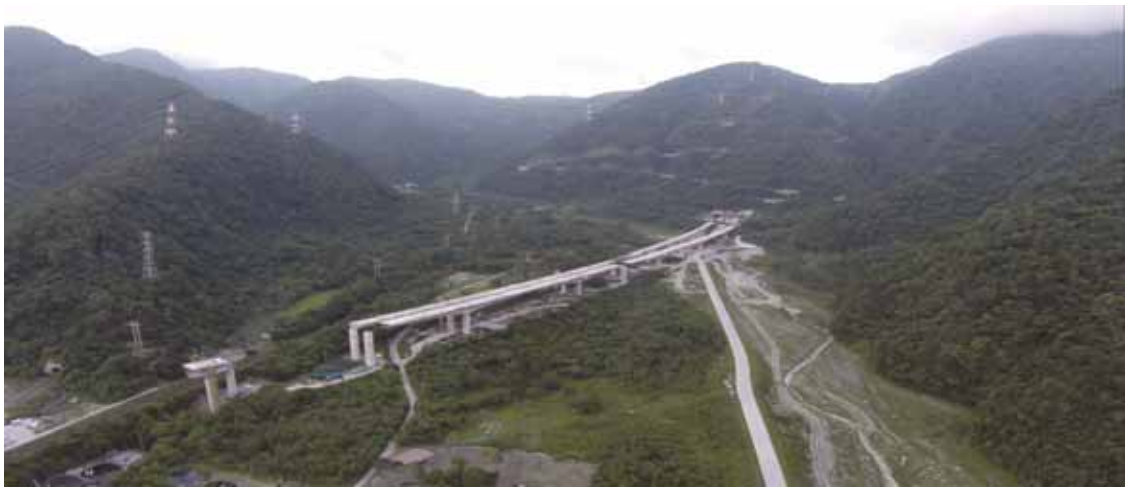
圖 3.15 蘇花公路新建工程
