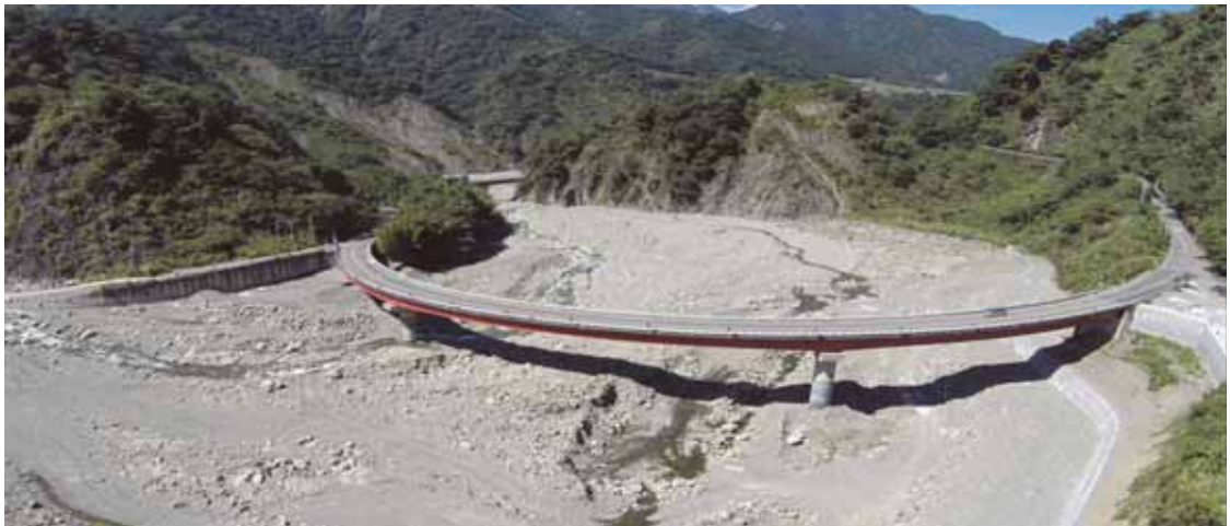
圖 3.18 台 21 線新中橫公路 109K+000-愛玉橋
