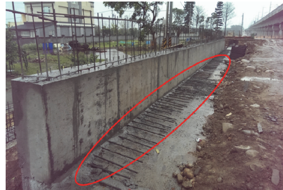
圖 4.6 溝底預留鋼筋完成(改善後)
