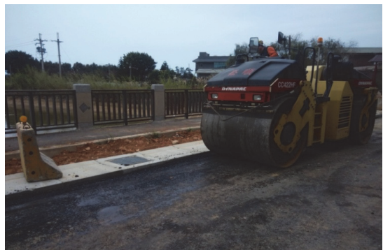
圖 5.6 溝邊縫隙二輪壓路機滾壓(改善中)
