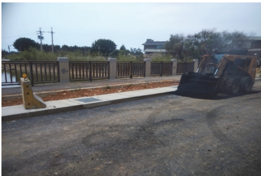
圖 5.3 溝邊縫隙鋪設瀝青混凝土(改善中)
