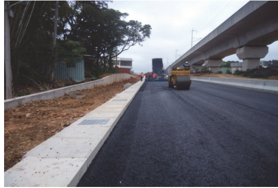
圖 5.8 先吊放溝蓋版再鋪設瀝青混凝土(改善後)
