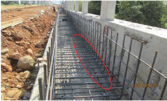
圖 4.3 溝底預留鋼筋彎折(改善前)
