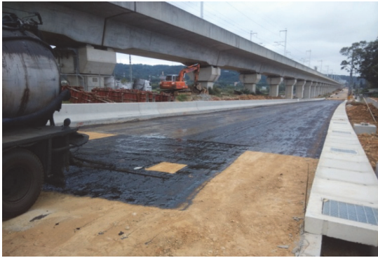
圖 5.7 先吊放溝蓋版再噴灑透層(改善後)
