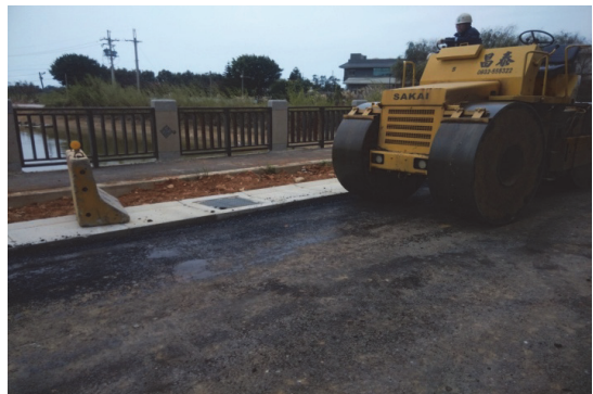
圖 5.4 溝邊縫隙三輪壓路機滾壓(改善中)
