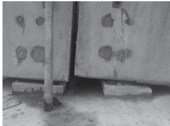
圖 2.2 梁端支承(改善前)
