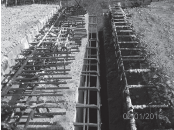
圖 3.3 托梁植筋(改善中)
