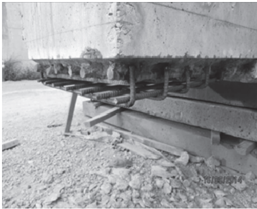
圖 2.7 梁底支承打除及鋼筋銲接(改善中)
