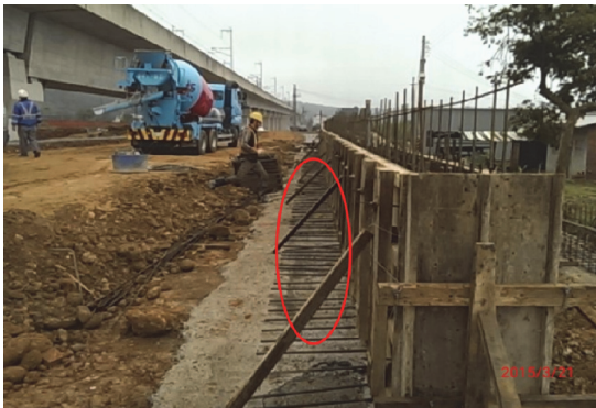
圖 4.5 溝底預留鋼筋及組模(改善後)
