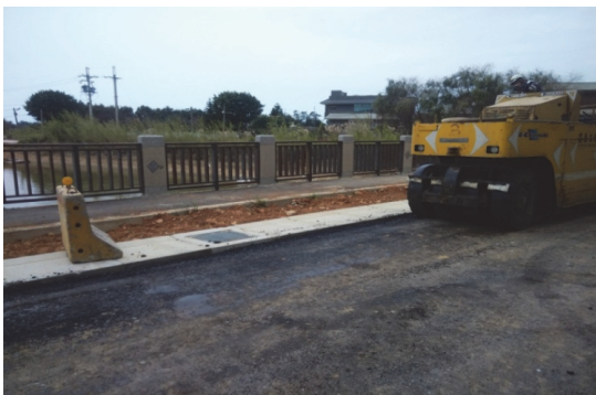
圖 5.5 溝邊縫隙膠輪壓路機滾壓(改善中)
