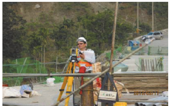
懸臂工法測量作
