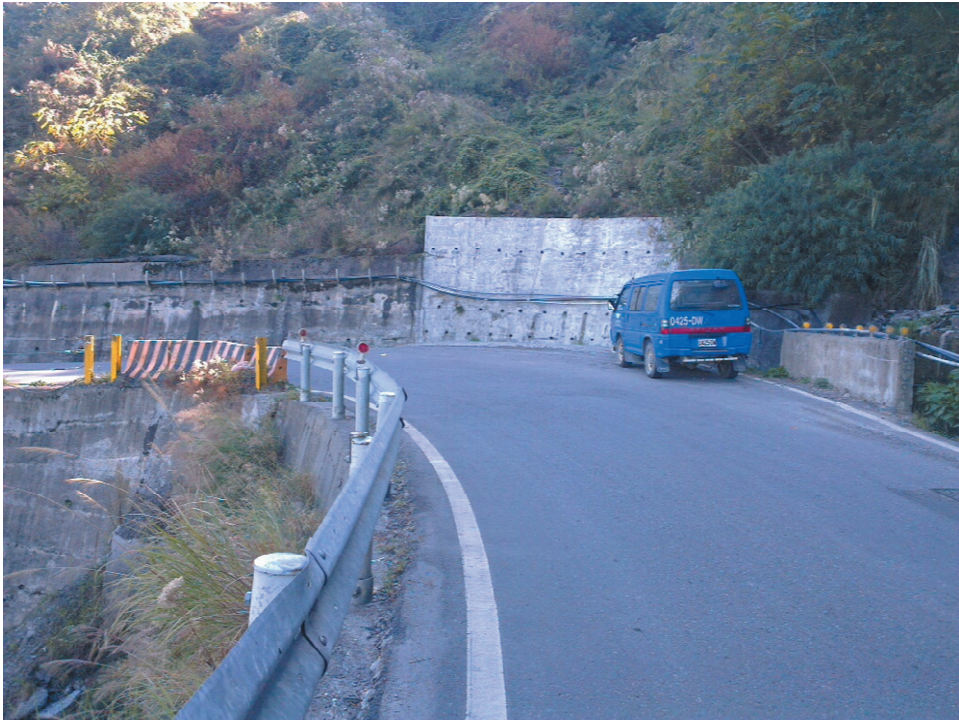
圖 5 台 8 線 82K-111K+950 邊坡現地確認
