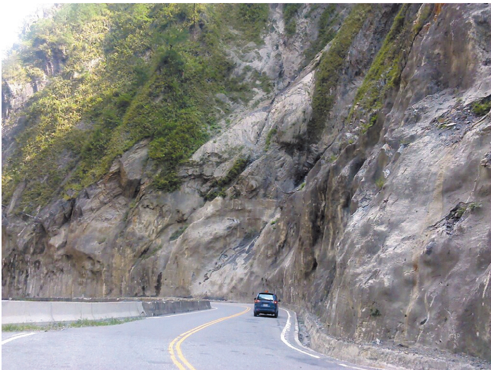
圖 6 台 20 線 182K+638-183K+005 邊坡現地確認
