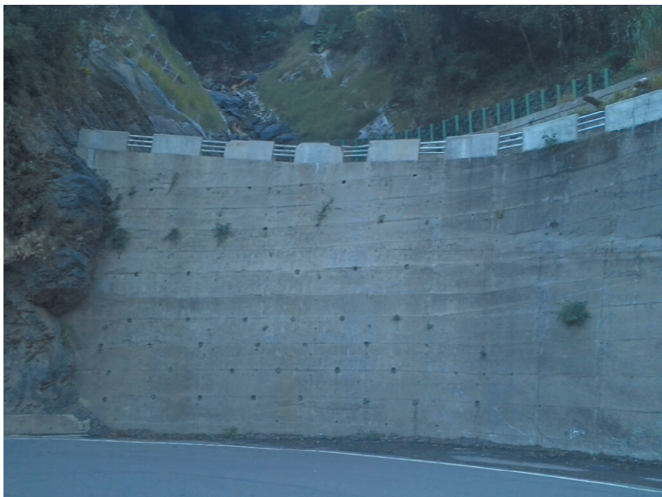
圖 4 台 7 線 32K+400-32K+500 邊坡現地確認
