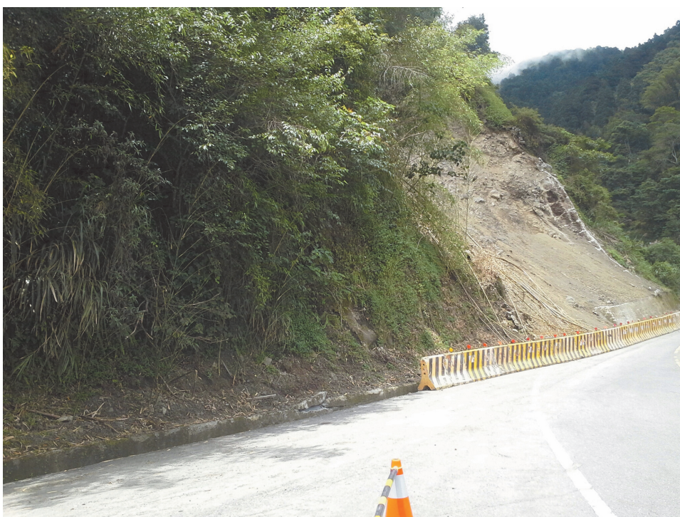
圖 8 台 9 線 77K+200-77K+300 邊坡現地確認
