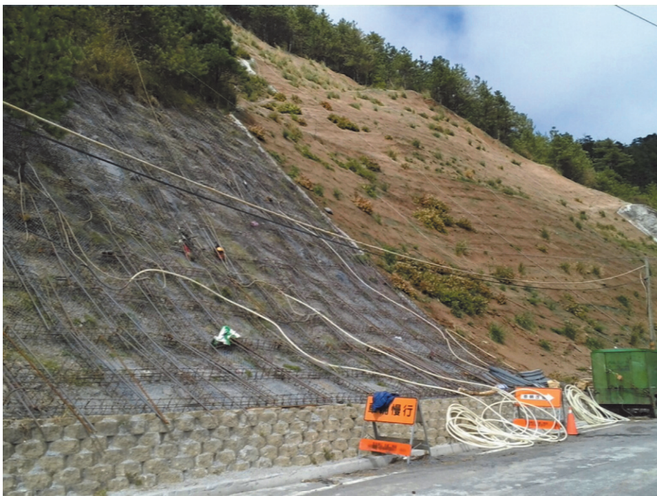
圖 7 台 14 甲線 41K+550-41K+670 邊坡現地確認
