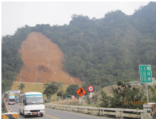
植生基材噴植完成(遠照)
