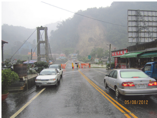
35K 坡面崩塌災害災後(正面遠照)
