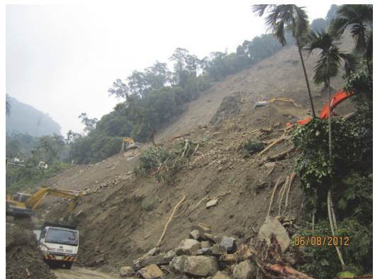
35K 坡面崩塌災害災後(側面近照)
