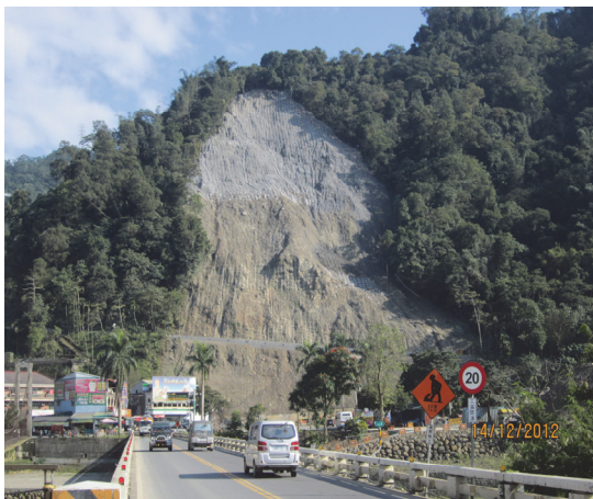
坡面掛網施工中(遠照)
