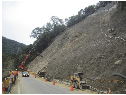
坡面主錨釘及灌漿土釘機械打設中
