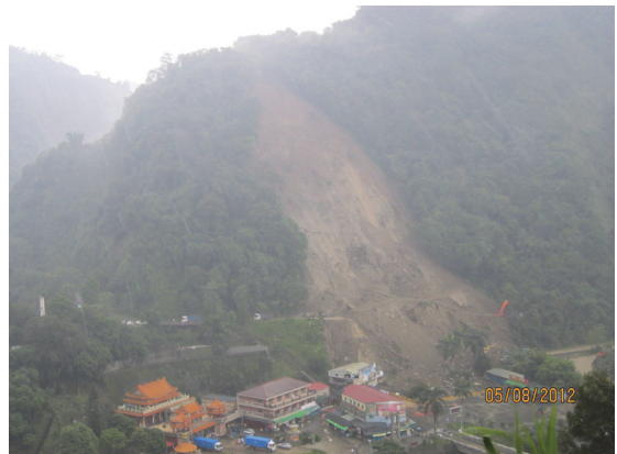
35K 坡面崩塌災害災後(側面遠照)
