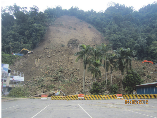
35K 坡面崩塌災害災後(正面近照)
