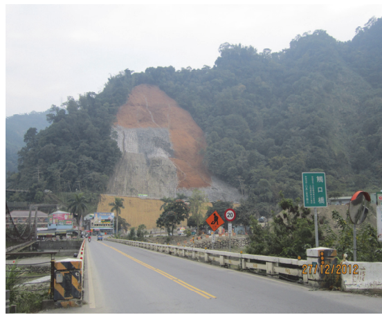
坡面植生基材施工中(遠照)
