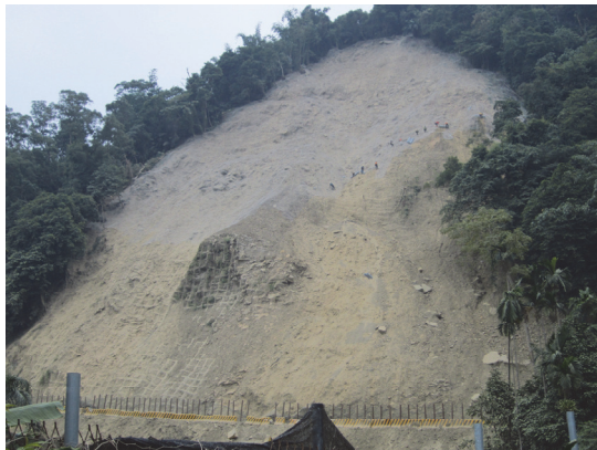
坡面掛網施工中
