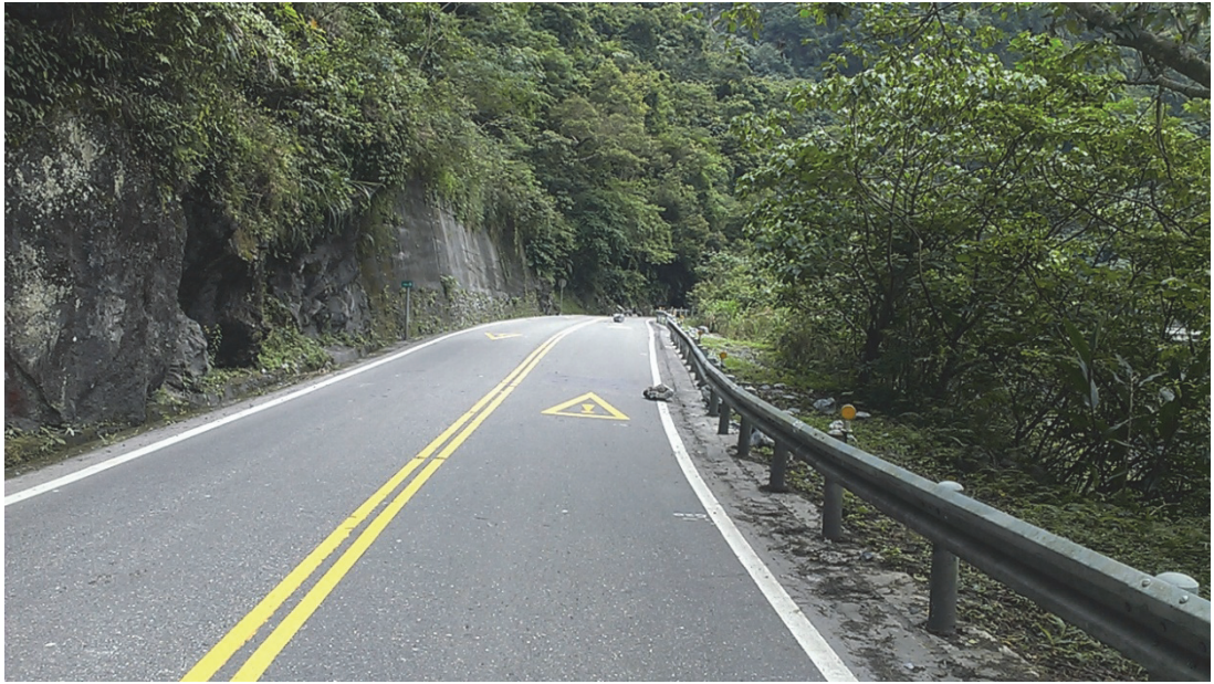
圖 5 民國 102 年 5 月 3 日掉落於台 8 線 181 k+600 附近的零星落石，路面小石塊已清除，遺留二顆直徑約 60 cm 石塊，為白沙橋路段大規模崩坍的前兆
