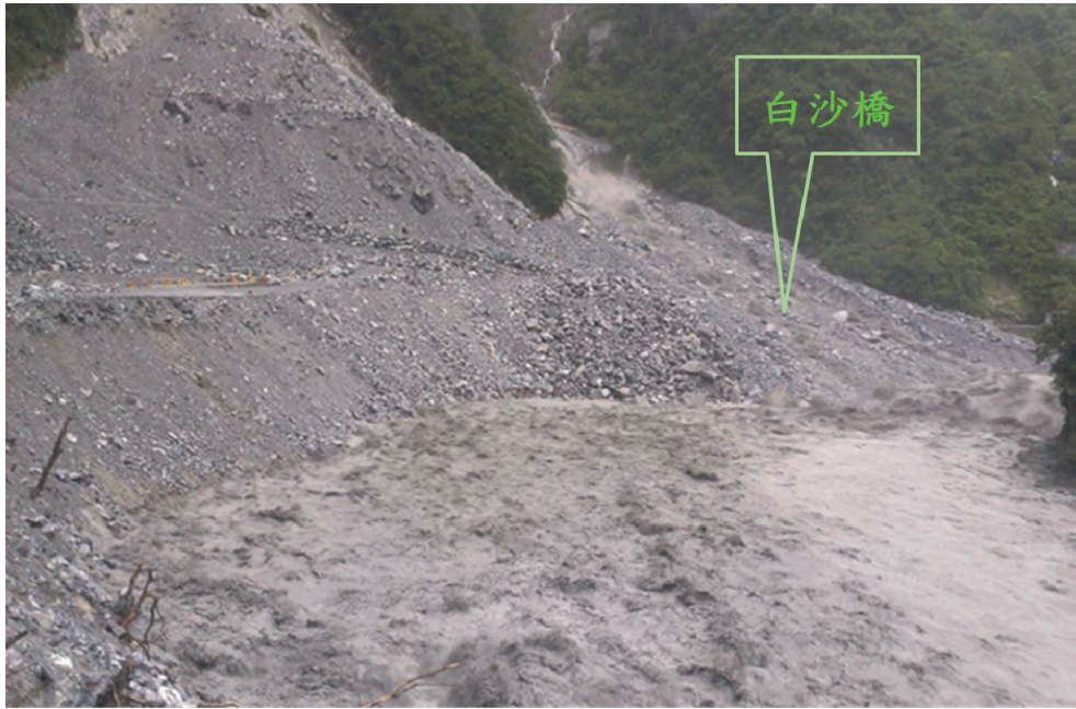
圖 16 民國 102 年 9 月 22 日上午 6 時白沙橋路段第二次大規模崩坍，白沙橋遭崩坍土石掩埋約 17 m
