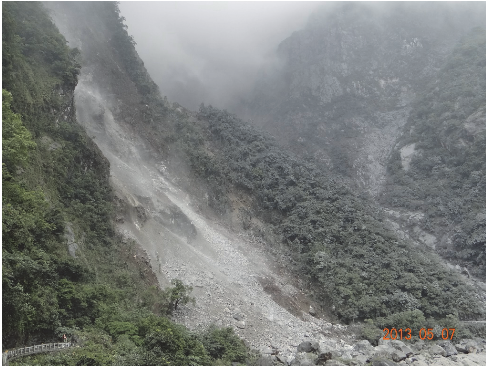
圖 8 民國 102 年 5 月 7 日上午 6 時公路上邊坡崩坍，坍方土石累計約 10,000 m 3 (拍攝自白沙橋路段東側)
