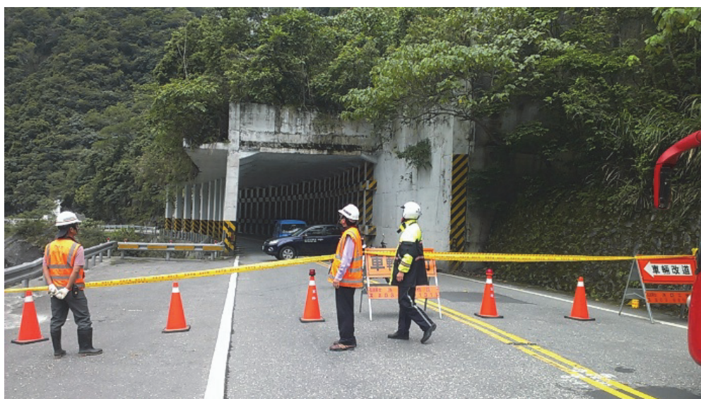
圖 19-1 第一次崩坍初期(102年5月3日12時15分)警力協助管制交通
