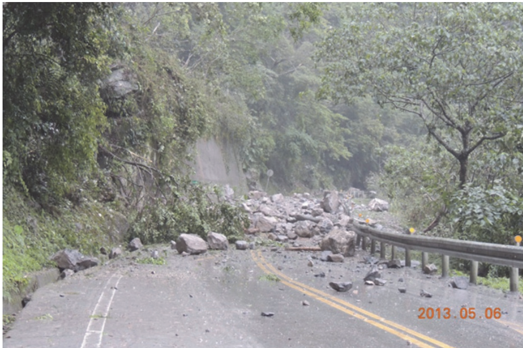
圖 7 民國 102 年 5 月 6 日上午 5 時 30 分邊坡崩坍逐漸接近公路，坍方土石約 700 m 3
