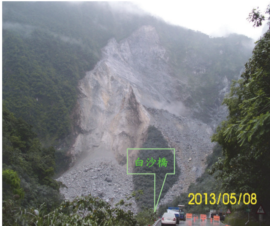
圖 10 民國 102 年 5 月 8 日上午 6 時公路上邊坡崩坍之崩崖，裸露坡面高逾 800 m (拍攝自白沙橋路段西(北)側)
