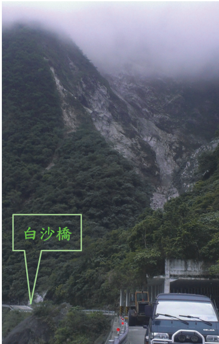
圖 20-2 公路崩坍坡面近千公尺高聳於雲霧之中(遠照)
