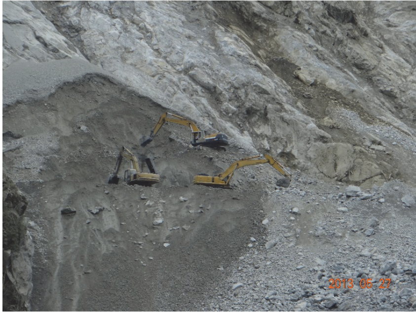
圖 24 坡頂平台淤滿後進行第二次土石清坍移除作業
