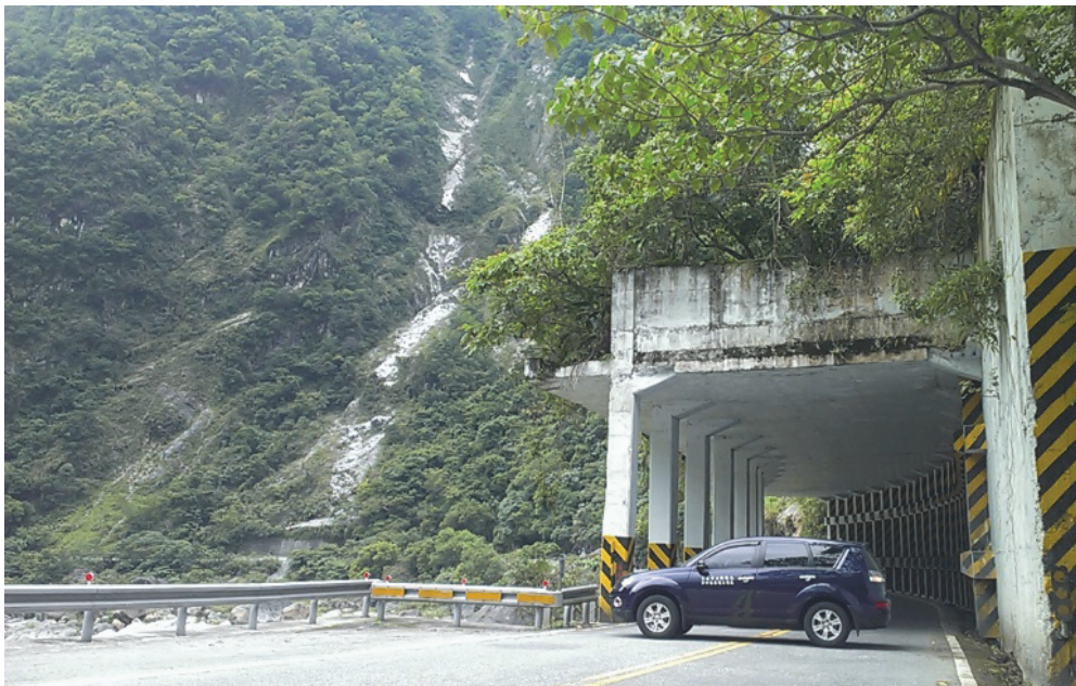
圖 18 第一次崩坍初期(102年5月3日11時55分)緊急交通管制
