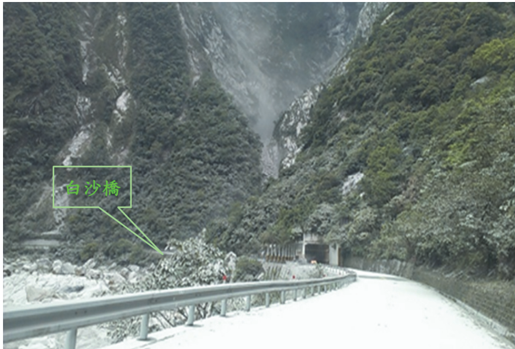
圖 6-2 台 8 線 181 k+100 崩坍後粉塵覆蓋路面情形
