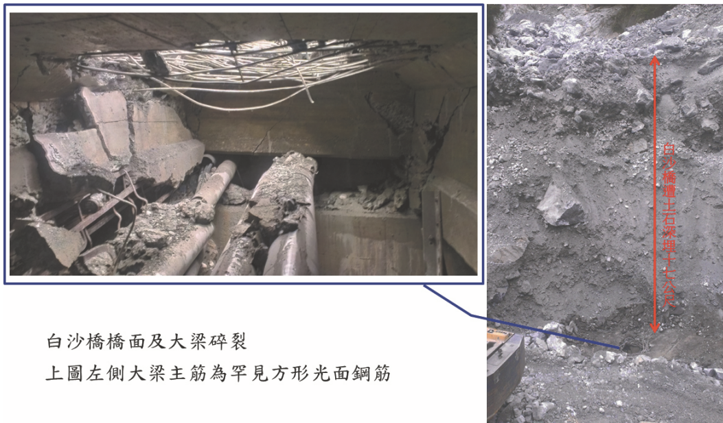
圖 17 崩坍土石衝擊荷重造成白沙橋大梁碎裂，左側大梁主筋為罕見的方形光面鋼筋
