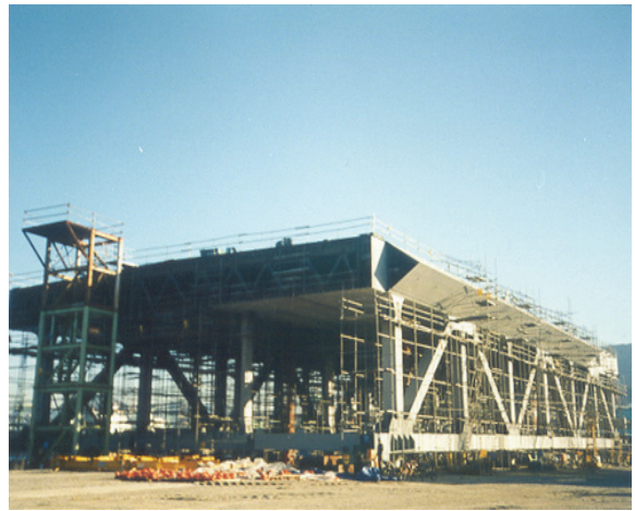
照片 16 分段組合(桁架橋)
