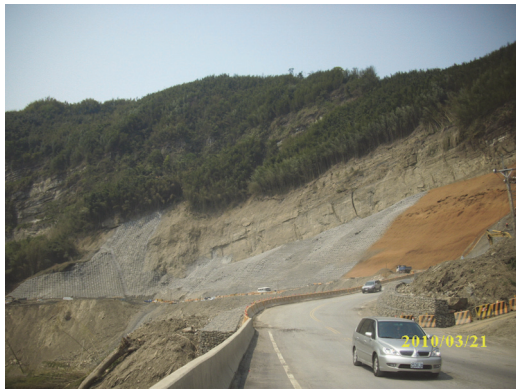
型框植生施工中
