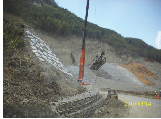
型框植生施工中
