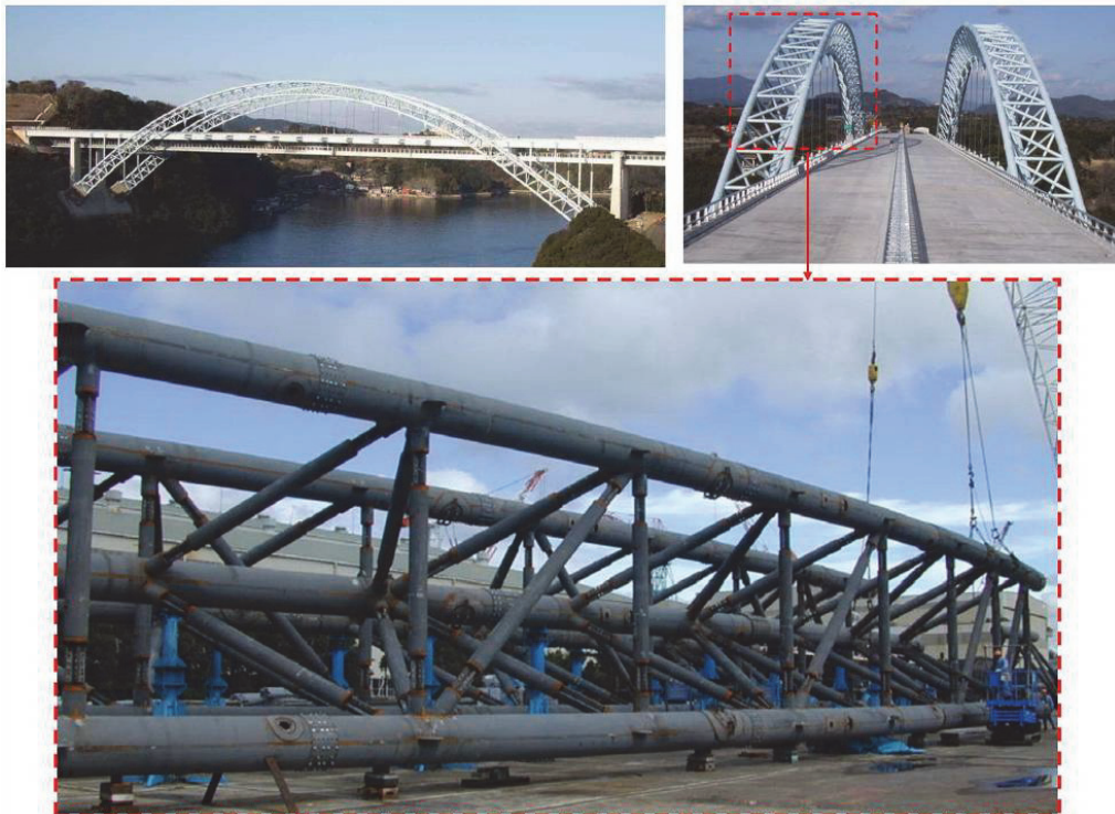
照片 8 橫向預裝(鋼管桁架橋)
