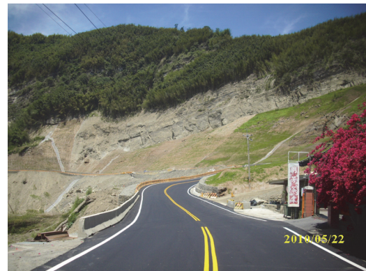
中期提升完工後
