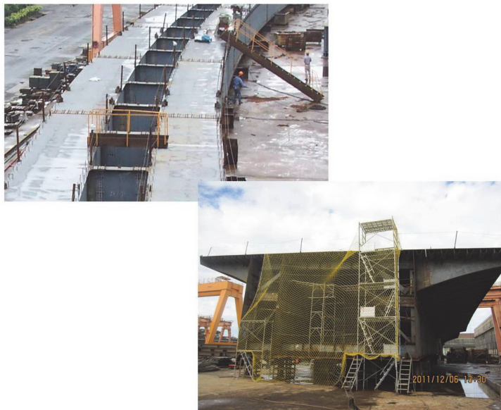
照片 41 上下設備與缺口防護設施(春源鋼構)
