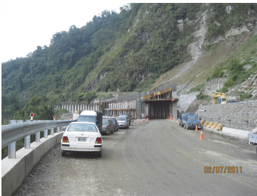
59K 明隧道施工中
