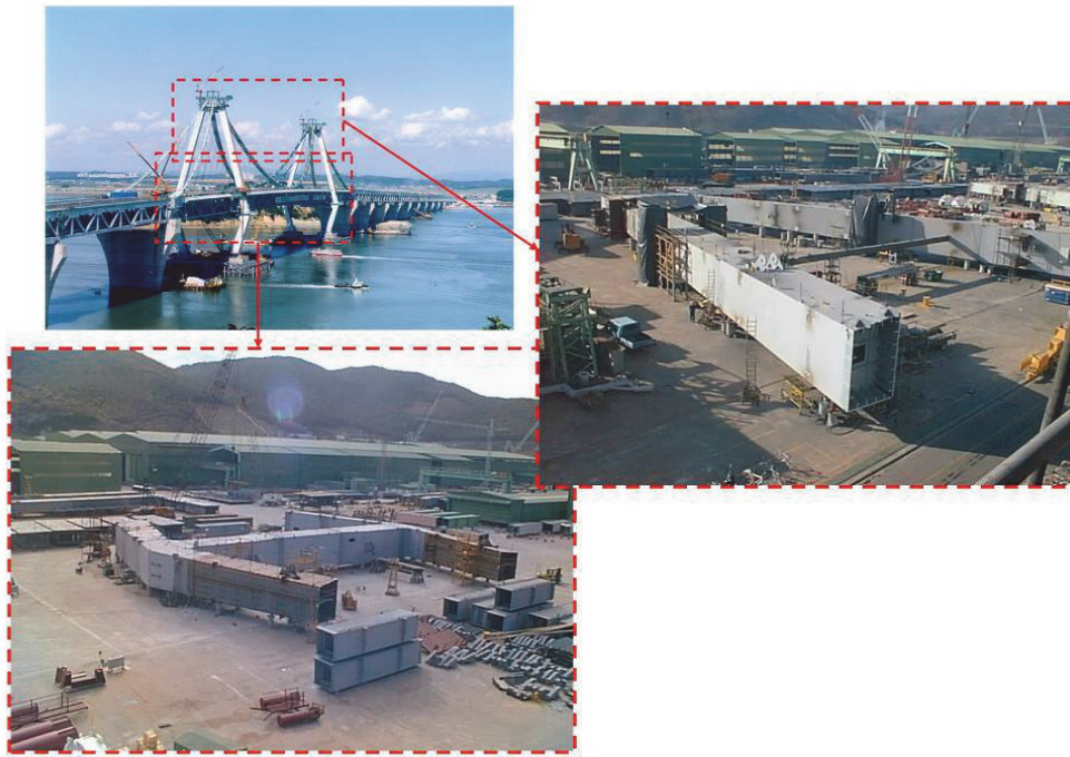
照片 10 橫向預裝(塔柱)
