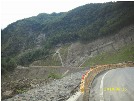
中期提升完工後
