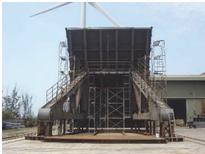
照片 3 溢洪道閘門 (大將作鋼構)
