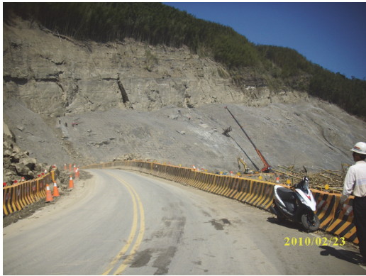
型框植生施工中
