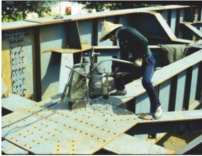
照片 5 斜撐構接頭以擴孔處理
