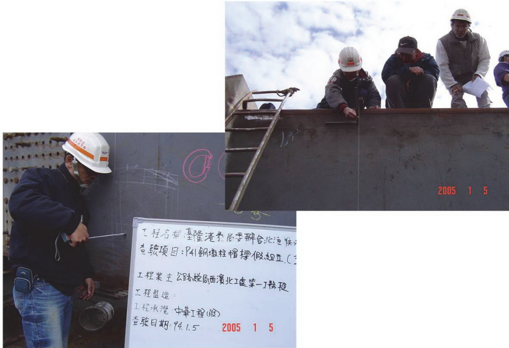
照片 44 主梁腹板正直度檢測(使用鋼琴線)
