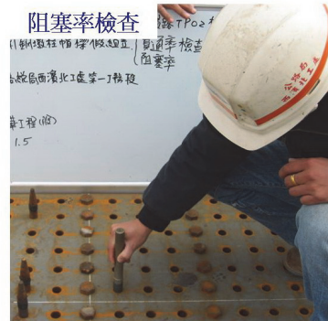
照片 31 螺栓孔貫通率及阻塞率檢查
