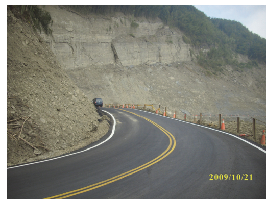
便道路面鋪設瀝青混凝土完成
