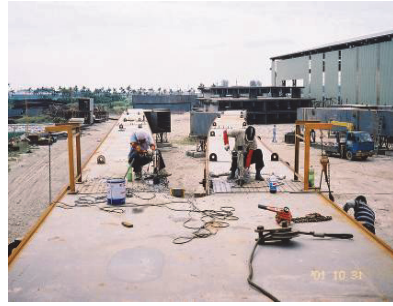
照片 6 拱橋接頭螺栓孔以引孔或擴孔處理
