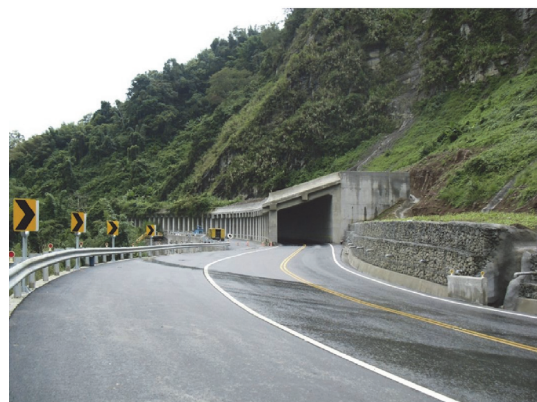
59K 明隧道敲除後採樁基礎施作完成
