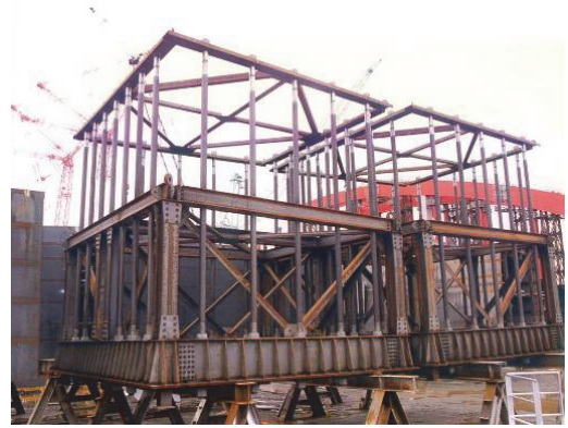
照片 21 鋼橋柱之錨錠構架
