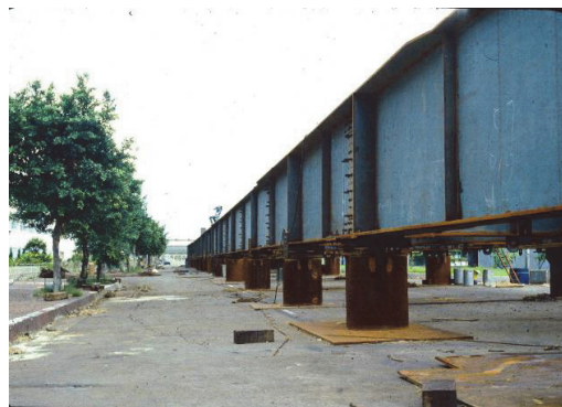
照片 25 穩固的支撐構件(關渡大橋)
