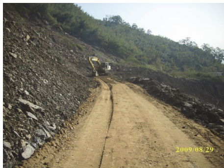
便道路基施工中
