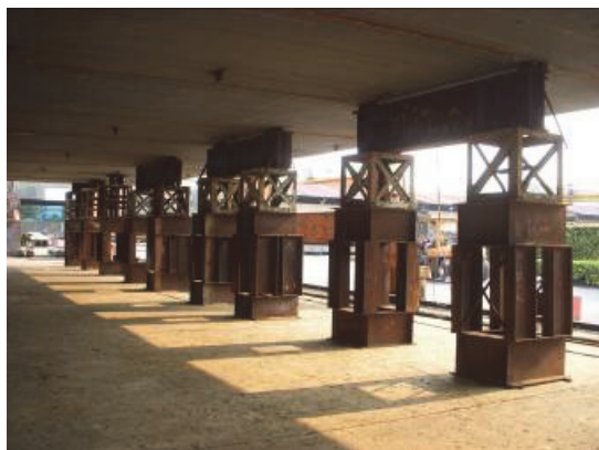
照片 26 構件採多點支撐(春源鋼構)
