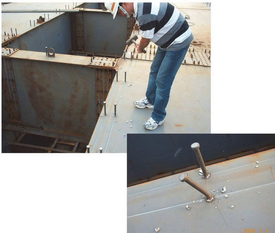
照片 47 剪力釘敲擊檢查
