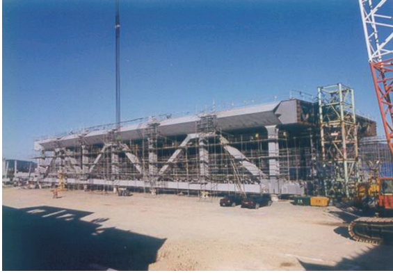
照片 20 吊橋之加勁桁架
