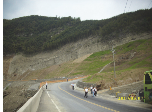
中期提升完工後
