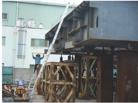
照片 42 主梁直線度及端部偏差檢測(春源鋼構、長榮鋼構)
