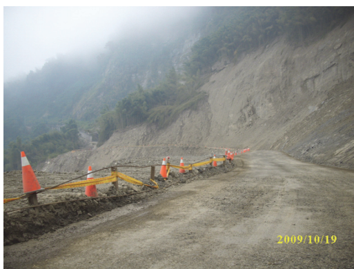
機械整坡完成後
