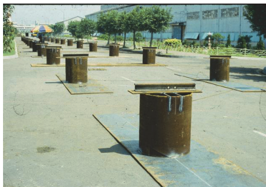
照片 24 穩固的支撐構件(關渡大橋)
