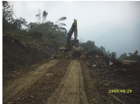
便道路基填塊石施工中
