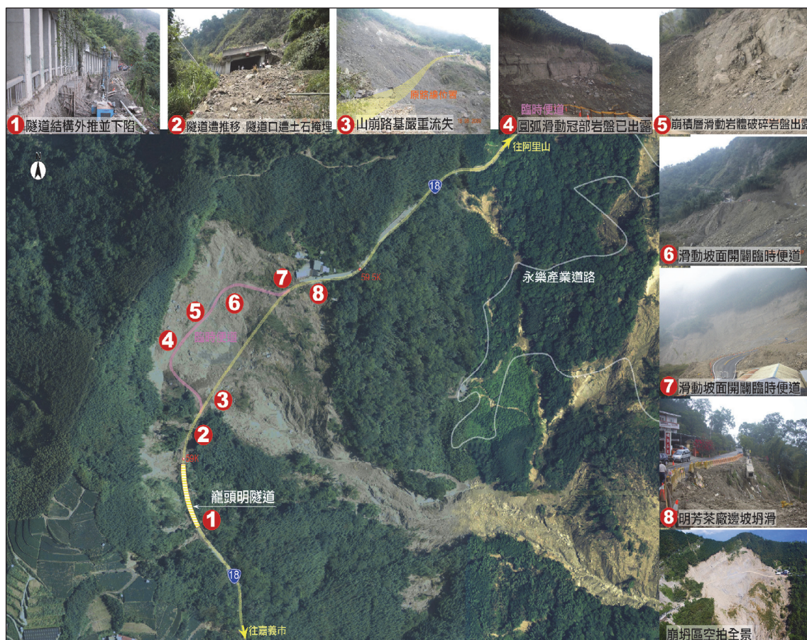
圖 3 阿里山公路 59.1k 附近崩坍災害現勘照片
