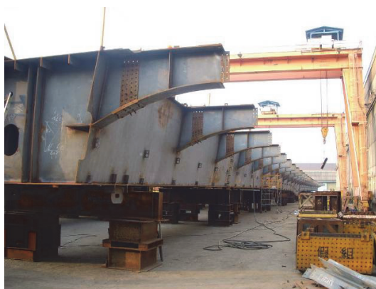
照片 27 構件採多點支撐(春源鋼構)
