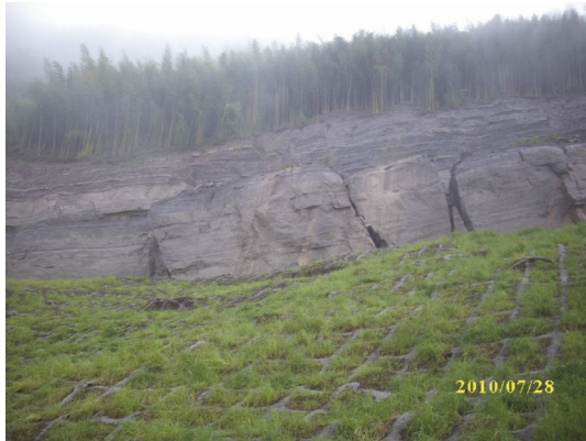
上邊坡岩盤翻倒破壞前
