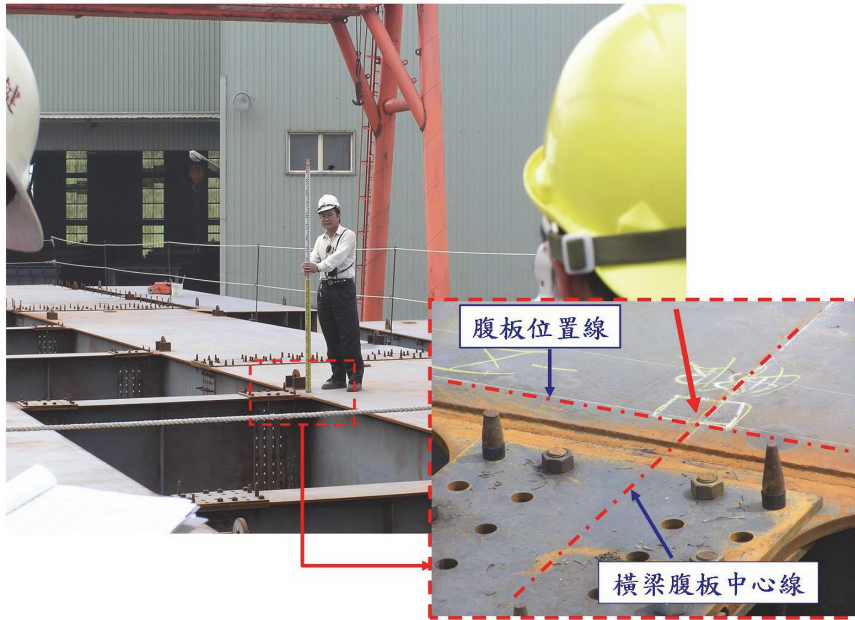
照片 40 主梁與橫梁銜接處高程檢測位置
