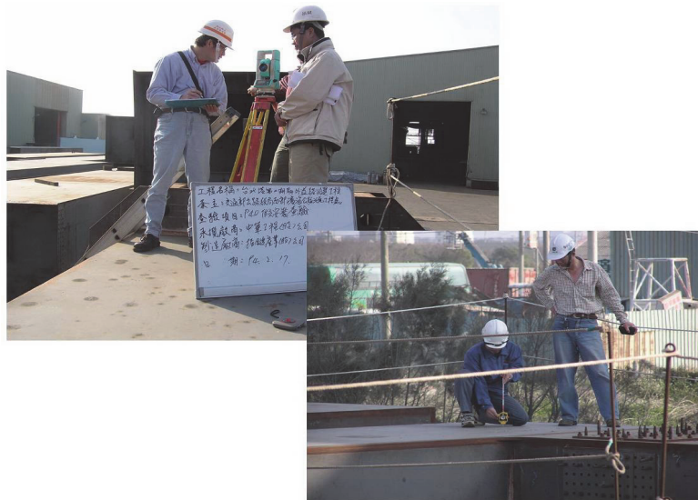
照片 34 預裝構件以光波測距儀量測
