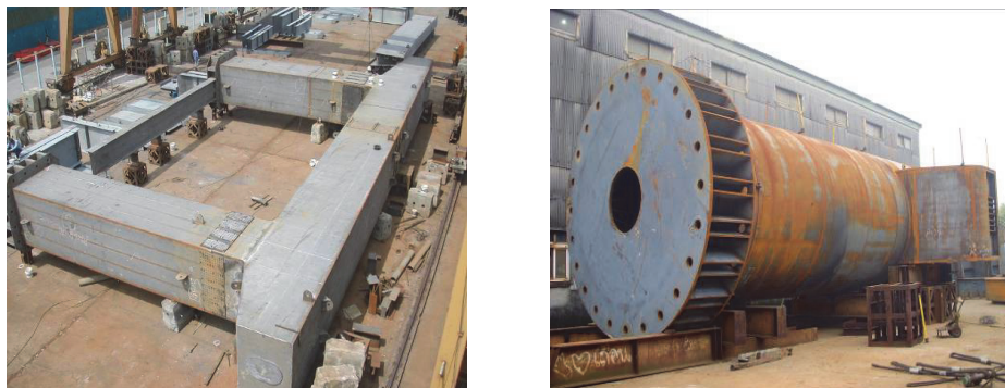
照片 9 橫向預裝(鋼墩柱)
