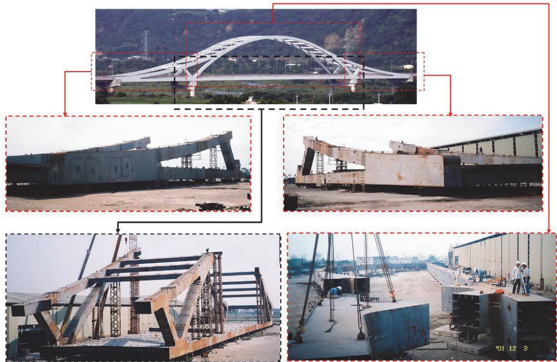
照片 17 台 4 線崧津大橋分段組合示意圖
