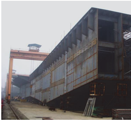
照片 15 分段組合(國道 1 號五楊段 高架橋-春源鋼構)
