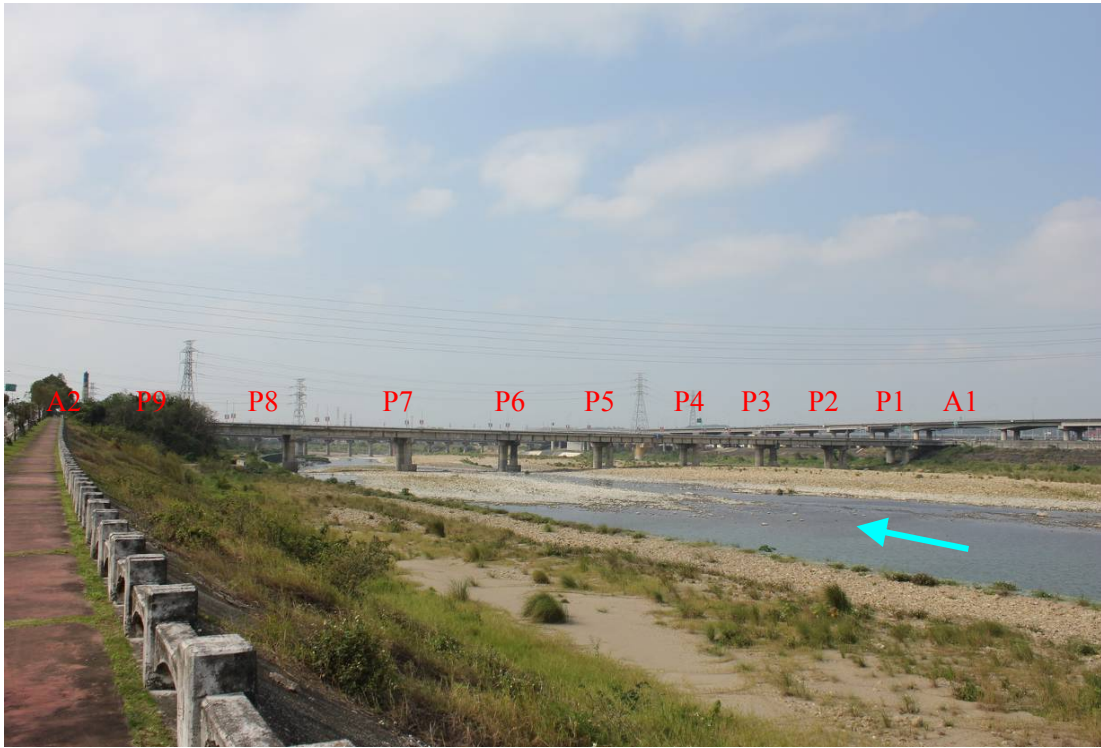
圖 1-2 北勢大橋跨越後龍溪之現況（102 年 3 月）
