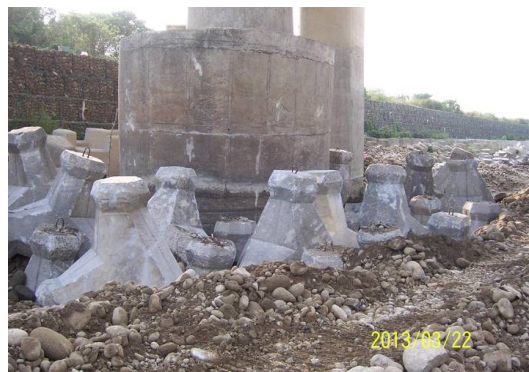
照片 3-3 P8 沉箱開挖、鋪不織布碎石夾層及吊放鼎塊情形
