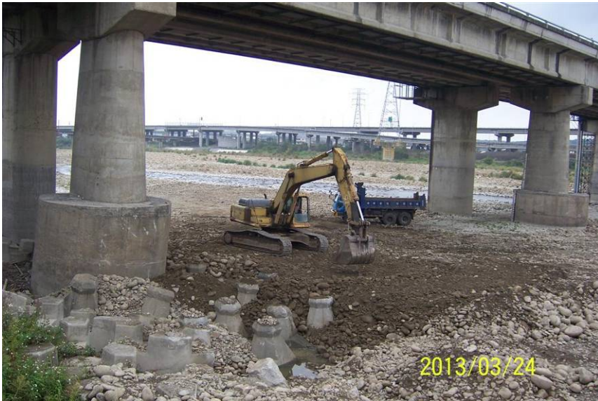
照片 3-5 北勢大橋 P8 沉箱保護工及 P7-P8 間沖刷磚埋設完成情形
