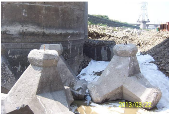
照片 3-3 P8 沉箱開挖、鋪不織布碎石夾層及吊放鼎塊情形
